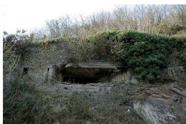
Vue des vestiges des fortifications d'agglomération de Brest au Moulin à poudre : casemate allemande pour canon de 47 mm antichars intégrée dans le mur défensif de la porte de la Brasserie Phot. Guillaume Lécueillier IVR53_20062904959NUCA
