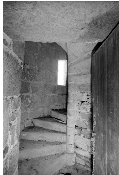
Porche sud : escalier de la tourelle Phot. Guy Artur IVR53_19712200231V
