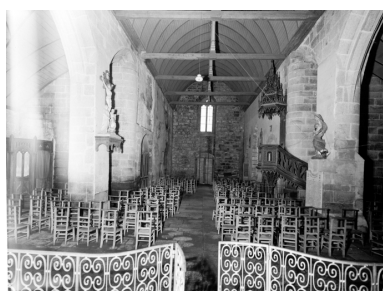
Intérieure : vue générale d'est en ouest Phot. François Dagorn IVR53_19682200112V
