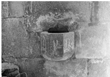
Bénitier à gauche de la porte du bas-côté sud Phot. François Dagorn IVR53_19712200230V
