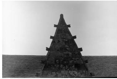
Bas-côté nord, fenêtre est : détail de l'écu Phot. Guy Artur IVR53_19712200299V
