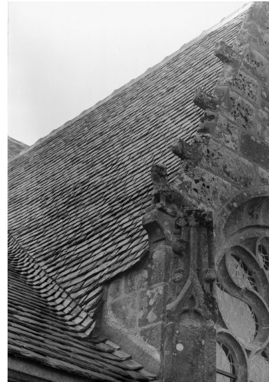
Bas-côté nord, fenêtre ouest : crossette sculptée, côté est Phot. Guy Artur IVR53_19712200298V
