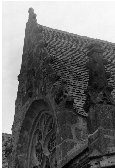
Bas-côté nord, fenêtre ouest : détail des animaux sculptés à la base du rampant - partie est Phot. François Dagorn IVR53_19712200242V
