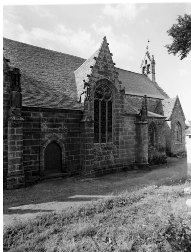
Face nord du bas-côté nord : gâble de la fenêtre ouest Phot. François Dagorn IVR53_19682200094V
