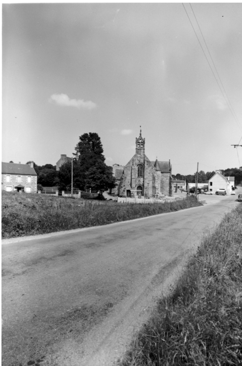
Vue de situation prise de l'ouest
