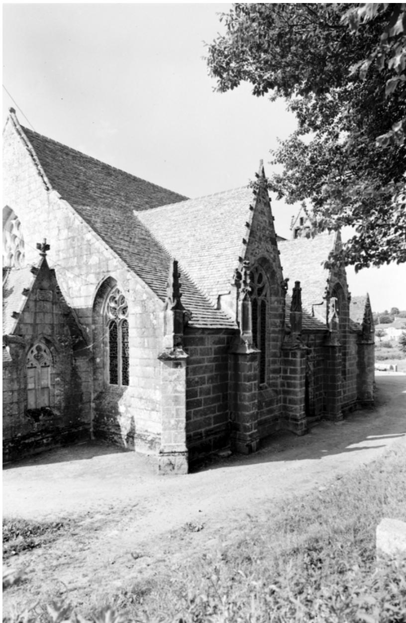
Face nord du bas-côté nord : vue générale
