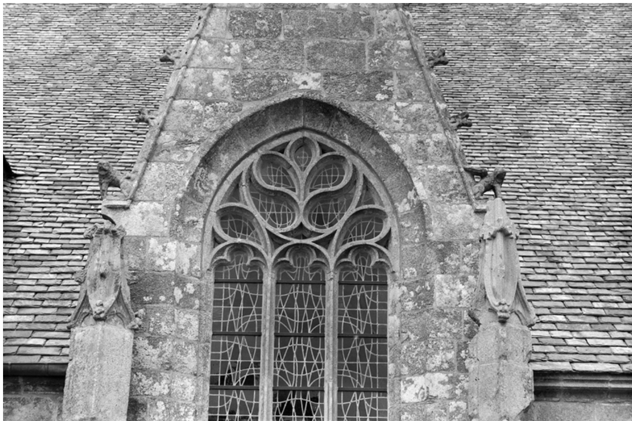
Fenêtre ouest du bas-côté sud : crossettes sculptées
