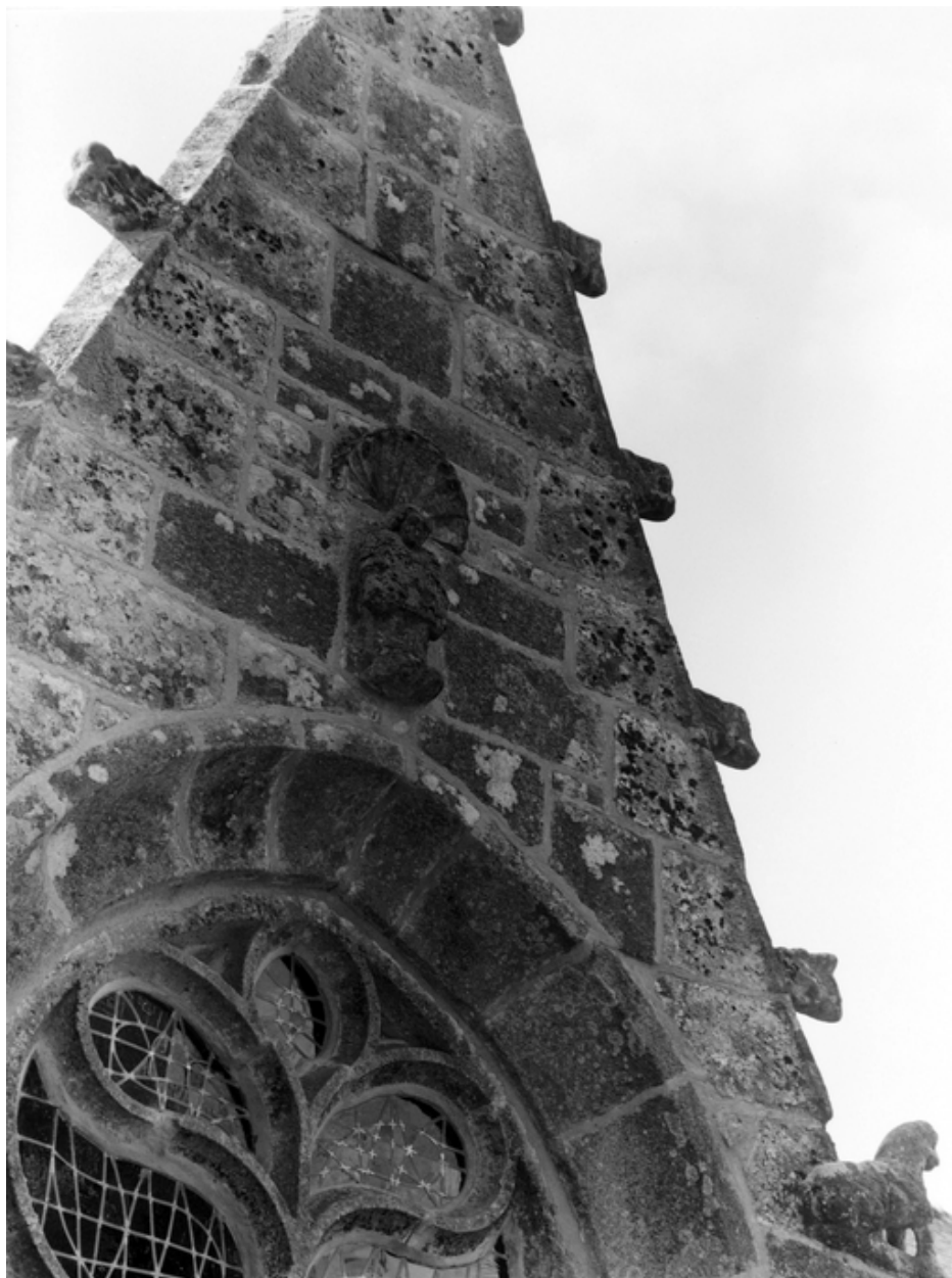
Fenêtre ouest du bas-côté nord, détail : statuette sous un dais à coquille
