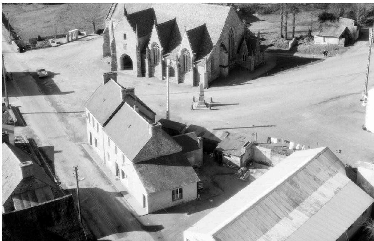
Vue aérienne prise du sud est
