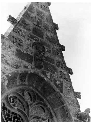
Fenêtre ouest du bas- côté nord, détail : statuette sous un dais à coquille Phot. François Dagorn IVR53_19682200098V
