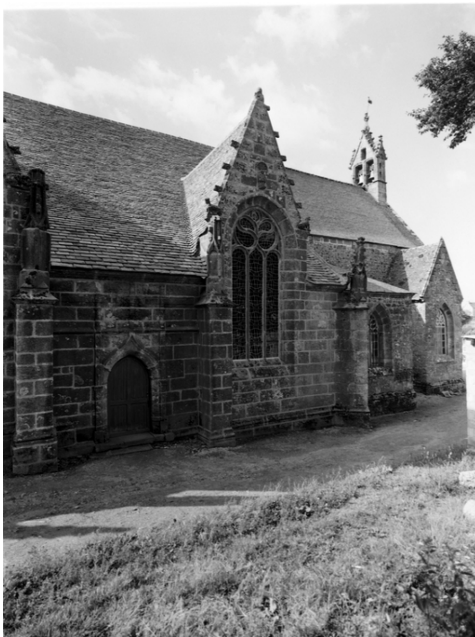
Face nord du bas-côté nord : gâble de la fenêtre ouest
