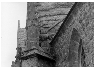
Mur ouest du bas-côté nord : détail de l'animal sculpté à la base du rampant Phot. François Dagorn IVR53_19712200241V
