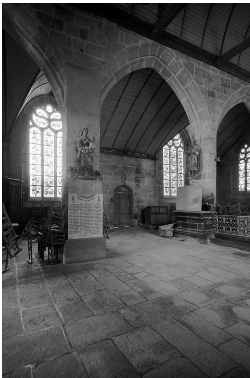
Arcades ouvrant sur le bas-côté nord
