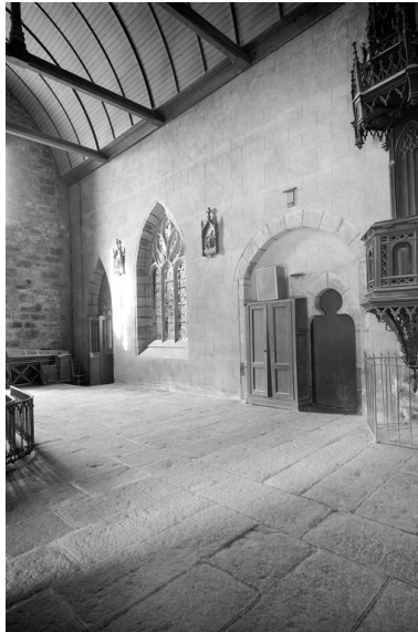
Partie occidentale de la nef, mur nord Phot. Guy Artur IVR53_19712200235V
