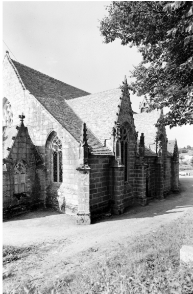
Face nord du bas- côté nord : vue générale Phot. François Dagorn IVR53_19682200092V
