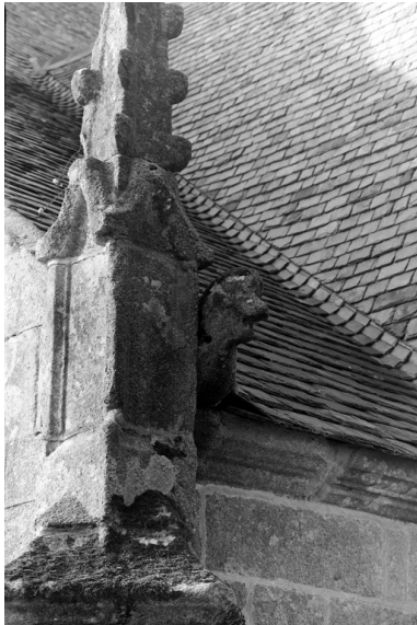
Chevet, rampant nord : crossette sculptée Phot. Guy Artur IVR53_19712200296V
