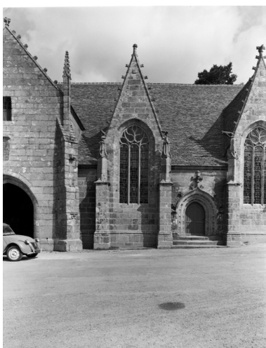
Gâble et pierres d'assises historiées de la fenêtre ouest du bas-côté sud Phot. François Dagorn
