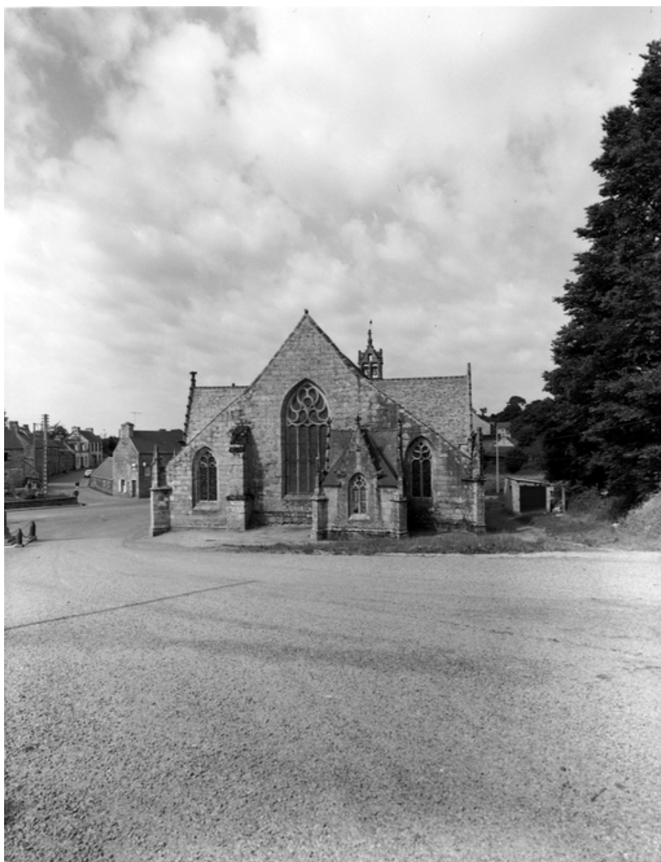
Face est : vue d'ensemble
