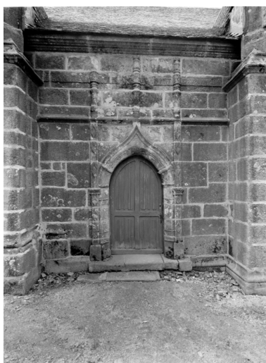
Face nord du bas-côté nord : porte Phot. François Dagorn IVR53_19682200095V
