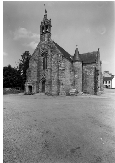
Vue générale prise du sud ouest Phot. François Dagorn IVR53_19682200081V
