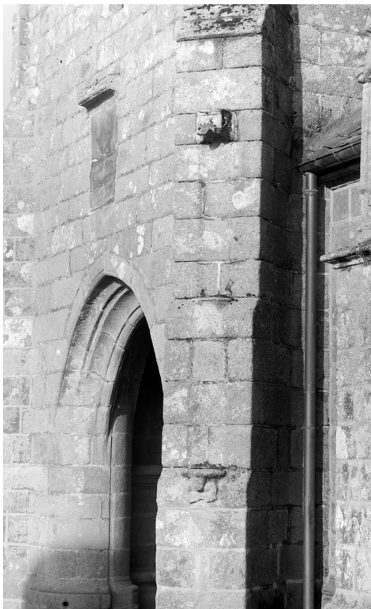
Porche sud, détail : niches à dais du contrefort sud est
