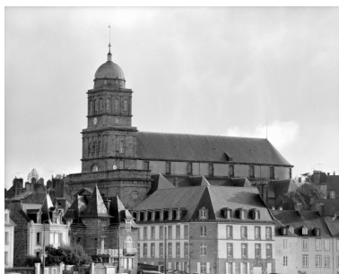
Elévation Ouest : vue générale Phot. Guy Artur, Phot. Norbert Lambart IVR53_19943502429X
