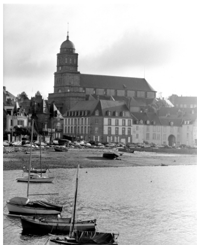
Elévation Ouest : vue générale Phot. Guy Artur, Phot. Norbert Lambart IVR53_19943502405X
