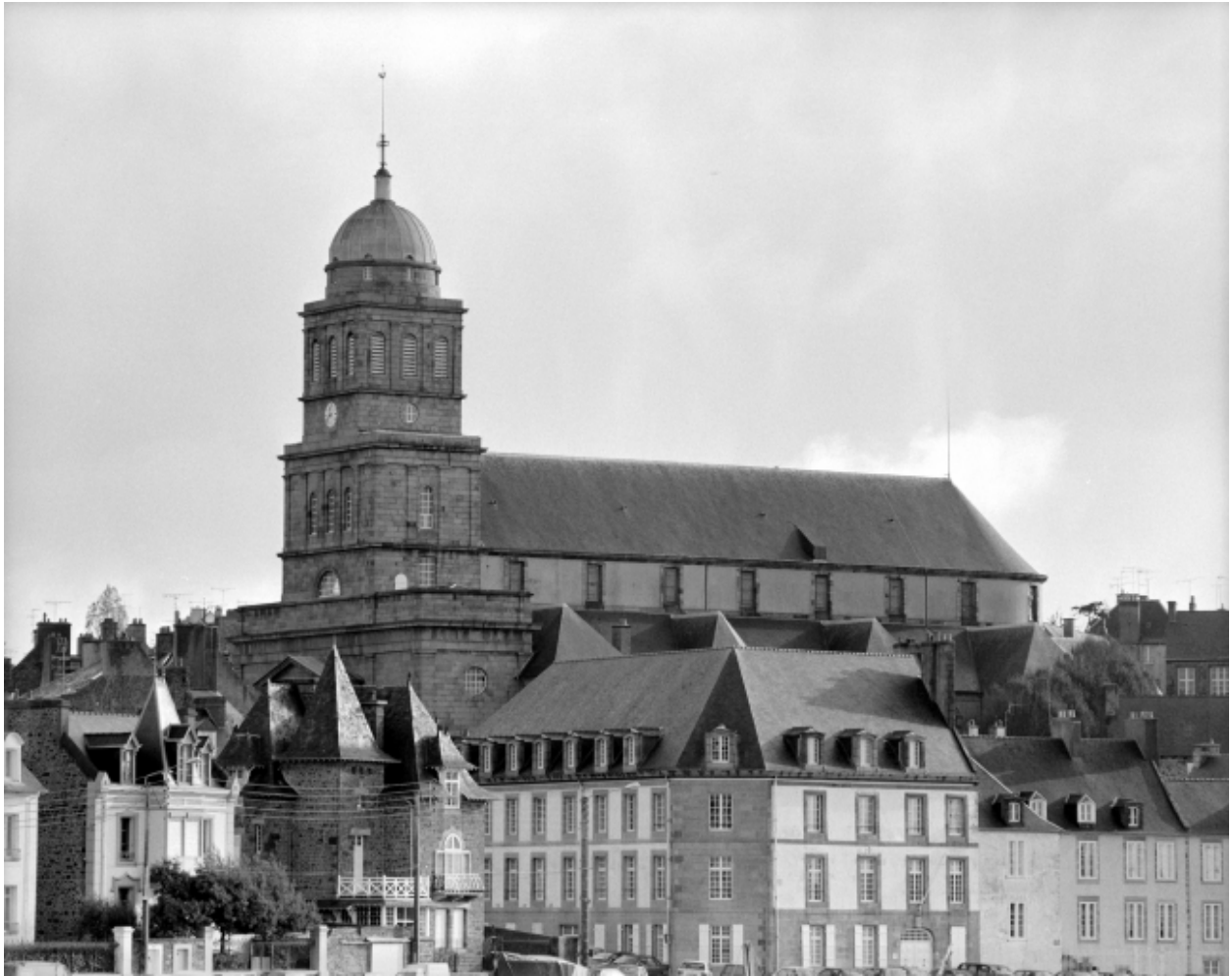
Elévation Ouest : vue générale
