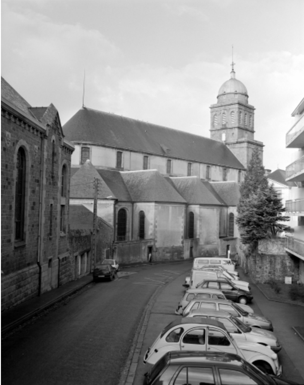
Elévation Sud-Ouest : vue générale
