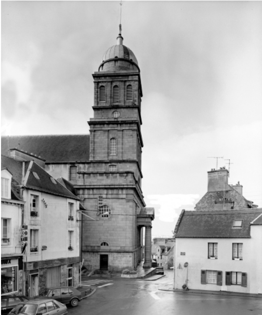
Elévation Sud-Ouest : vue générale
