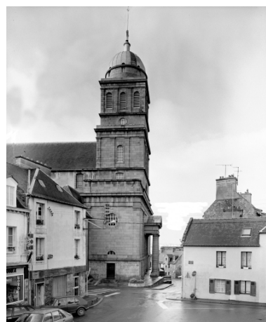
Elévation Sud-Ouest : vue générale Phot. Guy Artur, Phot. Norbert Lambart IVR53_19943502403V
