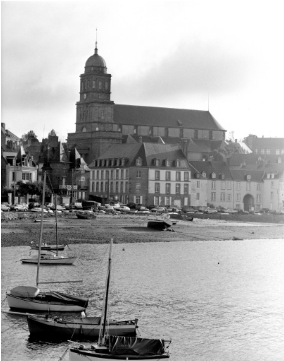
Elévation Ouest : vue générale
