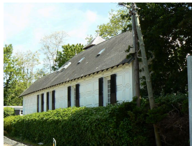
Vue latérale de la villa Ker Ar Bruck Phot. Johan Vincent IVR53_20072908708NUCA
