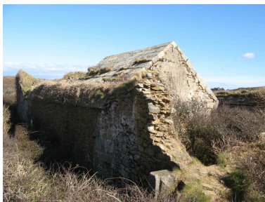
Magasin à poudre du fort de la Fraternité Phot. Guillaume Marie IVR53_20082908465NUCA
