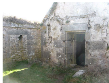
Magasin à poudre du fort de la Fraternité Phot. Guillaume Marie IVR53_20082908464NUCA
