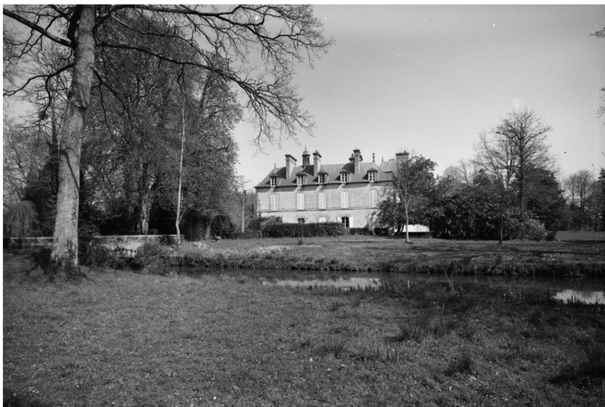
Vue générale, façade sud.
