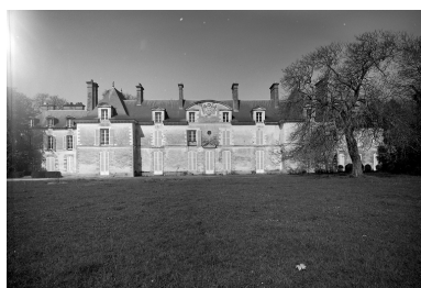
Vue générale, façade est. Phot. Guy Artur IVR53_19683500159V
