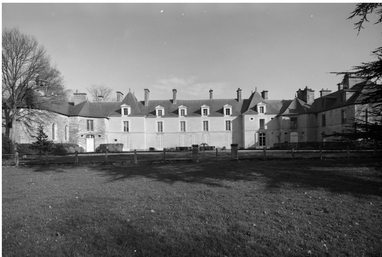
Vue générale, façade ouest.
