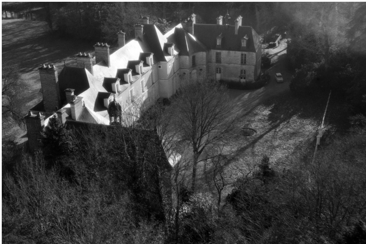
Vue aérienne vers le sud.
