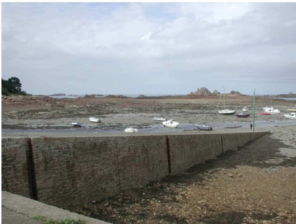
Vue de la cale : remarquer la forte pente et les murs de quais en moellons
