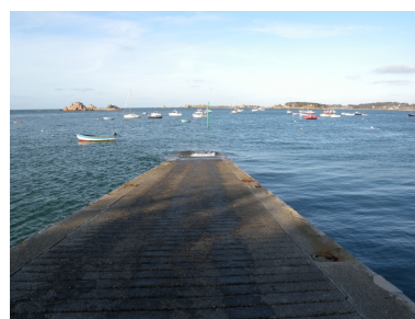
Vue du vaigrage en ciment de la cale Phot. Guy Prigent IVR53_20082211094NUCA
