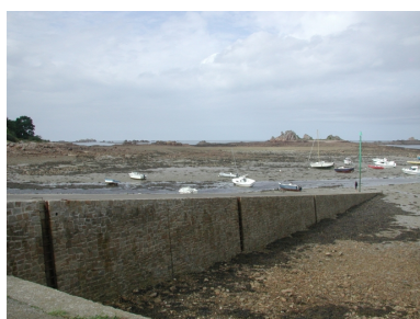
Vue de la cale : remarquer la forte pente et les murs de quais en moellons Phot. Guy Prigent IVR53_20082211095NUCA
