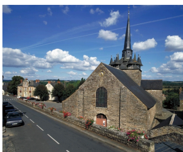
Elévation ouest : vue générale Phot. Guy Artur, Phot. Norbert Lambart IVR53_20013501893XA
