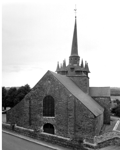
Elévation ouest : vue générale Phot. Guy Artur, Phot. Norbert Lambart IVR53_19943501739X
