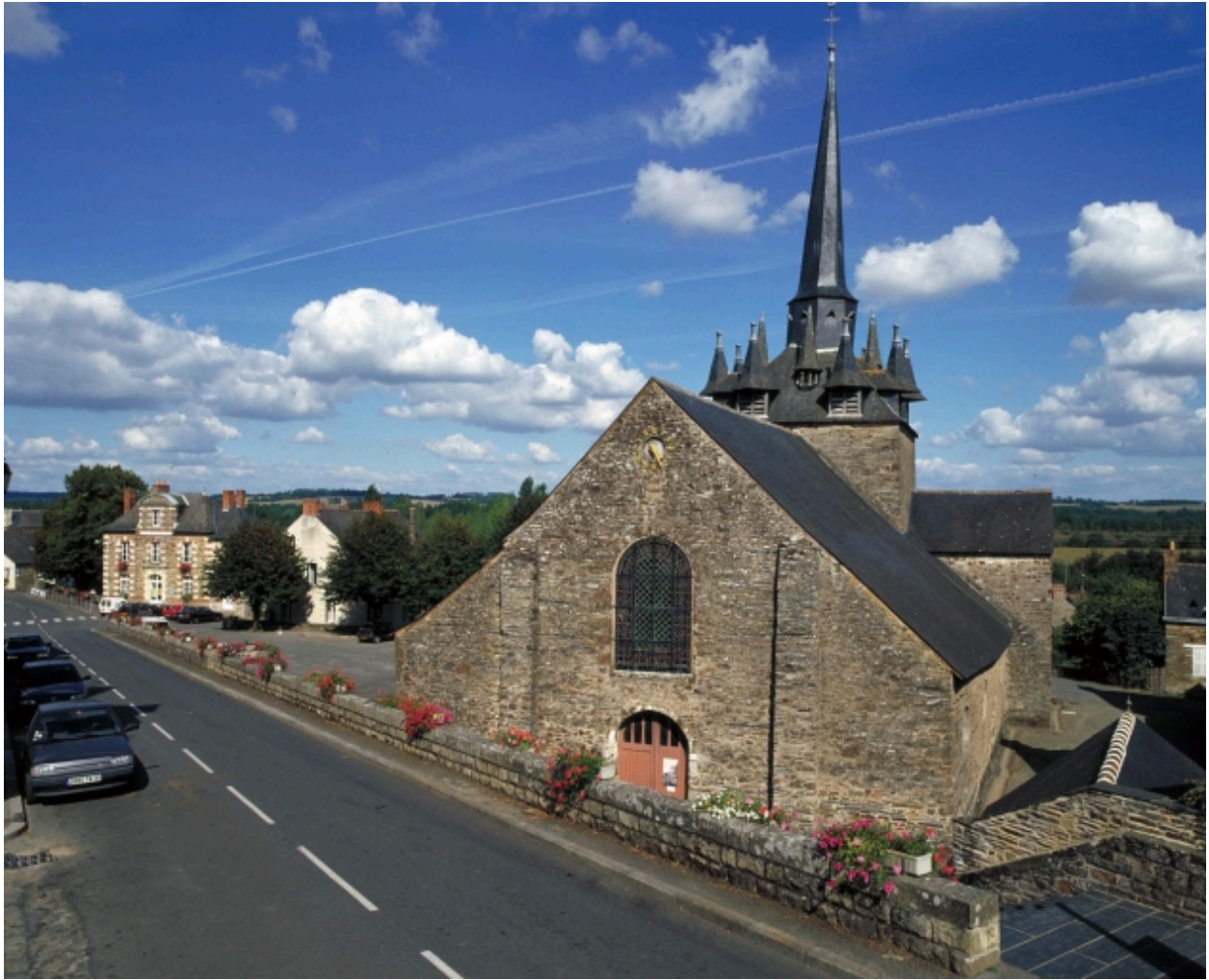
Elévation ouest : vue générale
