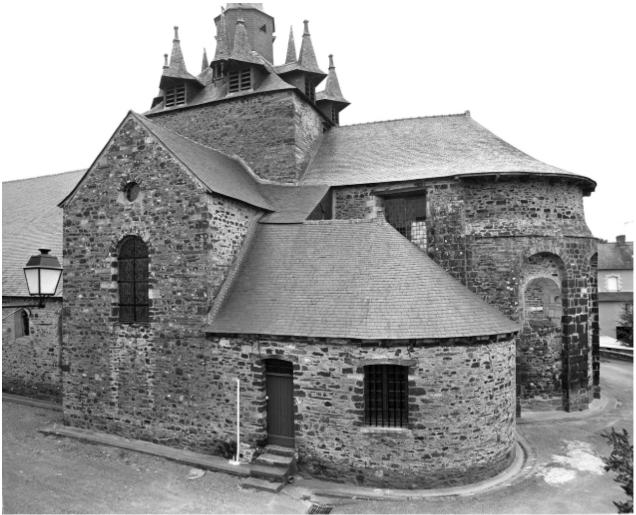
Elévation sud, partie ouest : vue générale
