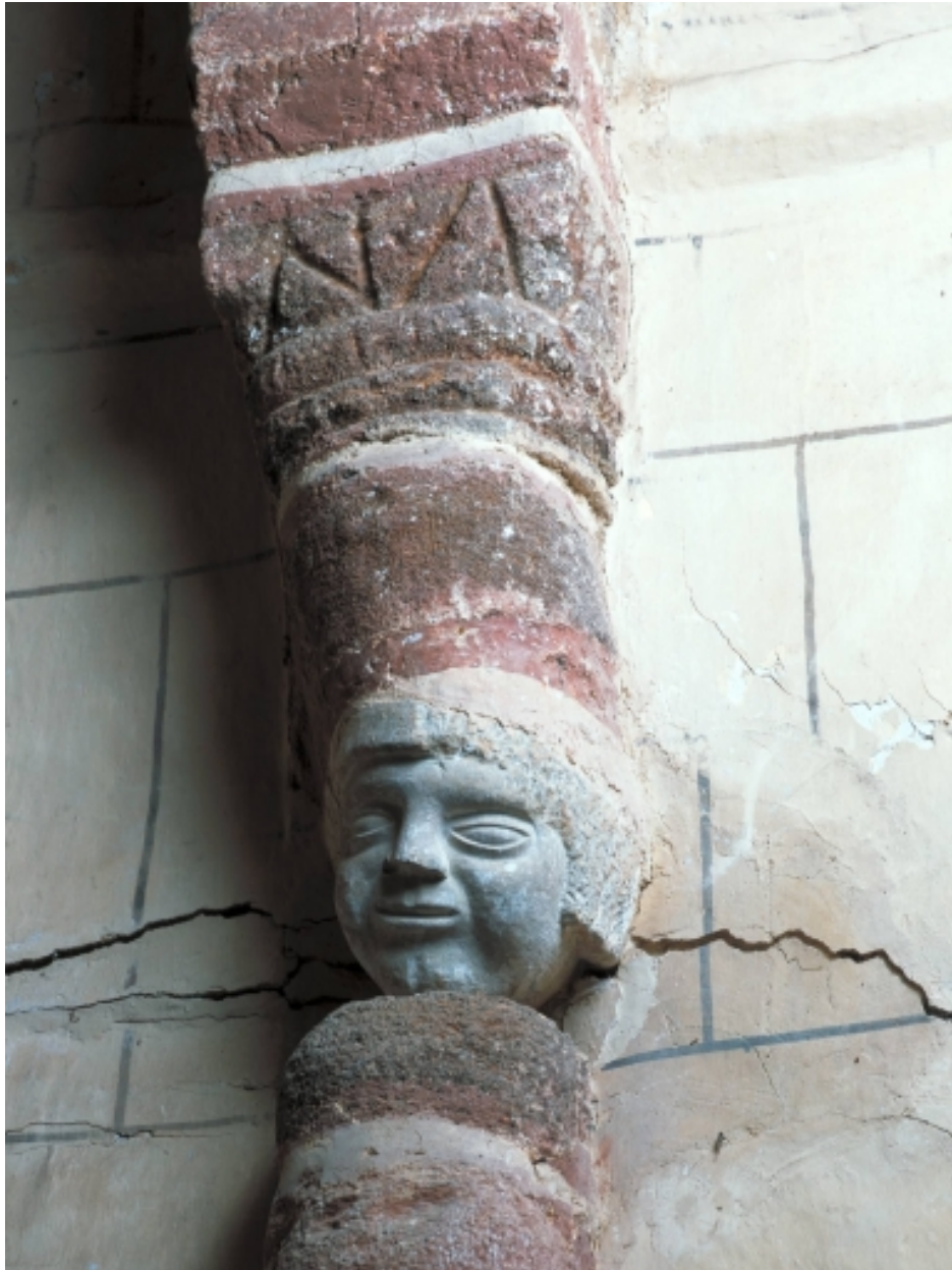
Détail de la chapelle nord : colonne et chapiteau sculptés
