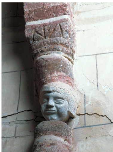
Détail de la chapelle nord : colonne et chapiteau sculptés Phot. Bernard Bègne IVR53_20013501612XA
