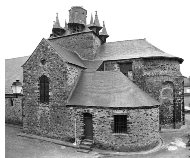
Elévation sud, partie ouest : vue générale Phot. Guy Artur, Phot. Norbert Lambart IVR53_19943501741X
