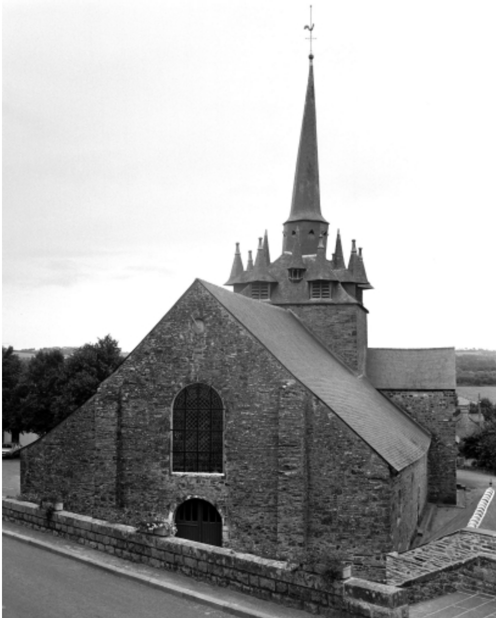
Elévation ouest : vue générale
