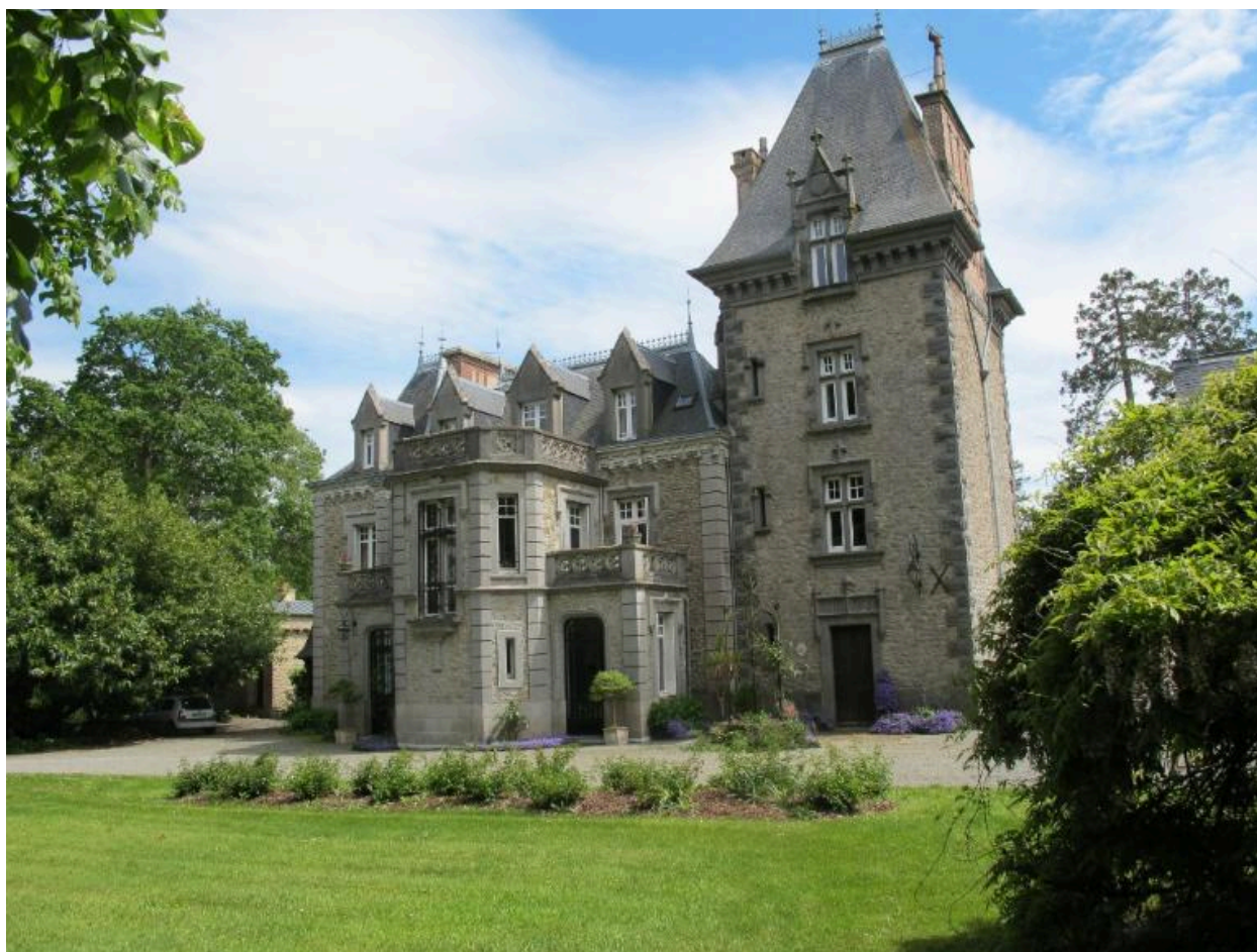
Facade antérieure, prise de trois quart
