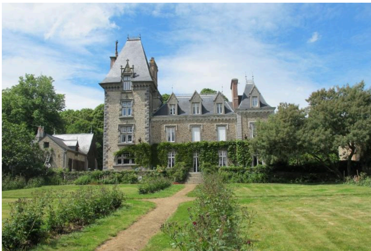
Façade arrière, vue générale
