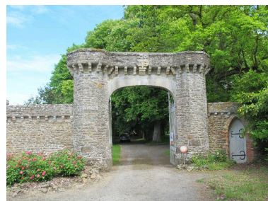
Enclos et portail d'entrée Phot. Véronique Orain IVR53_20172206245NUCA
