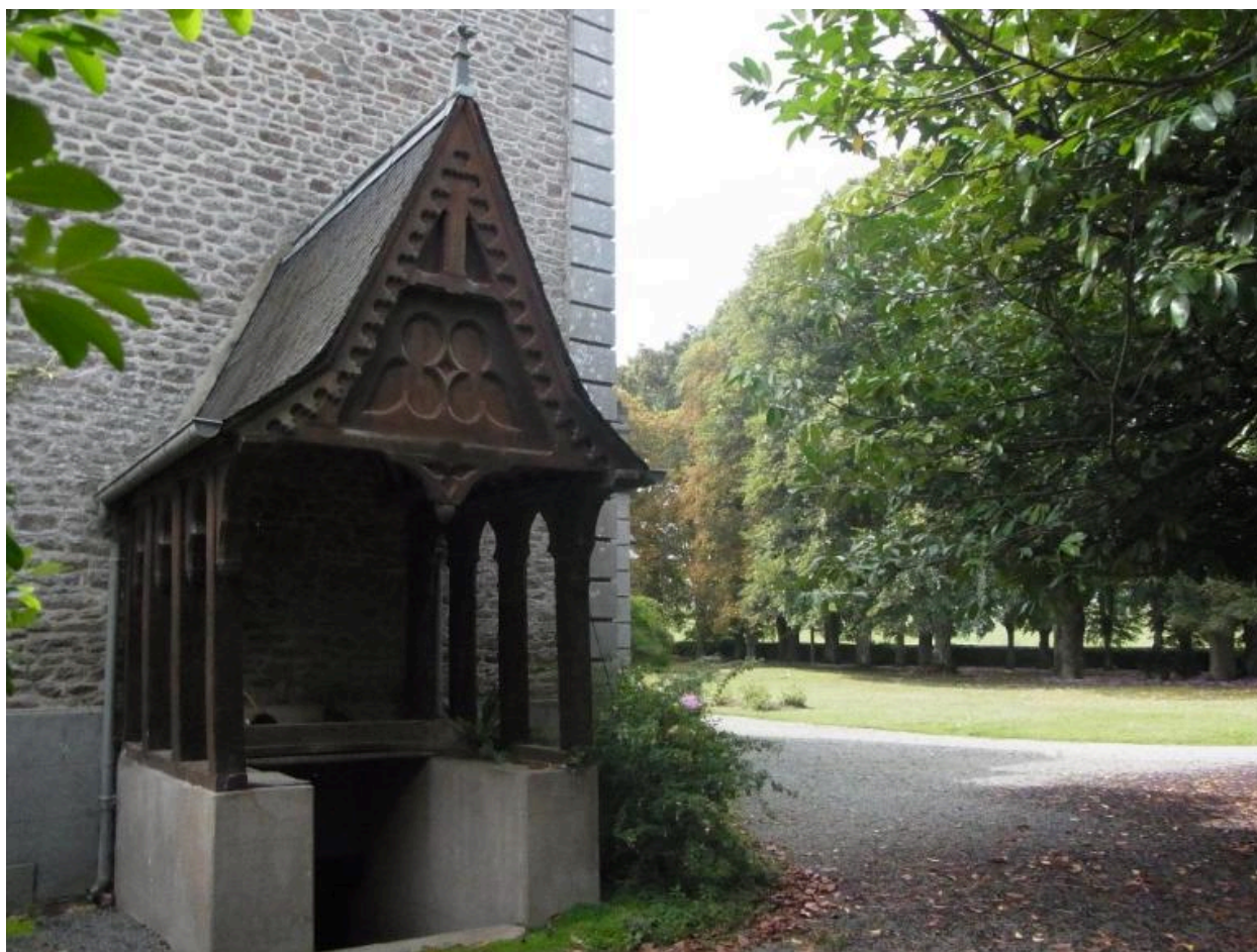
Entrée de cave, remploi probable de l'ancienne entrée de la façade antérieure
