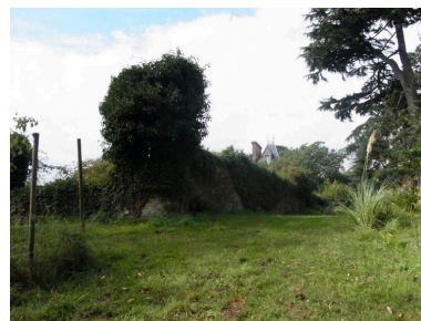
Enclos du jardin, avec tourelle d'angle en ruines Phot. Véronique Orain IVR53_20172206262NUCA
