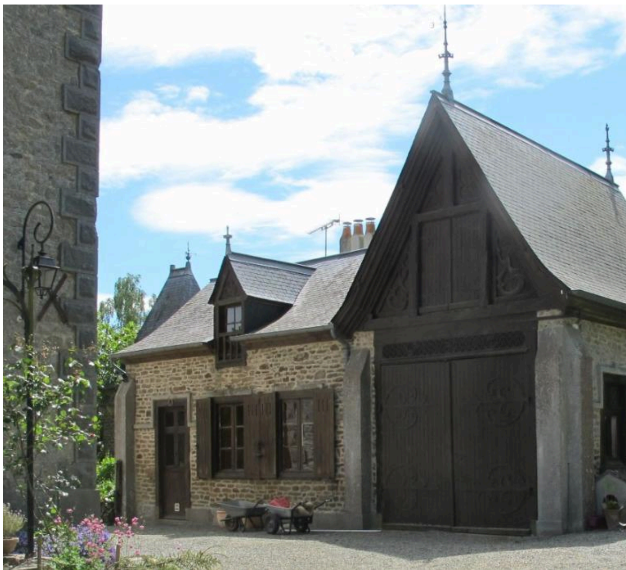
Ancienne écurie et remise
