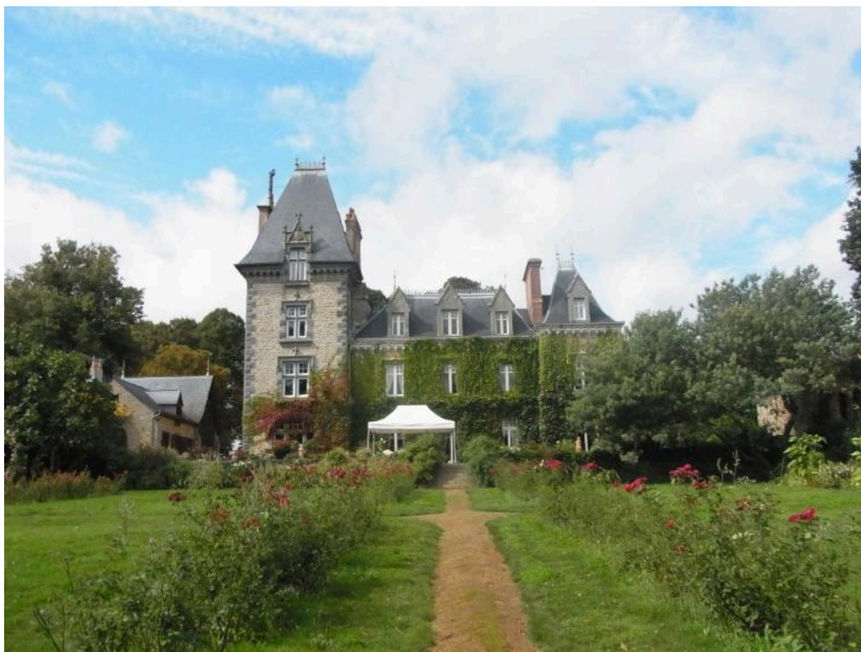
Façade arrière, vue générale
