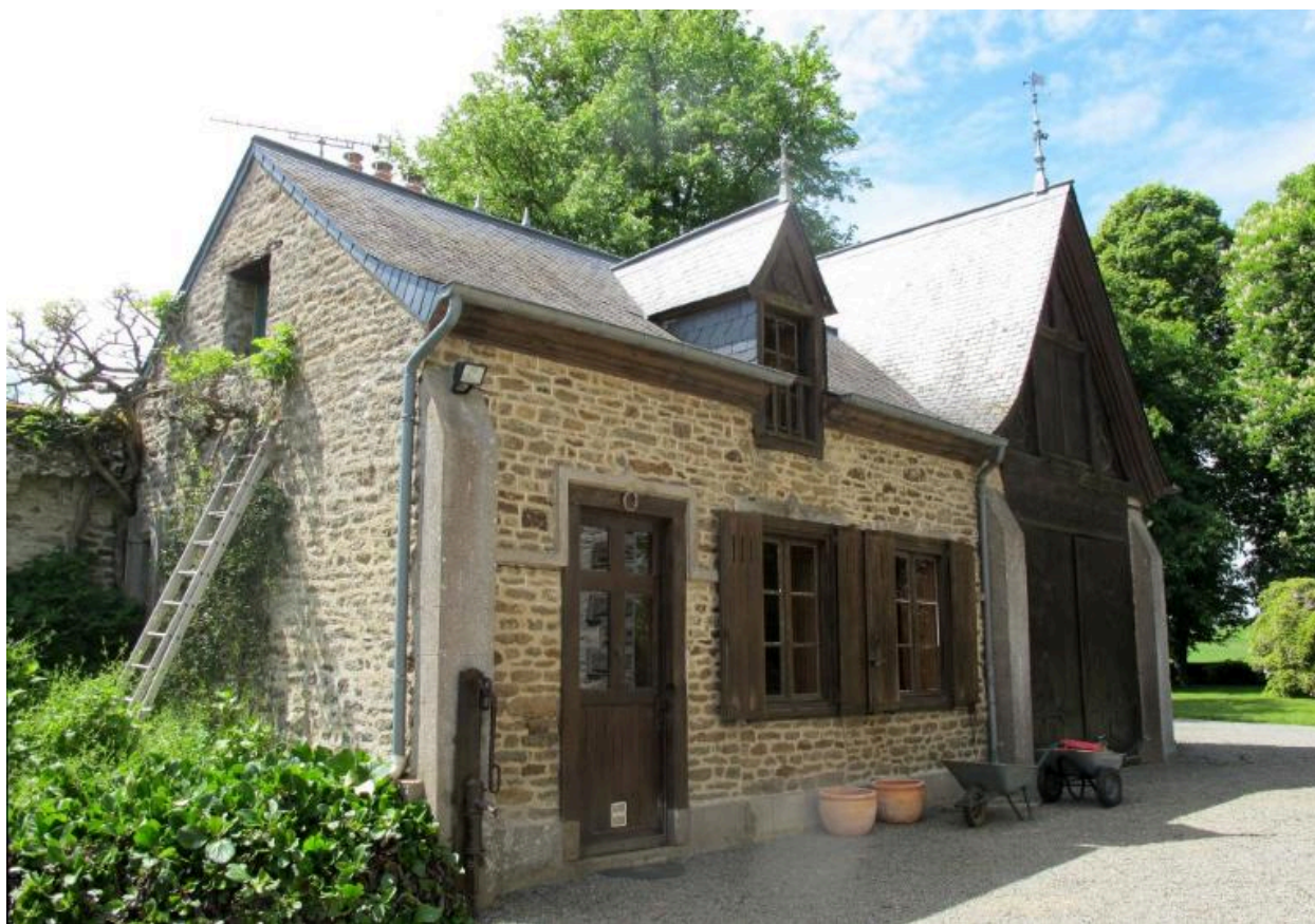
Ancienne écurie et remise
