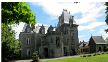
Façade antérieure, vue générale Phot. Véronique Orain IVR53_20172206248NUCA
