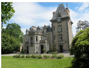
Facade antérieure, prise de trois quart Phot. Véronique Orain IVR53_20172206250NUCA
