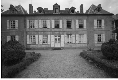
Vue générale ouest Phot. Guy Artur IVR53_19702901564V
