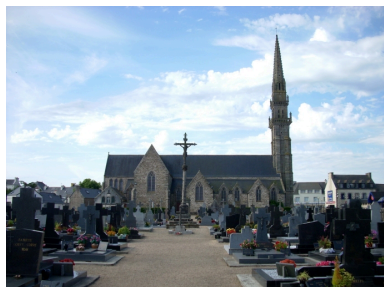
Plouvorn, église paroissiale Saint-Pierre : élévation nord Phot. Gwénaél Fauchille IVR53_20082906579NUCA
