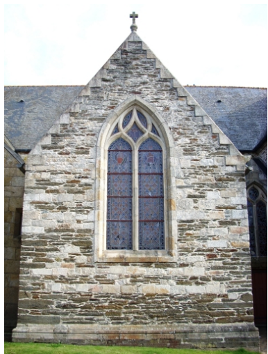
Plouvorn, église paroissiale Saint-Pierre : chapelle latérale sud, détail Phot. Gwénaél Fauchille IVR53_20082906582NUCA
