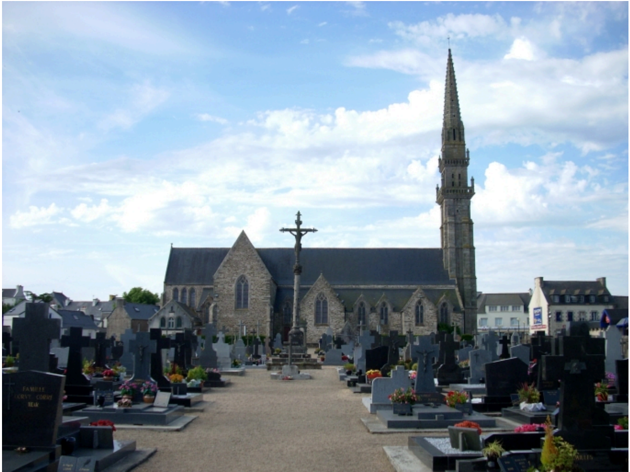
Plouvorn, église paroissiale Saint-Pierre : élévation nord
