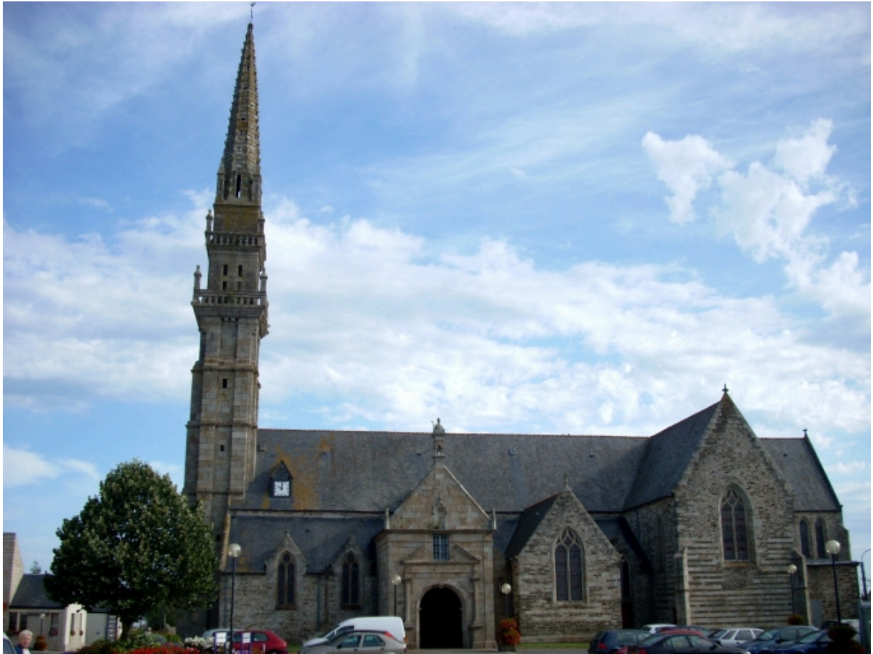
Plouvorn, église paroissiale Saint-Pierre : vue générale sud
