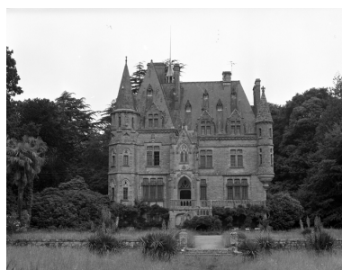
Vue générale sud Phot. Norbert Lambart IVR53_19815600755X
