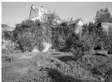
Vue générale des murailles prise du jardin du 22 rue du château Phot. François Dagorn IVR53_19675601582V
