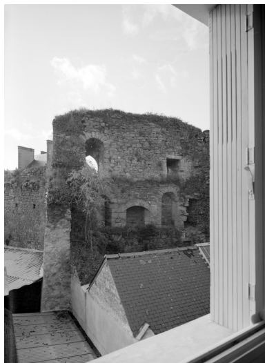
Vue prise du deuxième étage d'une maison voisine, intérieur du logis Phot. François Dagorn IVR53_19675601576V
