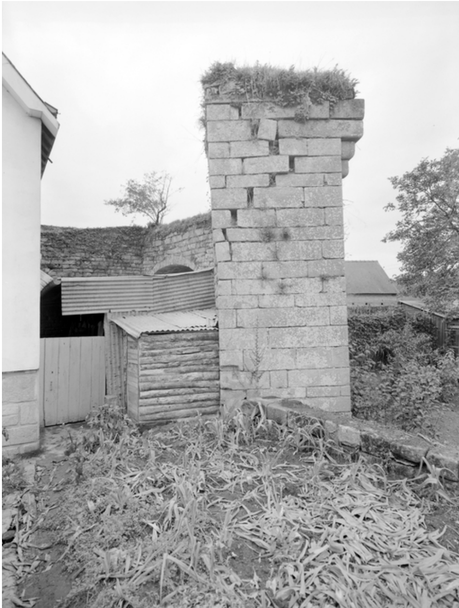
Intérieur de la poterne, vue du sud-est
