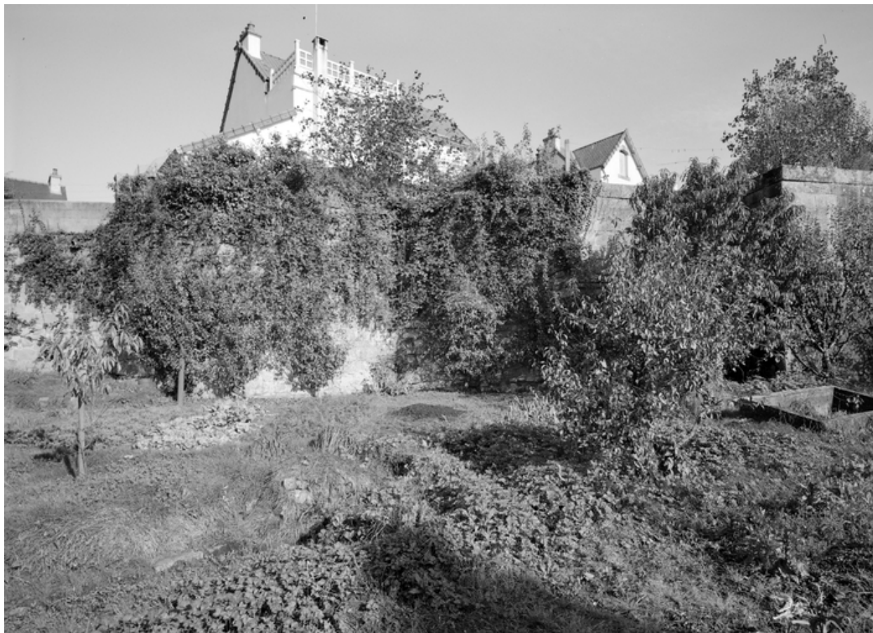
Vue générale des murailles prise du jardin du 22 rue du château
