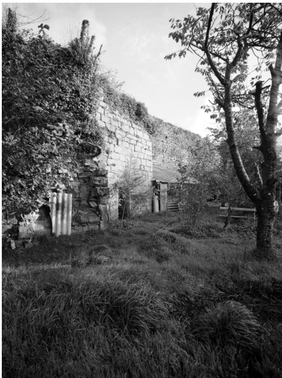
Vue sud-ouest de la tour
