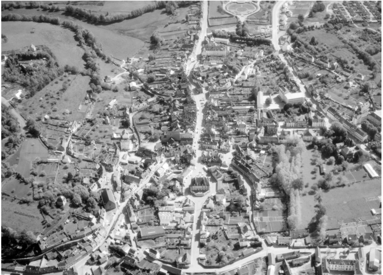
Vue aérienne prise de l'ouest
