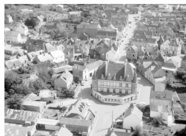
Vue aérienne, vestiges des anciens remparts, vus de l'ouest Phot. G.A.L.A.T. IVR53_19695600729V
