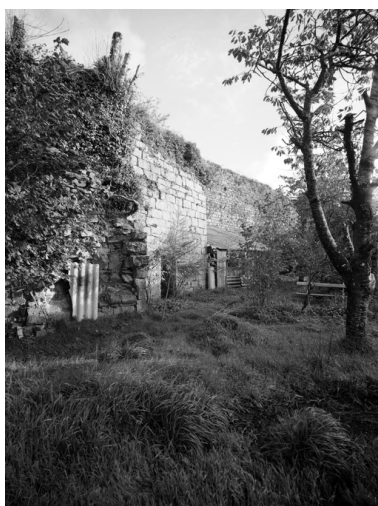
Vue sud-ouest de la tour
