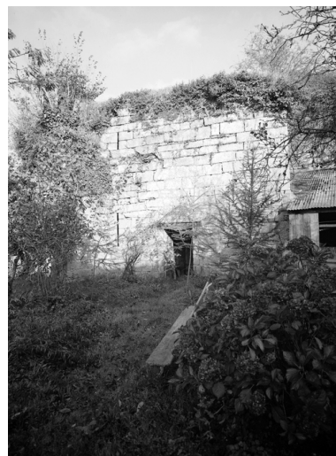
Vue de la tour prise du jardin Phot. François Dagorn IVR53_19675601571V
