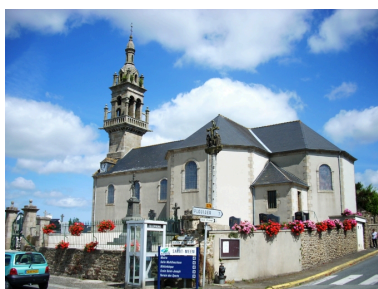
Saint-Méen, église paroissiale : vue générale sud-est Phot. Gwénaél Fauchille IVR53_20082906277NUCA
