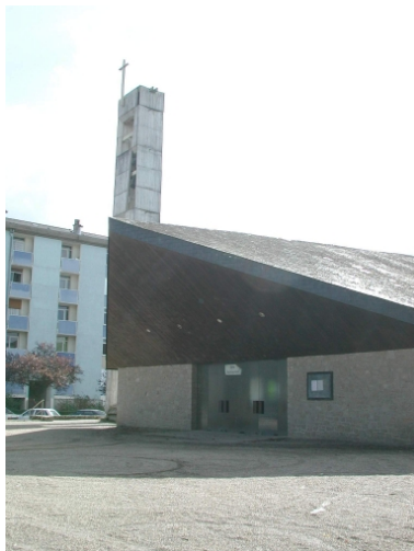
Vue depuis le nord-est Phot. Isabelle Barbedor IVR53_20013522443NUCA
