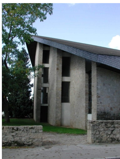
Vue du chevet, depuis le sud Phot. Isabelle Barbedor IVR53_20013522445NUCA
