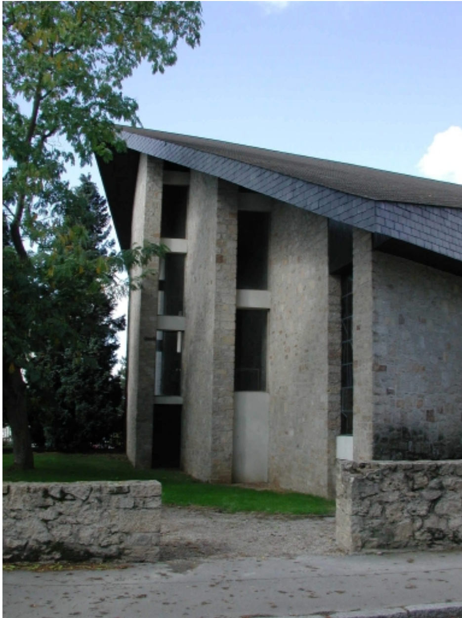
Vue du chevet, depuis le sud
