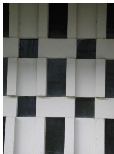
Détail du mur sud Phot. Isabelle Barbedor IVR53_20013522447NUCA
