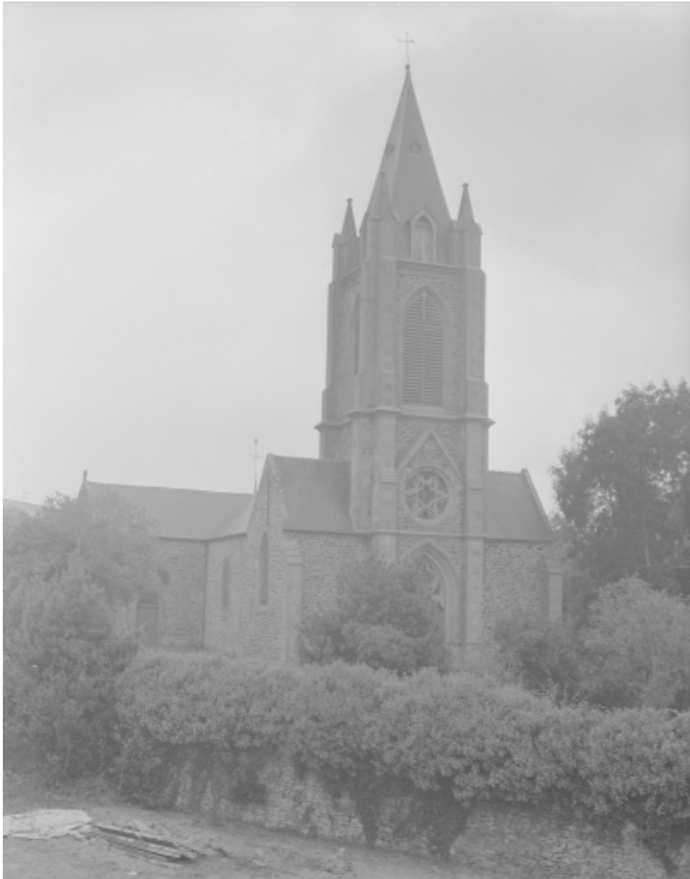
Elévation Ouest : vue générale
