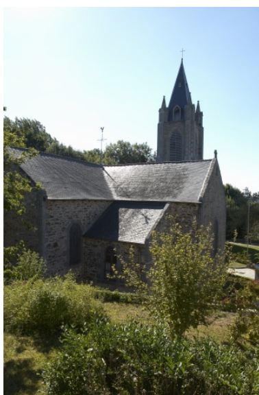
Vue nord-est Phot. Norbert Lambart IVR53_20063501883NUCA
