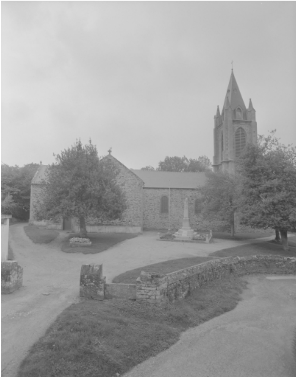
Elévation Nord : vue générale
