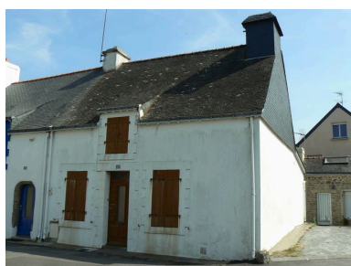
Vue générale de la maison de pêcheur du 45 rue de Moustérian Phot. Johan Vincent IVR53_20075605720NUCA
