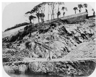
Vue de l'arsenal de Brest en 1859 (?) : travaux d'arrasement et de déroctage de la Montagne du Salou (falaise en schiste). Main d'oeuvre
