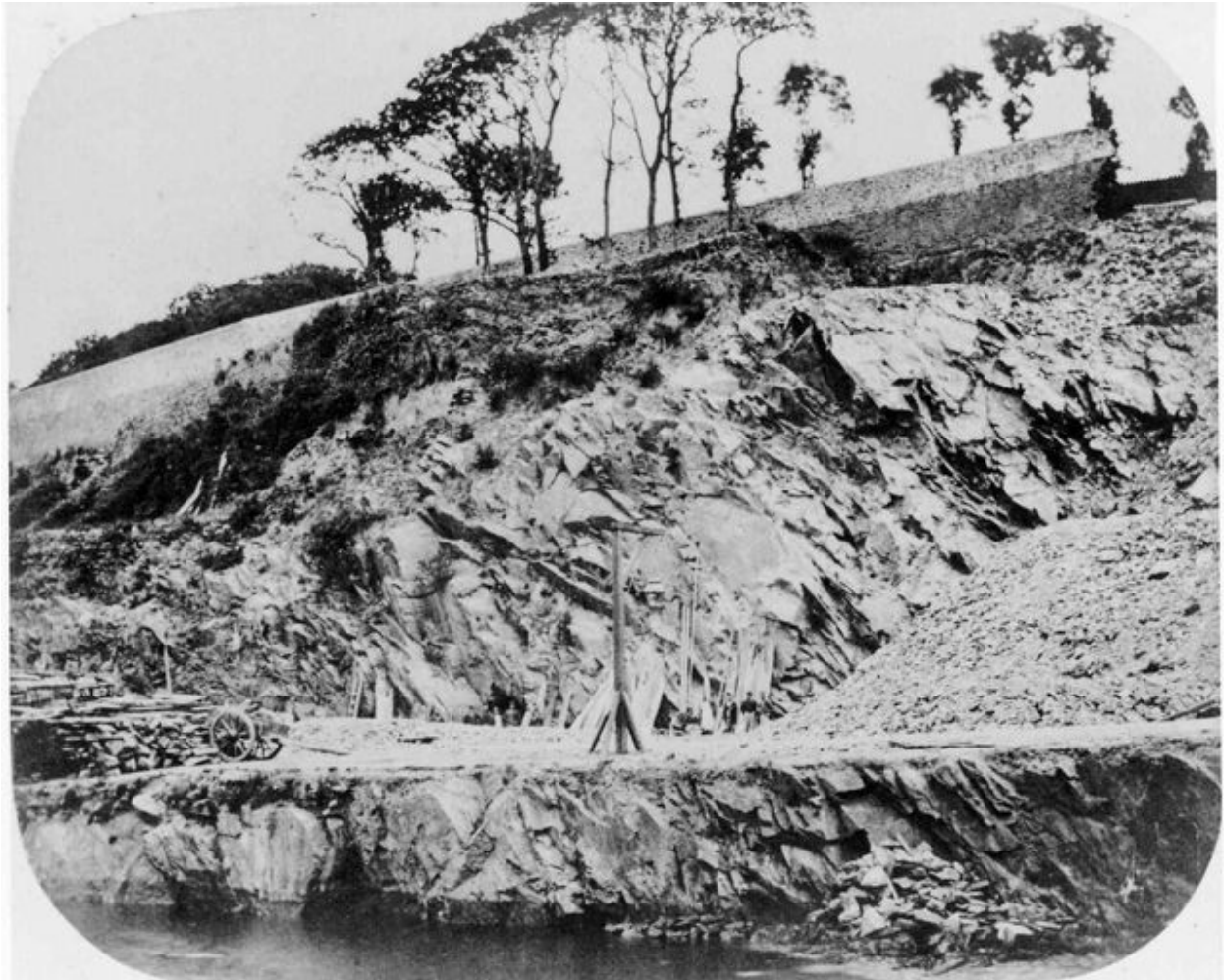
Vue de l'arsenal de Brest en 1859 (?) : travaux d'arrasement et de déroctage de la Montagne du Salou (falaise en schiste). Main d'oeuvre humaine et charettes tirées à dos d'hommes (bagnards : 1858 ?)
