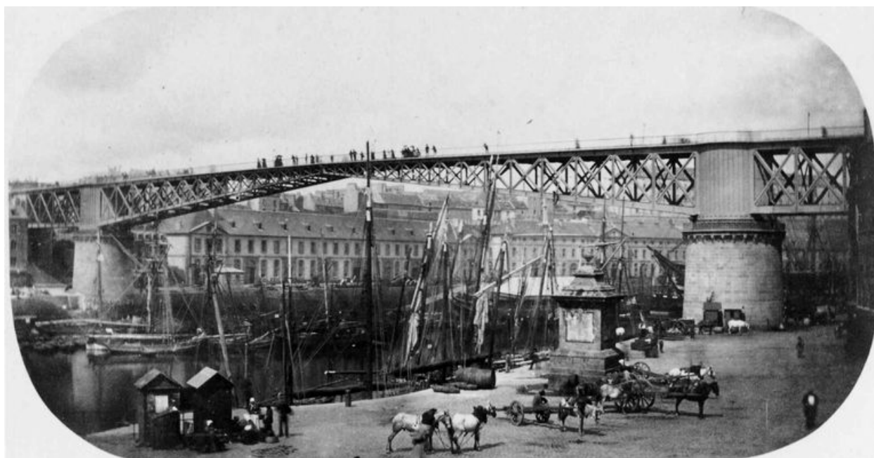
Vue de l'arsenal de Brest après 1861 (date de construction du pont) : le pont tournant ou Pont National. Il est constitué de deux volées tournantes qui permettent aux bateaux à haute mâture de remonter la Penfeld
