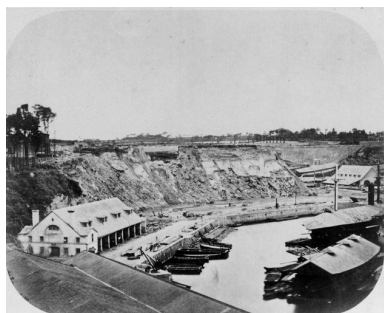
Vue de l'arsenal de Brest en 1859 : travaux d'arrasement et de déroctage de la Montagne du Salou (falaise en schiste) Repro. Archives municipales et communautaires. Brest Métropole Océane, Phot. Guillaume (retouche) Lécueillier, Autr. Auteur inconnu IVR53_20082908773NUC
