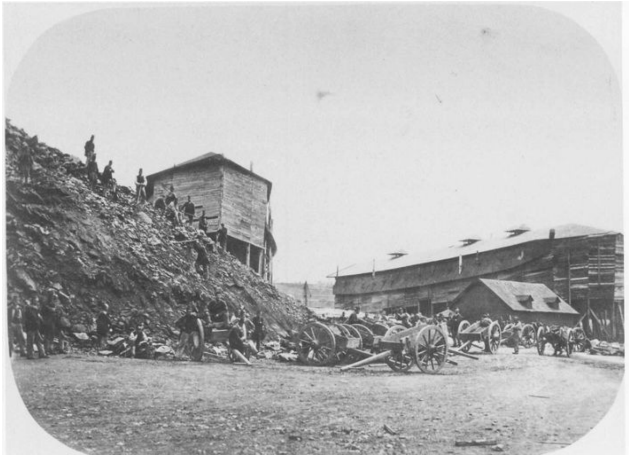
Vue de l'arsenal de Brest en 1859 (?) : travaux d'arrasement et de déroctage de la Montagne du Salou (falaise en schiste). Main d'oeuvre humaine et charettes tirées à dos d'hommes (bagnards : 1858 ?)
