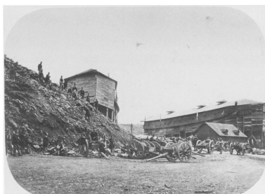
Vue de l'arsenal de Brest en 1859 (?) : travaux d'arrasement et de déroctage de la Montagne du Salou (falaise en schiste). Main d'oeuvre humaine et charettes tirées à dos d'hommes (bagnards : 1858 ?) Repro. Archives municipales et communautaires. Brest Métropole Océane, Phot. Guillaume (retouche) Lécueillier, Autr. Auteur inconnu IVR53_20082908774NUC
