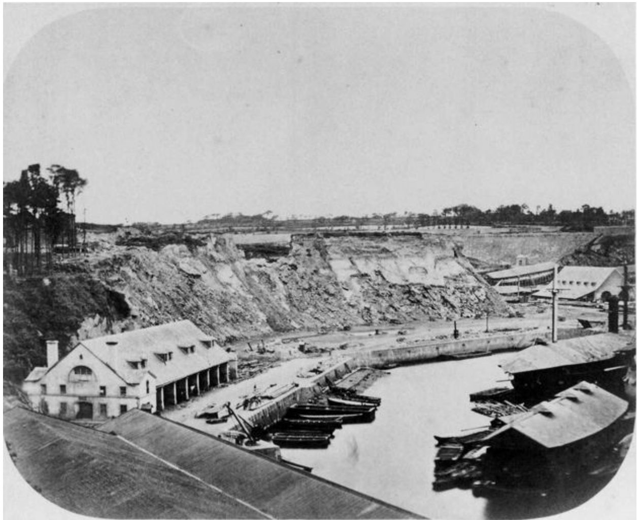
Vue de l'arsenal de Brest en 1859 : travaux d'arrasement et de déroctage de la Montagne du Salou (falaise en schiste)
