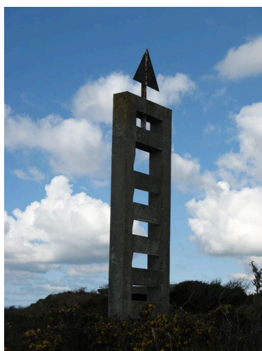
Signalisation et surveillance des côtes : amer de la pointe de Cornouaille (Roscanvel) Phot. Guillaume Marie IVR53_20082908444NUCA
