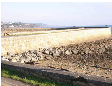
Protection contre l'érosion côtière : digue-route de Kelern (Roscanvel) Phot. Guillaume Marie IVR53_20072908951NUCA
