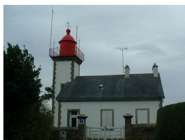
Signalisation et surveillance des côtes : maison-phare de la pointe du Kador (Crozon) Phot. Julien Amghar IVR53_20062908621NUCA
