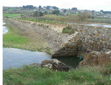
Protection contre l'érosion côtière : digue-route de poldérisation de l'Aber (Crozon) Phot. Julien Amghar IVR53_20072908775NUCA
