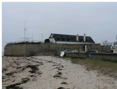
Défense militaire des côtes : redoute de Kernevel (Larmor-Plage) Phot. Julien Amghar IVR53_20085606057NUCA
