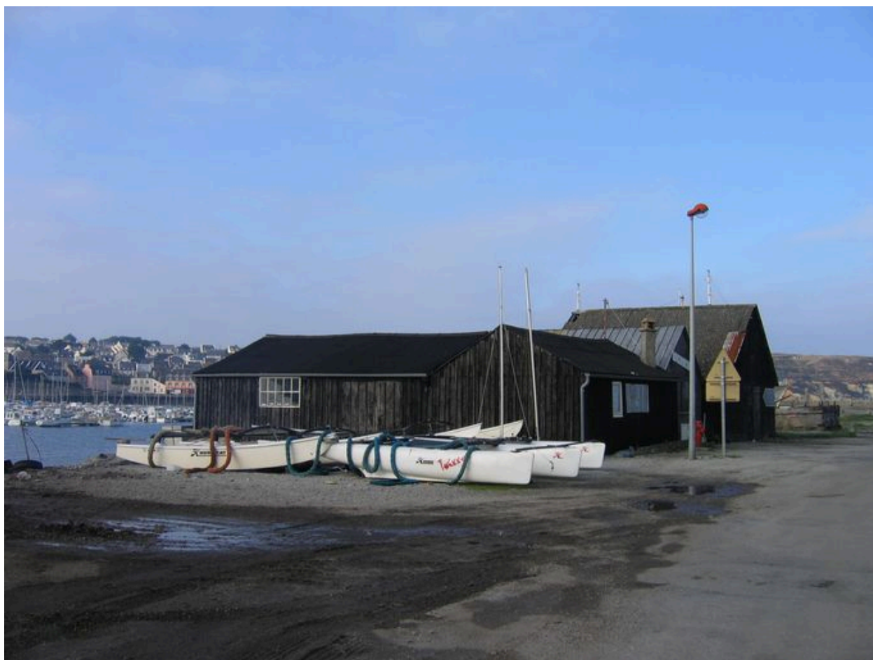
Activités artisanales et industrielles liées à la mer : atelier de chantier naval Le Mérour (Camaret-sur-Mer)
