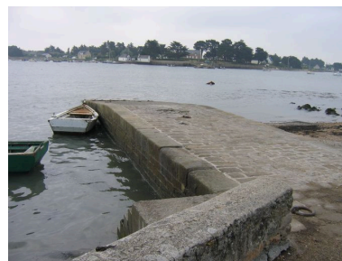
Transit terre/mer : cale de passage de Saint-Armel (Séné) Phot. Françoise Péron IVR53_20075605721NUCA
