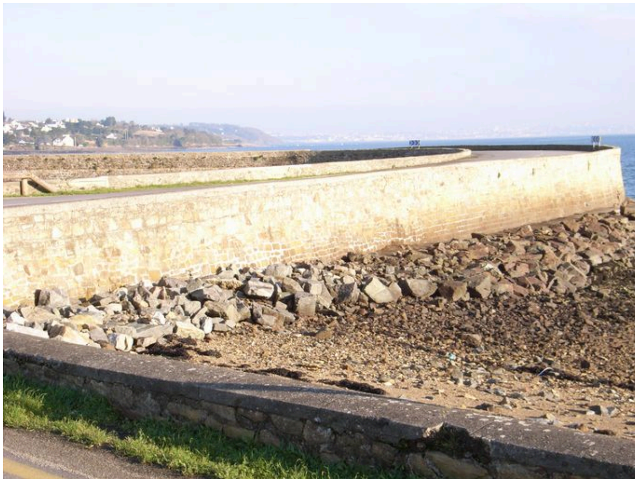
Protection contre l'érosion côtière : digue-route de Kelern (Roscanvel)
