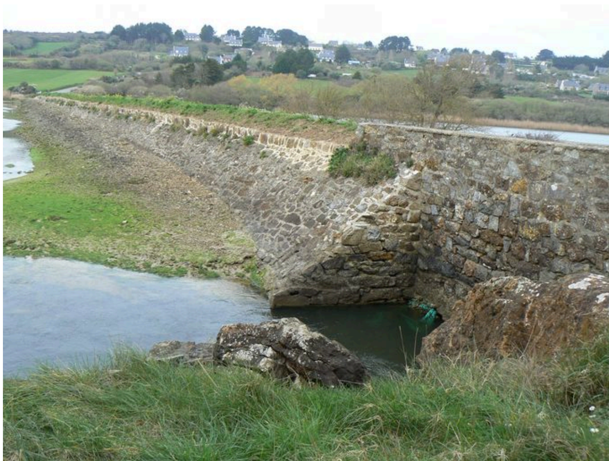
Protection contre l'érosion côtière : digue-route de poldérisation de l'Aber (Crozon)
