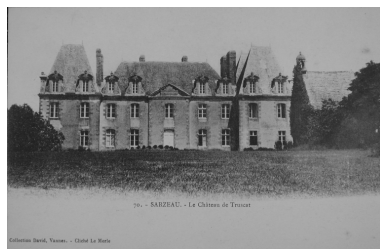
Vue de la façade postérieure Phot. Elise Lauranceau, Autr. Henri Laurent IVR53_20035604290NUCB
