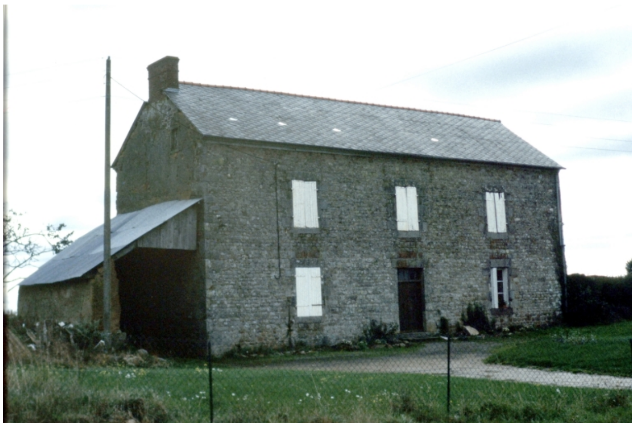
Le bourg, maison : vue générale
