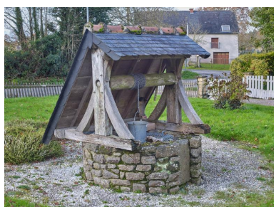
Puits couvert. Vue générale Phot. Bernard Bègne IVR53_20243501468NUCA
