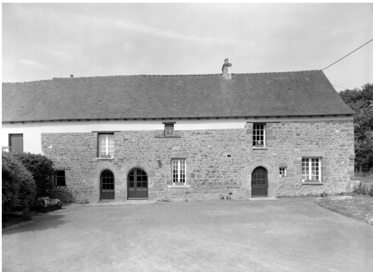
La Forêt - Ferme, vue générale.
