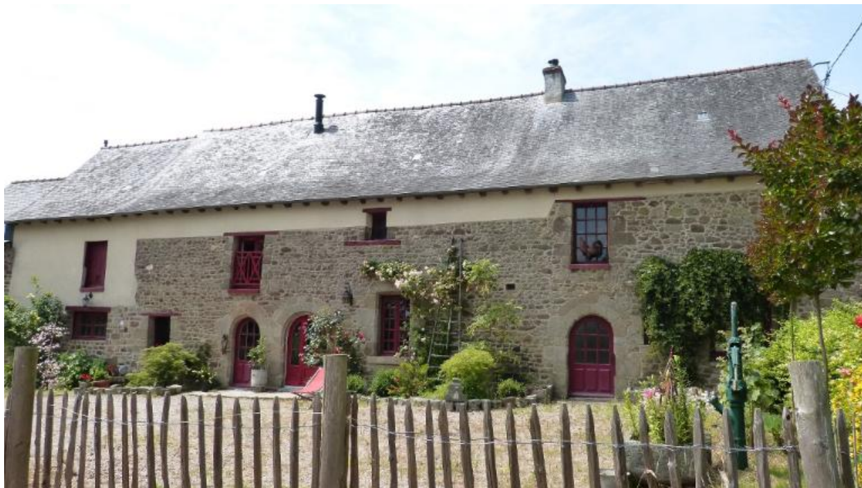
Vue de la façade principale orientée est
