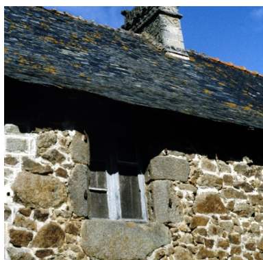
Le bourg, maison : détail fenêtre Phot. Denise Dufief, Repro. Norbert Lambart IVR53_19853500416ZA
