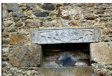
La Basse Biliais : linteau fenêtre communs sud Phot. Denise Dufief, Repro. Norbert Lambart IVR53_19853500464ZA
