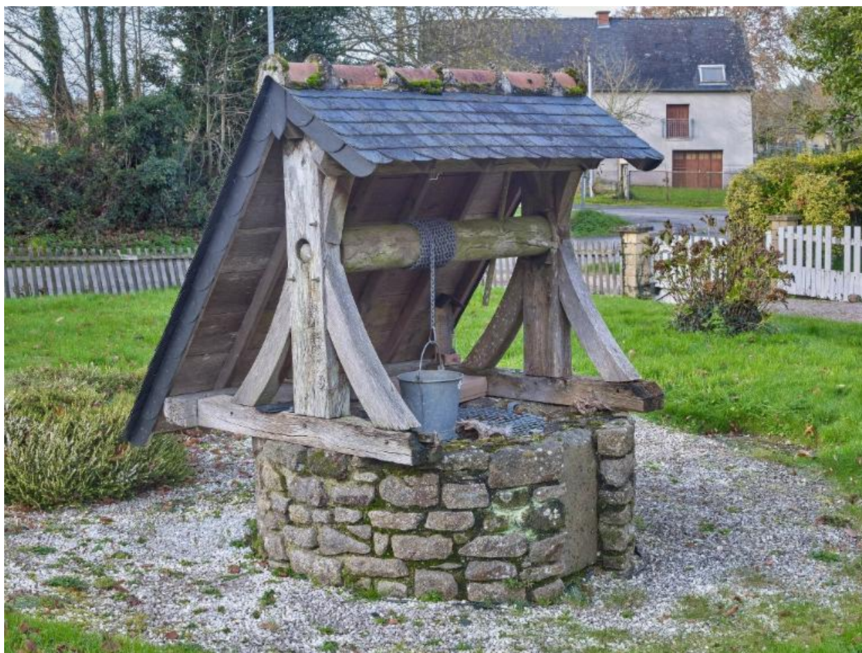
Puits couvert. Vue générale
