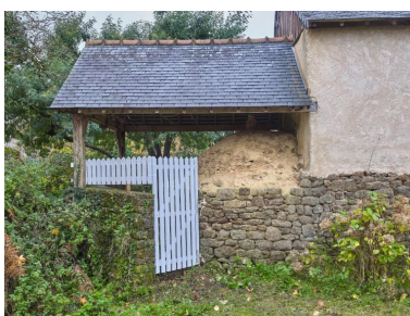
Four du fournil Phot. Bernard Bègne IVR53_20243501489NUCA
