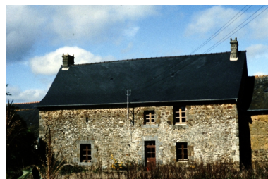
Le bourg, maison : vue générale postérieure Phot. Denise Dufief, Repro. Norbert Lambart IVR53_19853500418ZA
