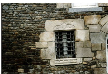
La Basse Biliais : élévation sud, détail Phot. Denise Dufief, Repro. Norbert Lambart IVR53_19853500466ZA
