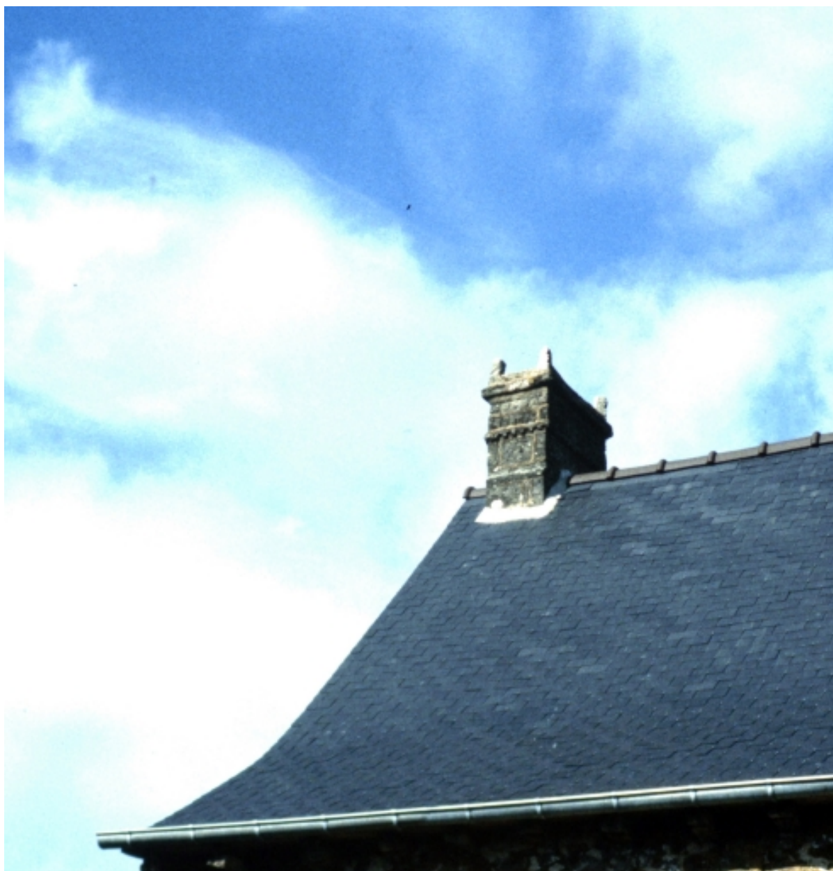
Le bourg, maison : souche de cheminée
