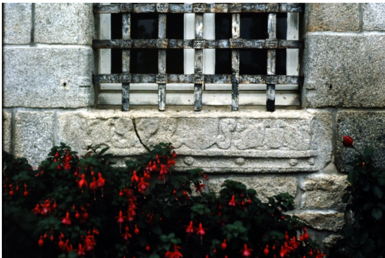
La Basse Biliais : appui de fenêtre, élévation sud
