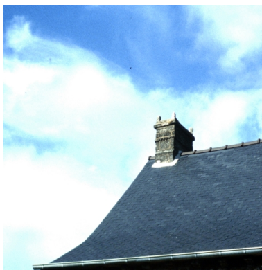
Le bourg, maison : souche de cheminée Phot. Denise Dufief, Repro. Norbert Lambart IVR53_19853500419ZA
