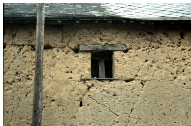
Longrais : jour, élévation postérieure Phot. Denise Dufief, Repro. Norbert Lambart IVR53_19853500461ZA
