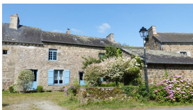
Vue générale est Phot. Laurence Marquet IVR53_20243531196NUCA
