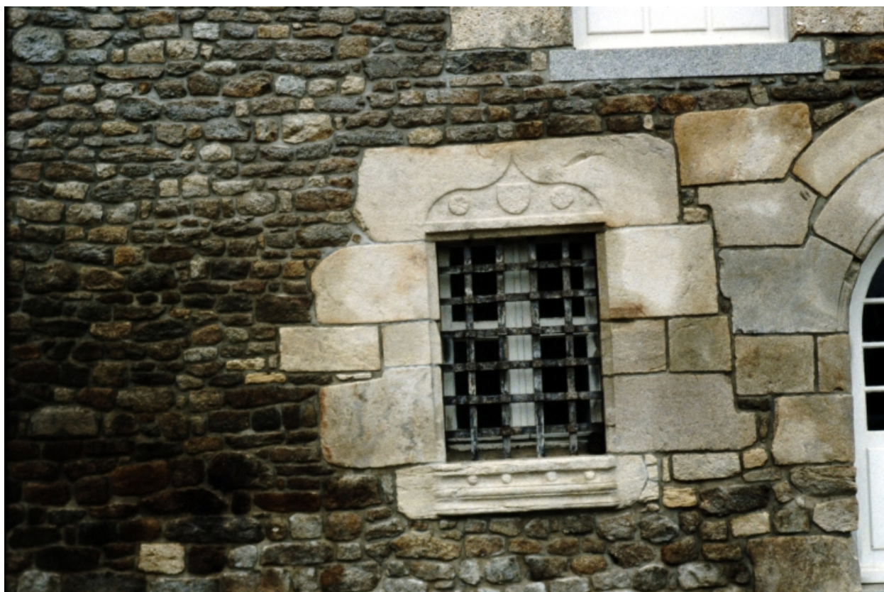
La Basse Biliais : élévation sud, détail
