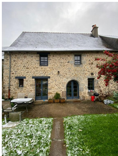
Façade orientée sud Phot. Laurence Marquet IVR53_20243532793NUCA
