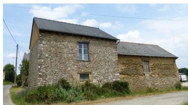
Vue générale sud Phot. Laurence Marquet IVR53_20243531136NUCA
