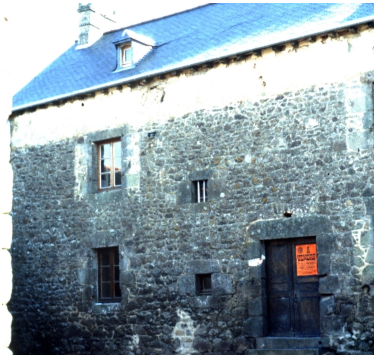
Le bourg, maison : vue partielle façade sur cour
