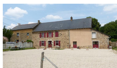
Vue générale sud Phot. Laurence Marquet IVR53_20243531134NUCA
