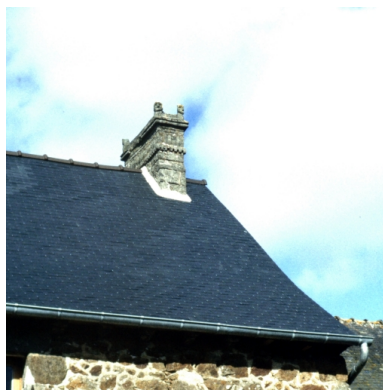
Le bourg, maison : souche de cheminée Phot. Denise Dufief, Repro. Norbert Lambart IVR53_19853500420ZA
