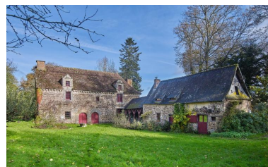
Vue générale sud-ouest Phot. Bernard Bègne IVR53_20243501379NUCA
