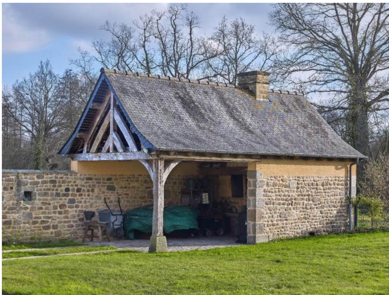
Fournil accolé au mur de clôture, 19e siècle. Vue générale nord-ouest
