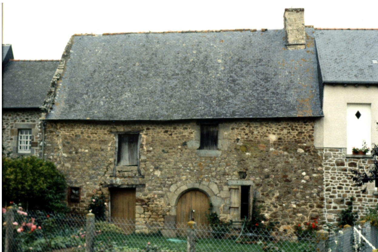
La Toutenais : vue générale sud
