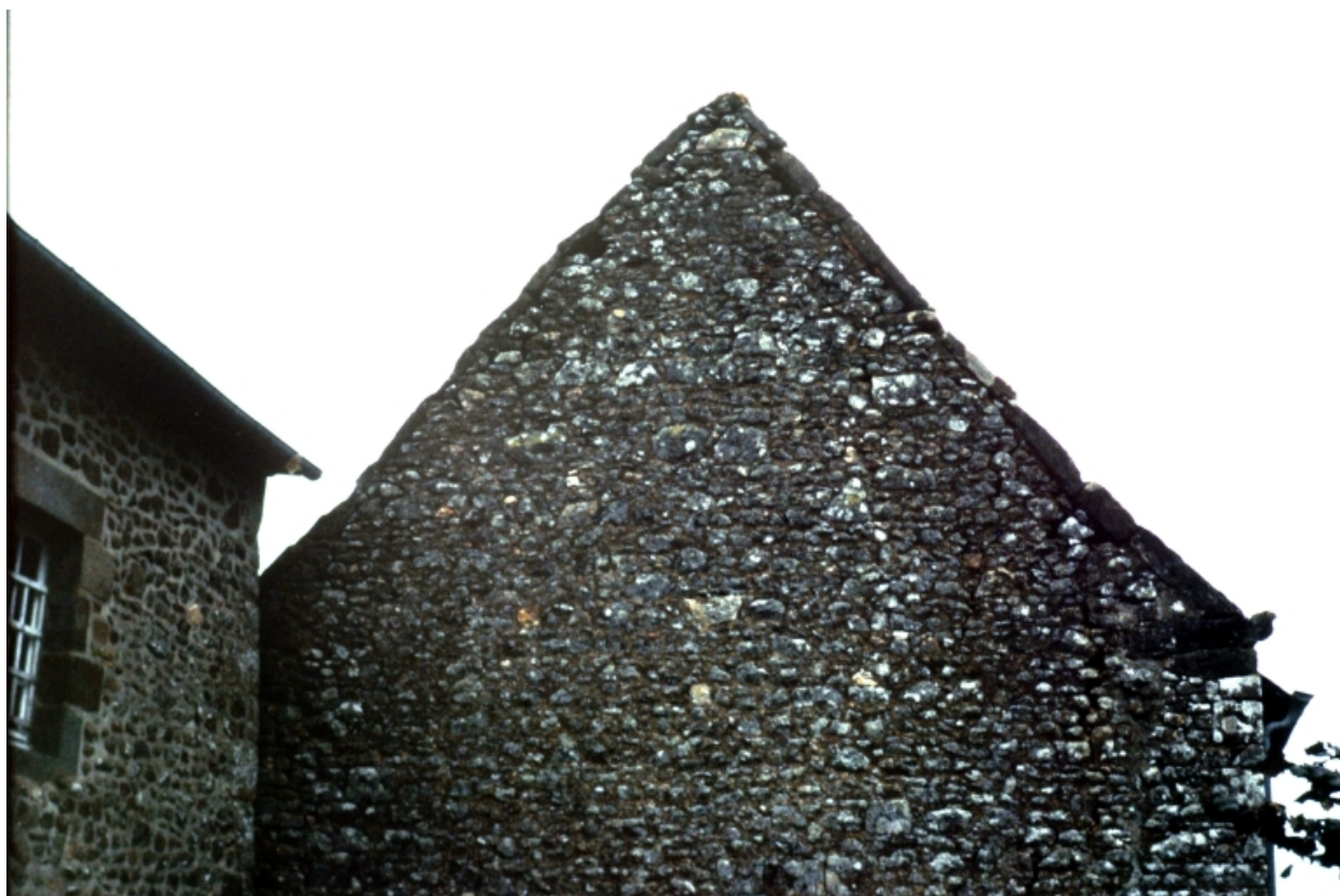
La Toutenais : pignon ouest
