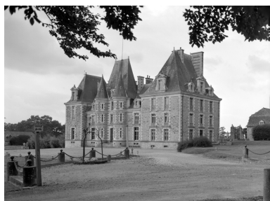
Elévation est, vue générale. Phot. Guy Artur, Phot. Norbert Lambart IVR53_19823500868V
