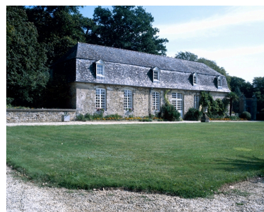
Orangerie, vue générale. Phot. Guy Artur, Phot. Norbert Lambart IVR53_19973500957XA
