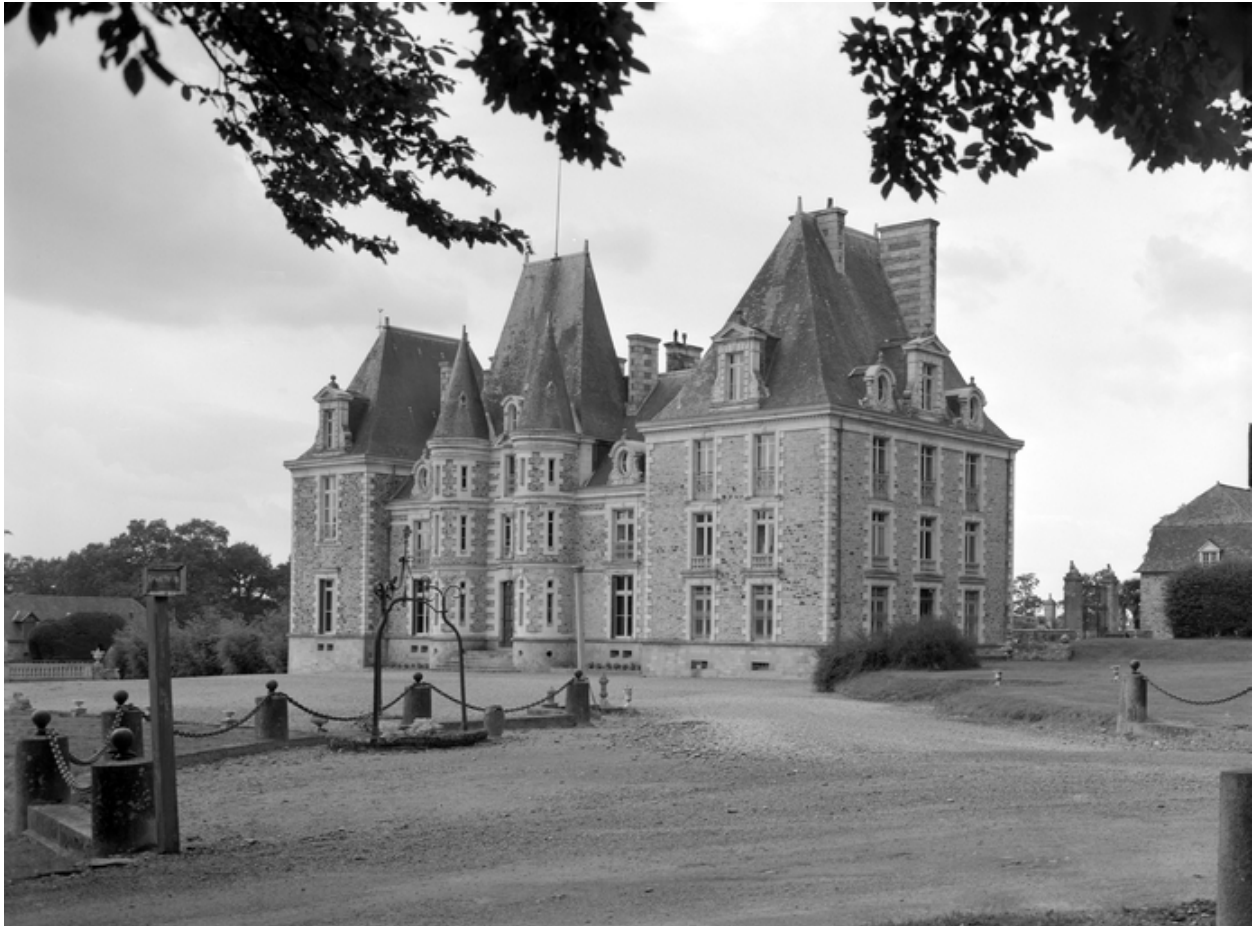
Elévation est, vue générale.
