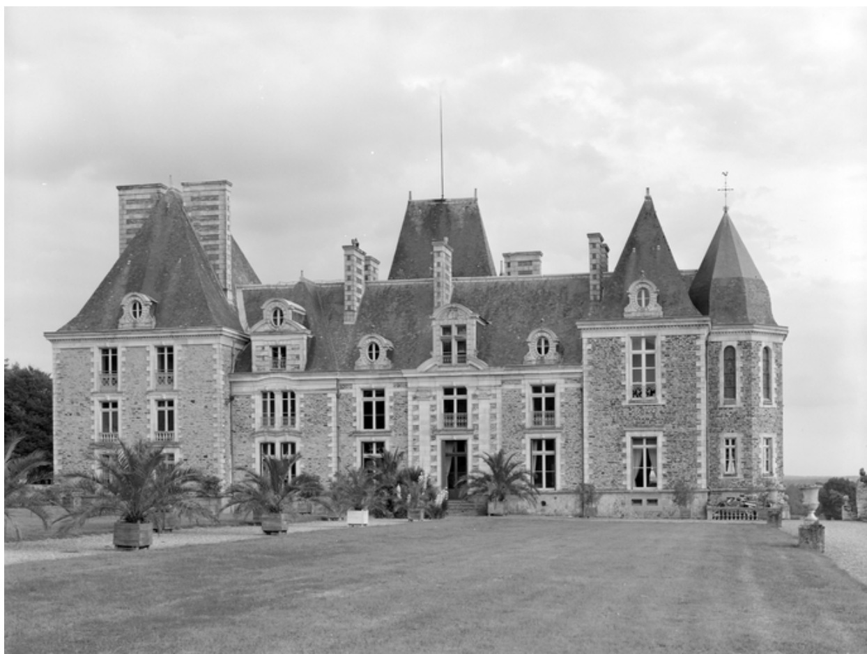
Elévation ouest, vue générale.
