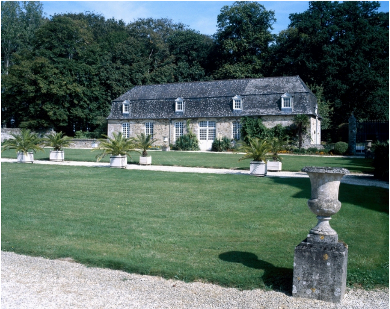
Orangerie, vue générale.
