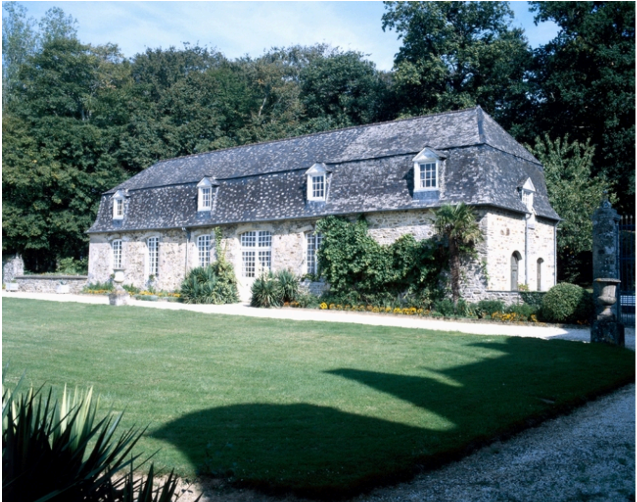
Orangerie, vue générale.
