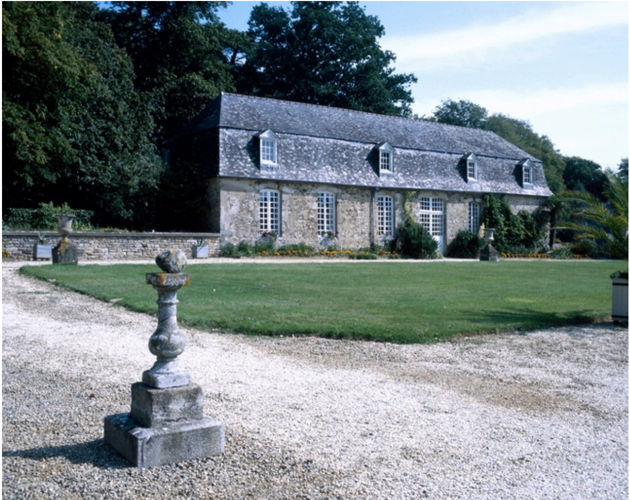
Orangerie, vue générale.
