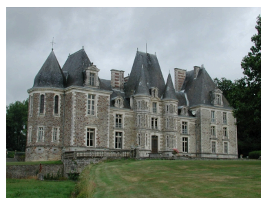
Vue générale de la façade principale (2004) Phot. Elise Lauranceau IVR53_20043521155NUCA
