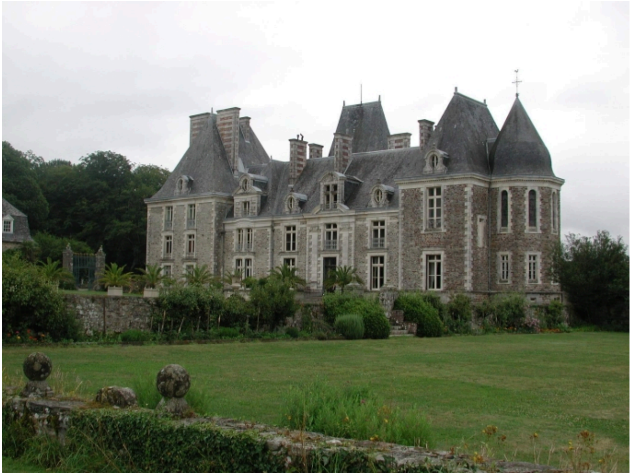
Vue générale de la façade sur jardin (2004)
