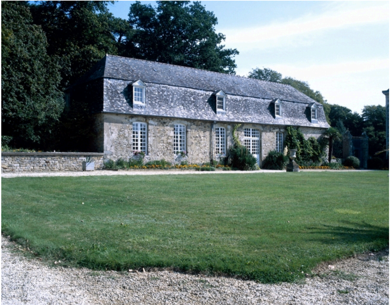
Orangerie, vue générale.
