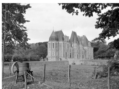
Elévation sud-est, vue générale. Phot. Guy Artur, Phot. Norbert Lambart IVR53_19823500869V
