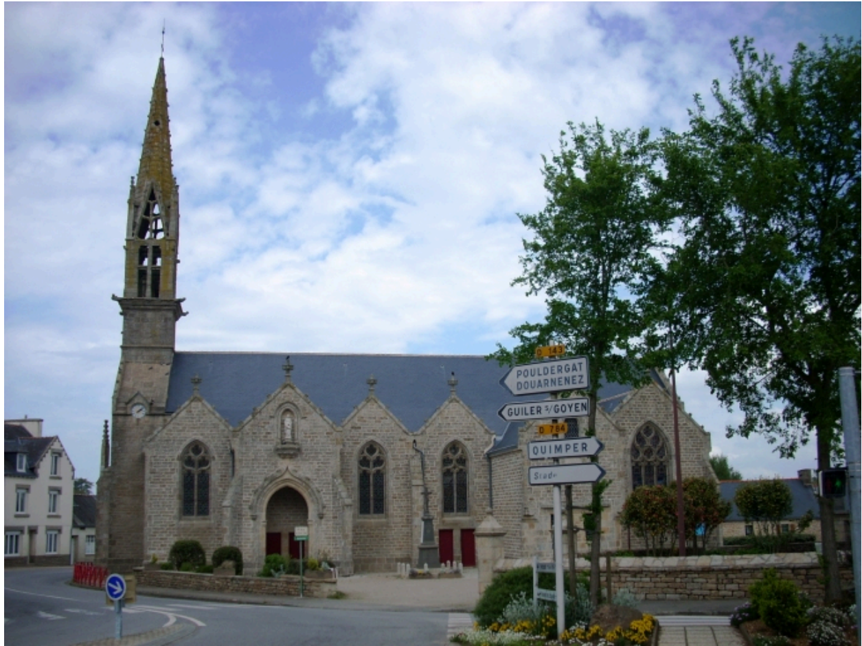
Landudec, église paroissiale Saint-Tudec et Sainte-Anne : vue générale sud
