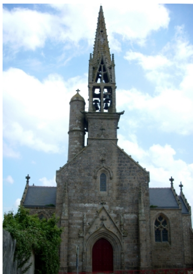
Landudec, église paroissiale Saint-Tudec et Sainte- Anne : vue générale ouest Phot. Gwénaél Fauchille IVR53_20082905778NUCA
