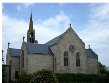
Landudec, église paroissiale Saint-Tudec et Sainte- Anne : vue générale sud-est Phot. Gwénaél Fauchille IVR53_20082905780NUCA
