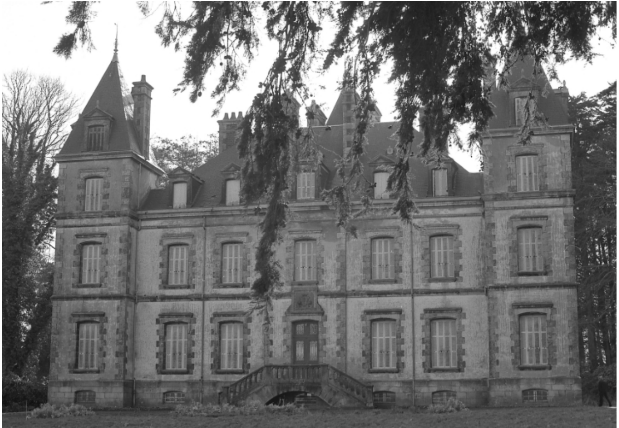
Elévation est : vue générale
