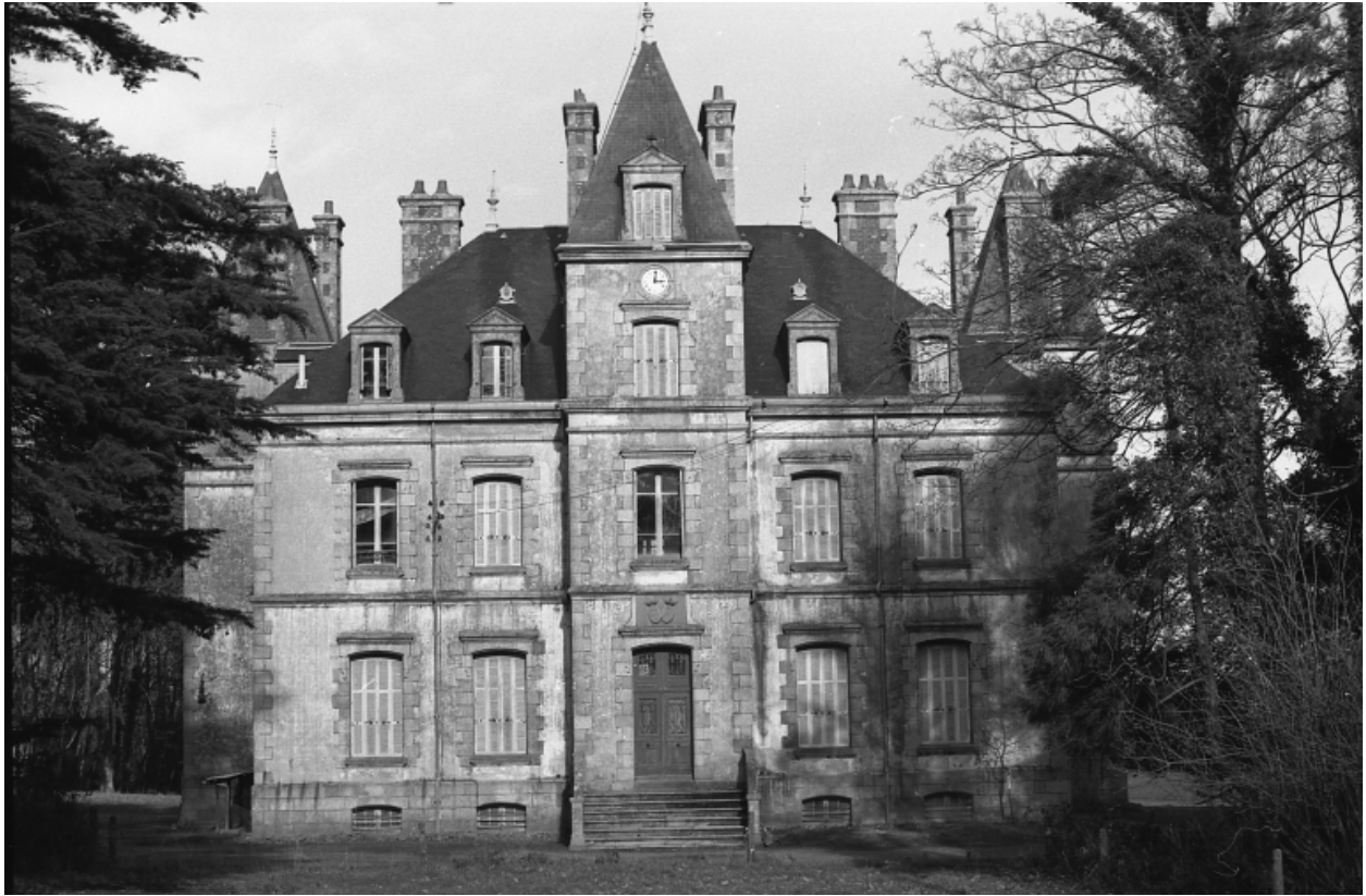
Elévation ouest : vue générale
