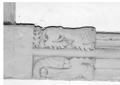
Tour sud, poutre moulurée et décorée : vue générale (état en 1984) Phot. Guy Artur, Phot. Norbert Lambart IVR53_19845600933X
