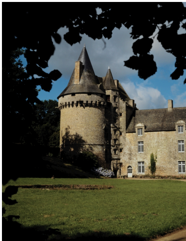
Tour sud et tour d'escalier : vue générale prise du sud-est (état en 1988) Phot. Guy Artur, Phot. Norbert Lambart IVR53_19885600021XA
