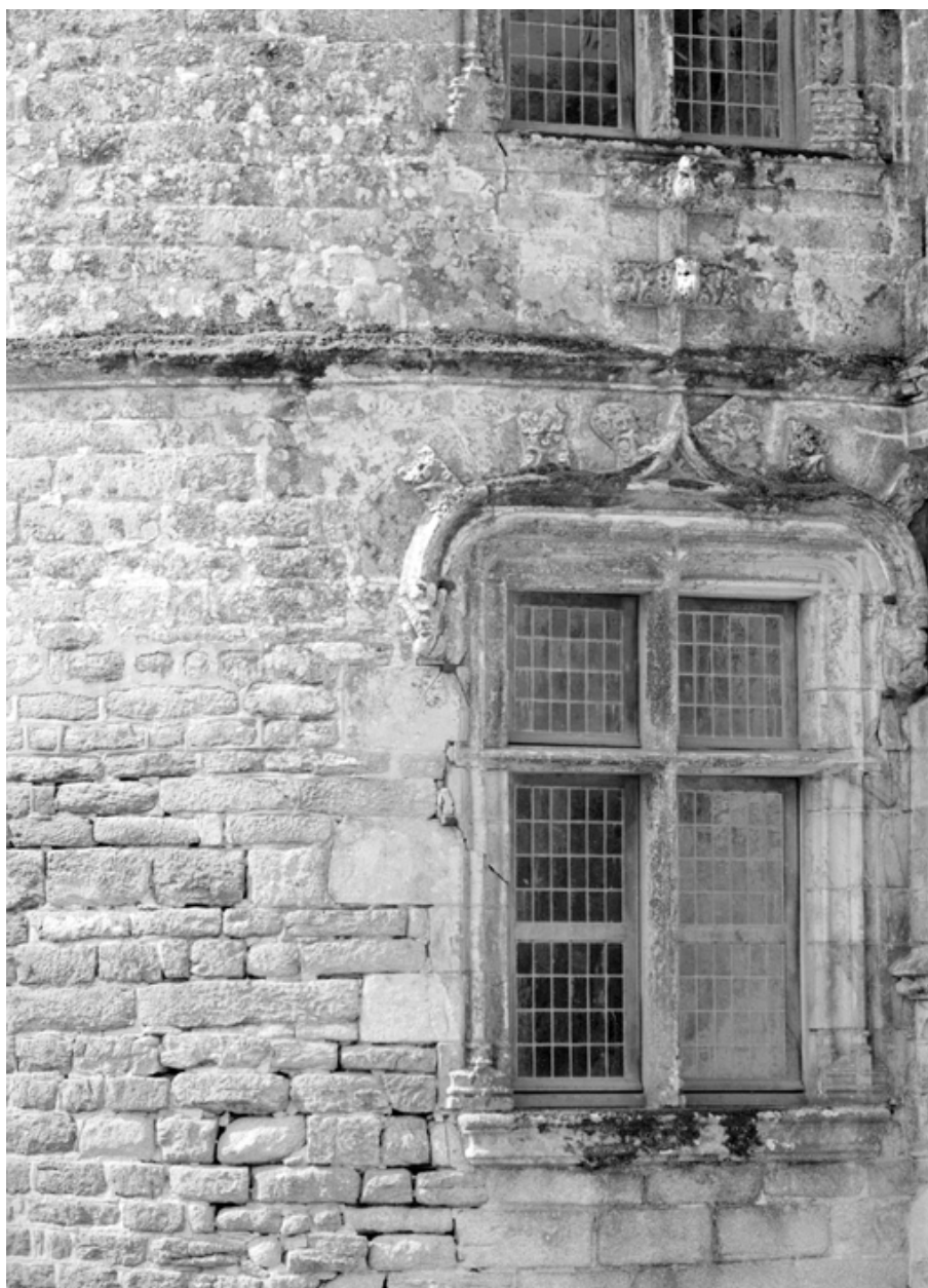
Tour sud : fenêtre du second niveau (état en 1984)
