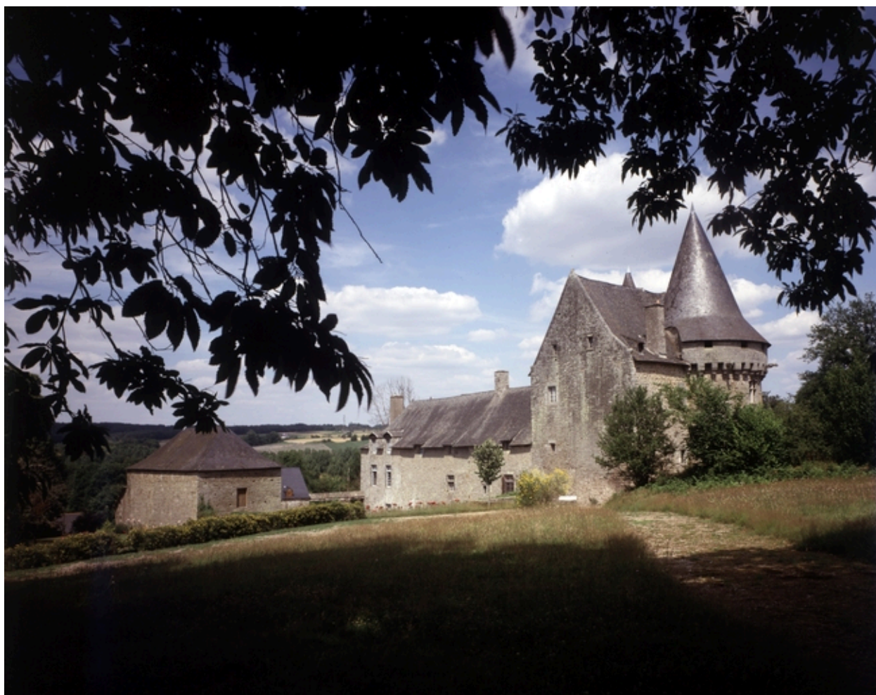
Vue générale prise du sud-ouest (état en 1984)
