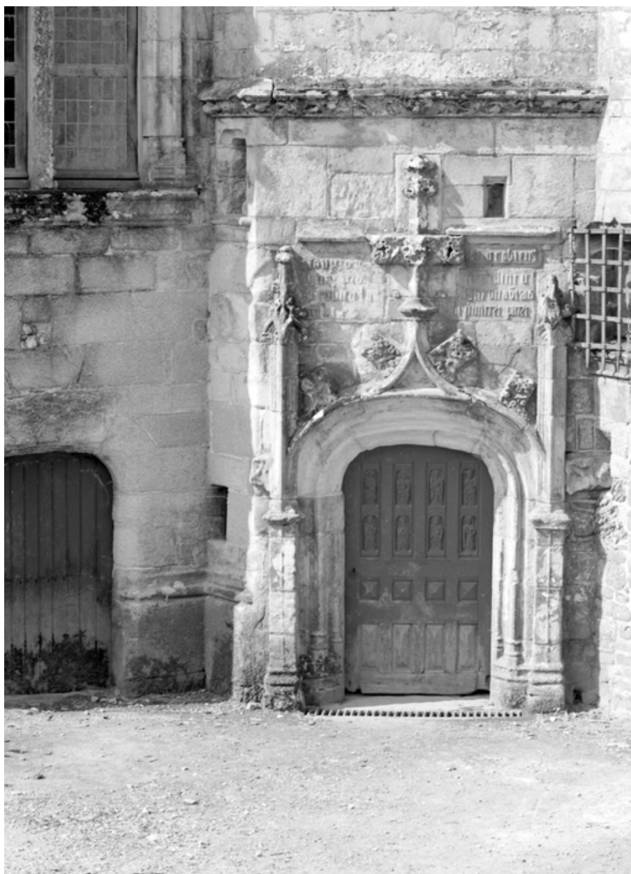
Tour d'escalier, porte : vue générale (état en 1984)
