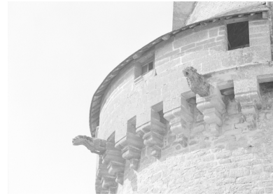
Tour sud : chemin de ronde du couronnement (état en 1984) Phot. Guy Artur, Phot. Norbert Lambart IVR53_19845600928X
