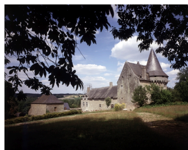
Vue générale prise du sud-ouest (état en 1984) Phot. Guy Artur, Phot. Norbert Lambart IVR53_19845600916VA
