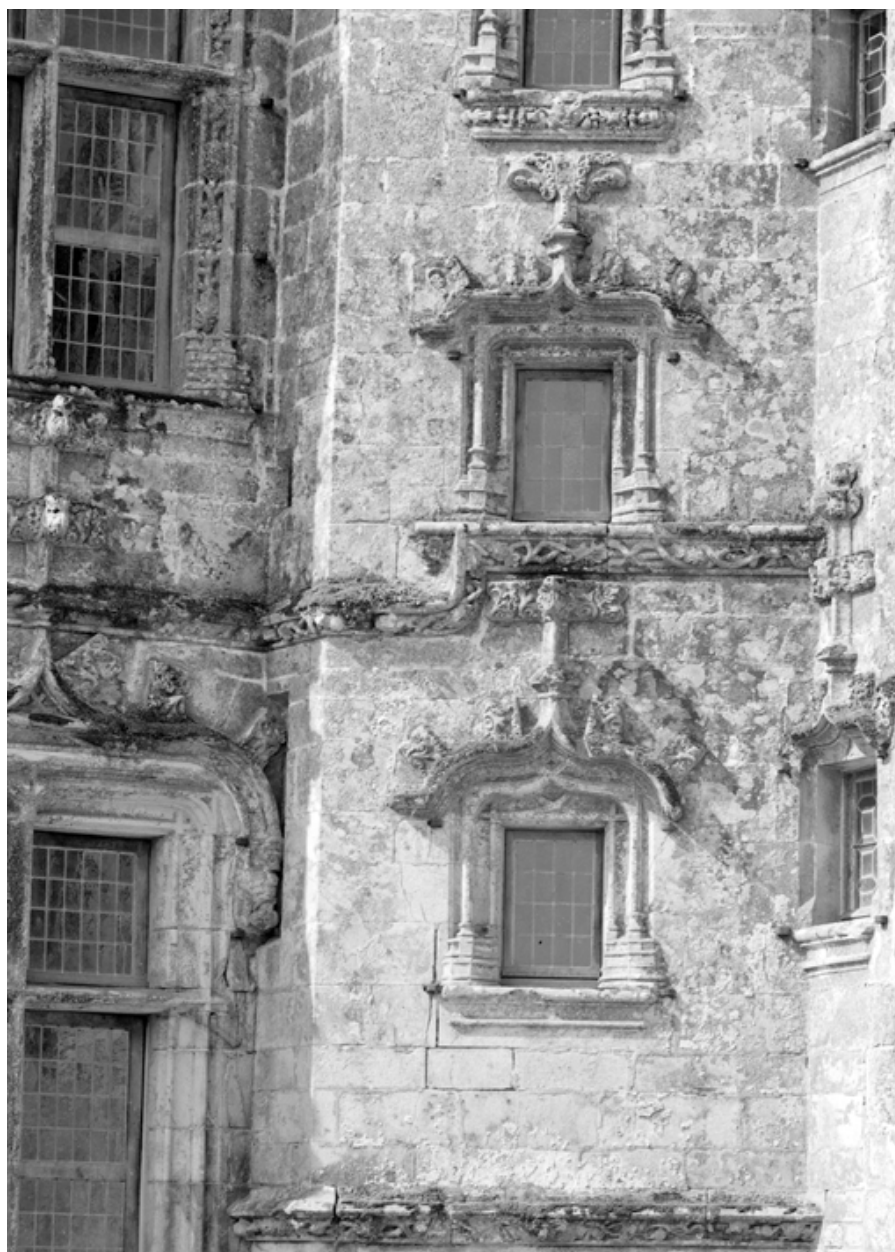
Tour d'escalier, baies des 2e et 3e niveaux : vue générale (état en 1984)
