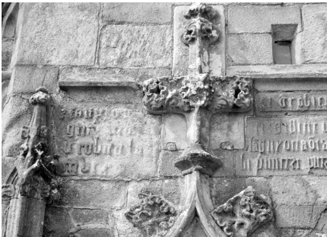
Tour d'escalier, partie supérieure de la porte : vue générale de l'inscription (état en 1984)
