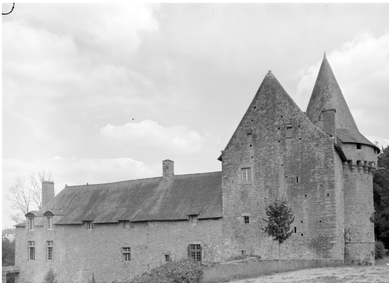
Elévation ouest : vue générale (état en 1984)
