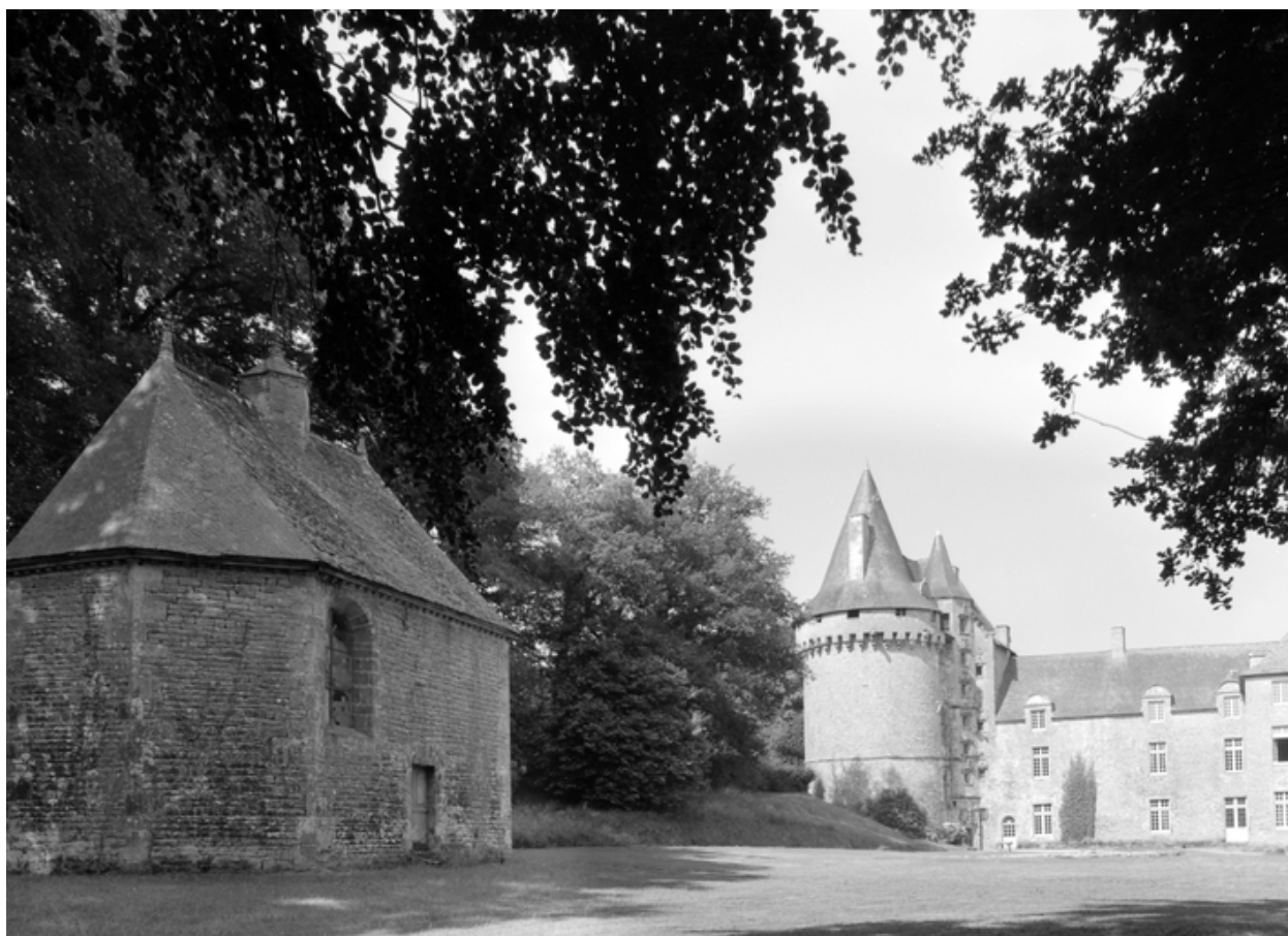
Vue générale prise de l'est : au 1er plan, la chapelle (état en 1984)
