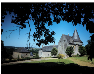
Vue générale prise du sud-ouest (état en 1988) Phot. Guy Artur, Phot. Norbert Lambart IVR53_19885600019VA
