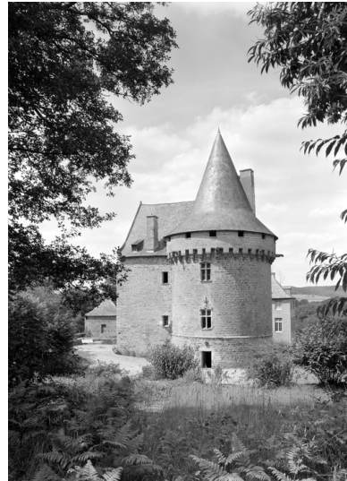
Tour sud : vue générale prise du sud (état en 1984) Phot. Guy Artur, Phot. Norbert Lambart IVR53_19845600912V
