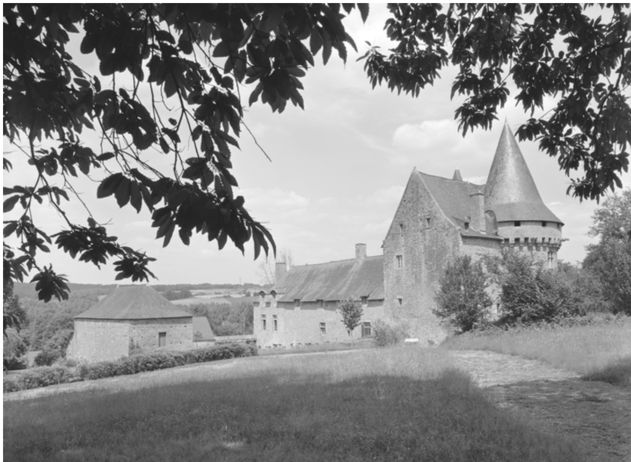
Vue générale prise du sud-ouest (état en 1984)
