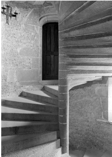
Tour d'escalier : vue générale de l'escalier (état en 1984) Phot. Guy Artur, Phot. Norbert Lambart IVR53_19845600917V
