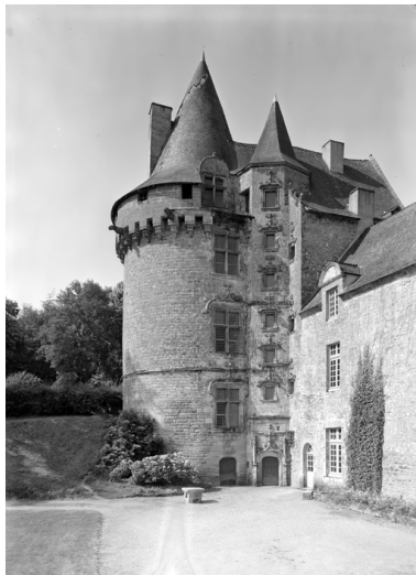
Tour sud et tour d'escalier : élévation nord (état en 1984) Phot. Guy Artur, Phot. Norbert Lambart IVR53_19845600914V
