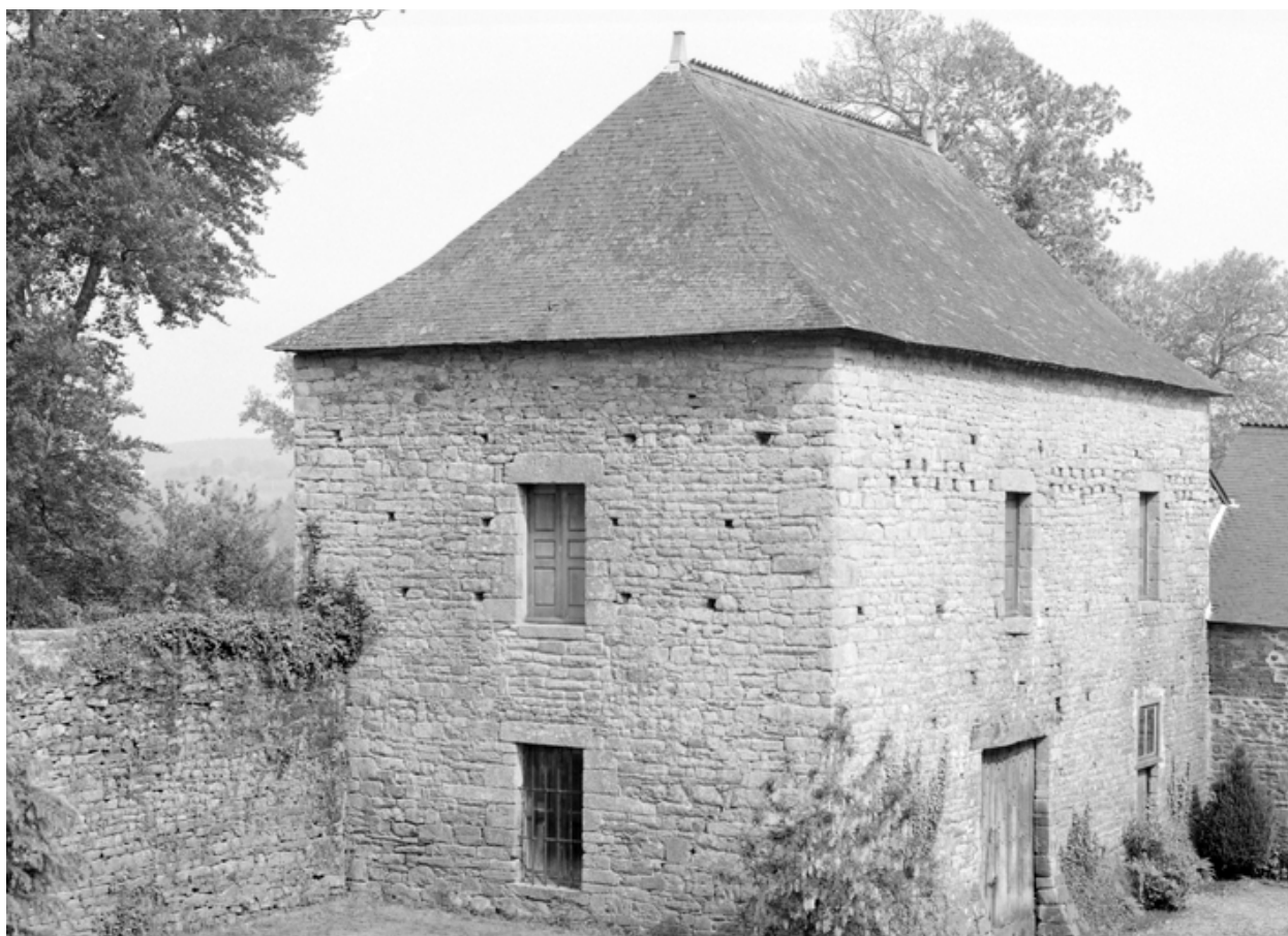
Remise avec pigeonnier : vue générale (état en 1984)
