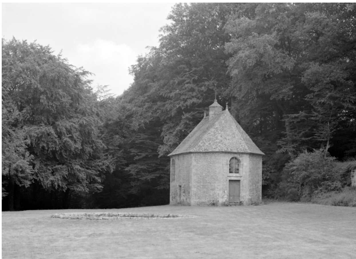
Chapelle, élévation ouest : vue générale (état en 1984)
