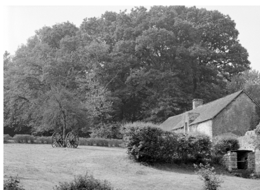
Les dépendances à l'ouest du château : vue générale (état en 1984) Phot. Guy Artur, Phot. Norbert Lambart
