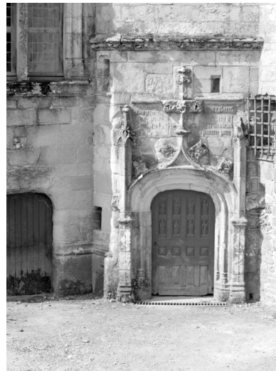
Tour d'escalier, porte : vue générale (état en 1984) Phot. Guy Artur, Phot. Norbert Lambart IVR53_19845600923X
