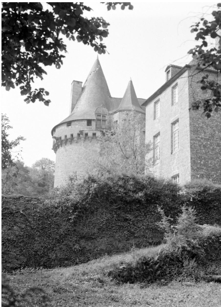
Vue générale prise du nord-est (état en 1984)
