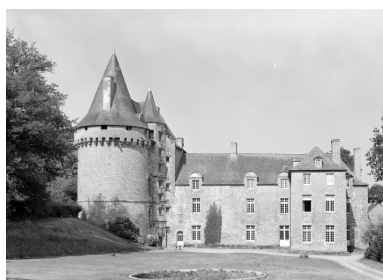
Elévation est : vue générale (état en 1984) Phot. Guy Artur, Phot. Norbert Lambart IVR53_19845600911V
