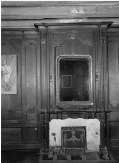
Logis, cheminée : vue générale (état en 1988) Phot. Guy Artur, Phot. Norbert Lambart IVR53_19885600616V
