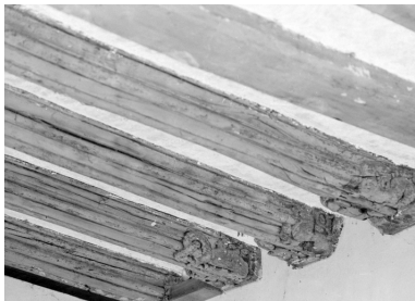
Tour sud, poutres moulurées : vue générale (état en 1984) Phot. Guy Artur, Phot. Norbert Lambart IVR53_19845600929X
