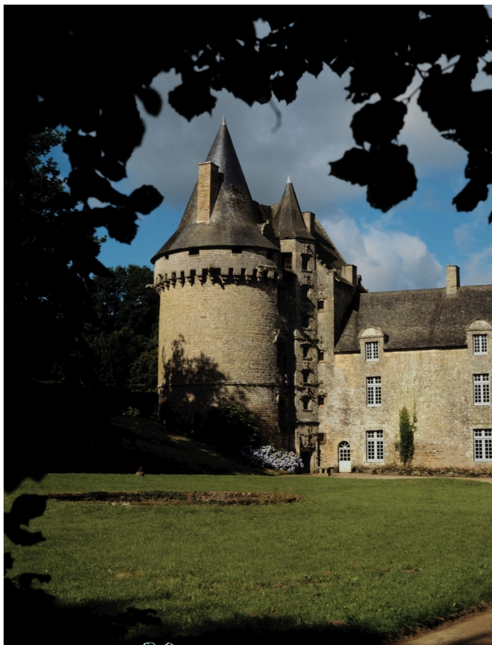
Tour sud et tour d'escalier : vue générale prise du sud-est (état en 1988)
