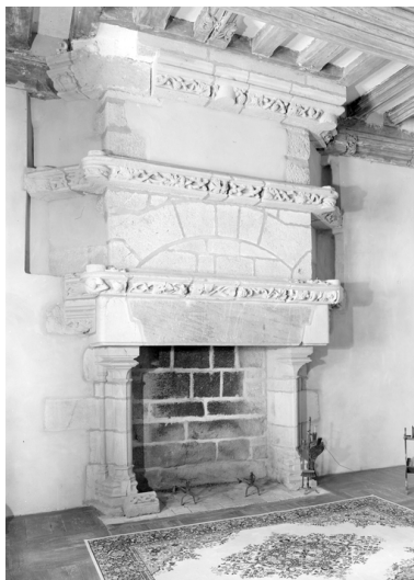
Tour sud, cheminée. Phot. Guy Artur, Phot. Norbert Lambart IVR53_19845600920V
