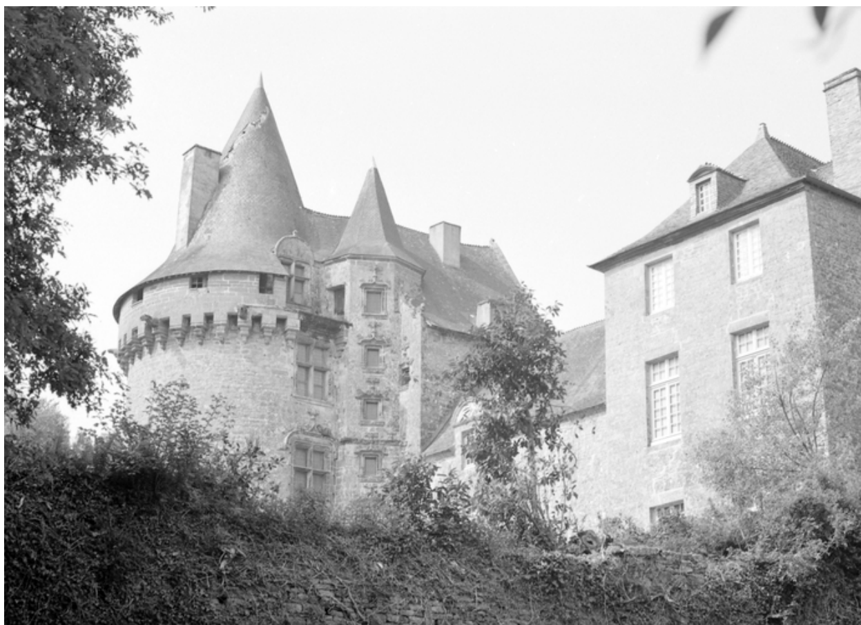
Vue générale prise du nord-est (état en 1984)
