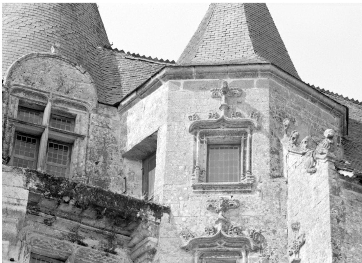
Tour d'escalier, baies des 6e et 7e niveaux : vue générale (état en 1984)
