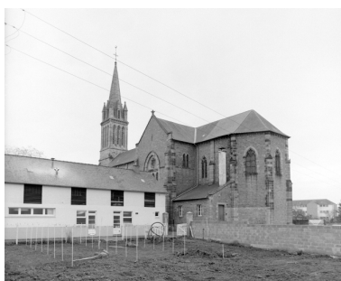
Elévation Nord-Ouest : vue générale Phot. Guy Artur, Phot. Norbert Lambart IVR53_19933500509X
