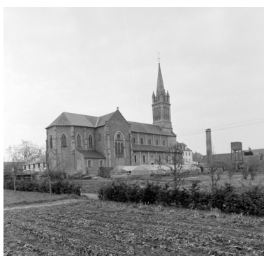
Elévation Sud-Ouest : vue générale Phot. Guy Artur, Phot. Norbert Lambart IVR53_19933500513X
