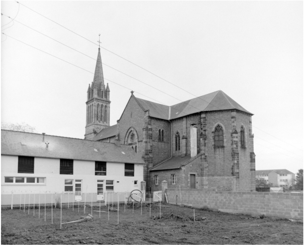
Elévation Nord-Ouest : vue générale
