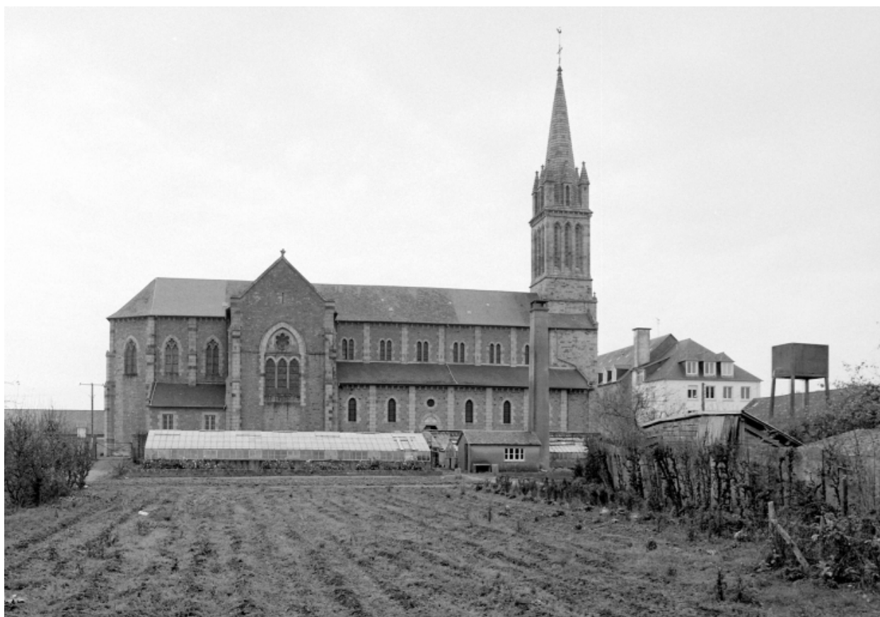
Elévation Sud-Ouest : vue générale
