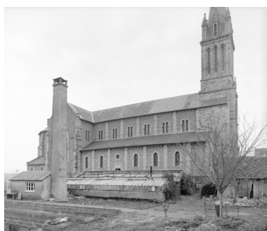
Elévation Sud-Est : vue générale Phot. Guy Artur, Phot. Norbert Lambart IVR53_19933500512X
