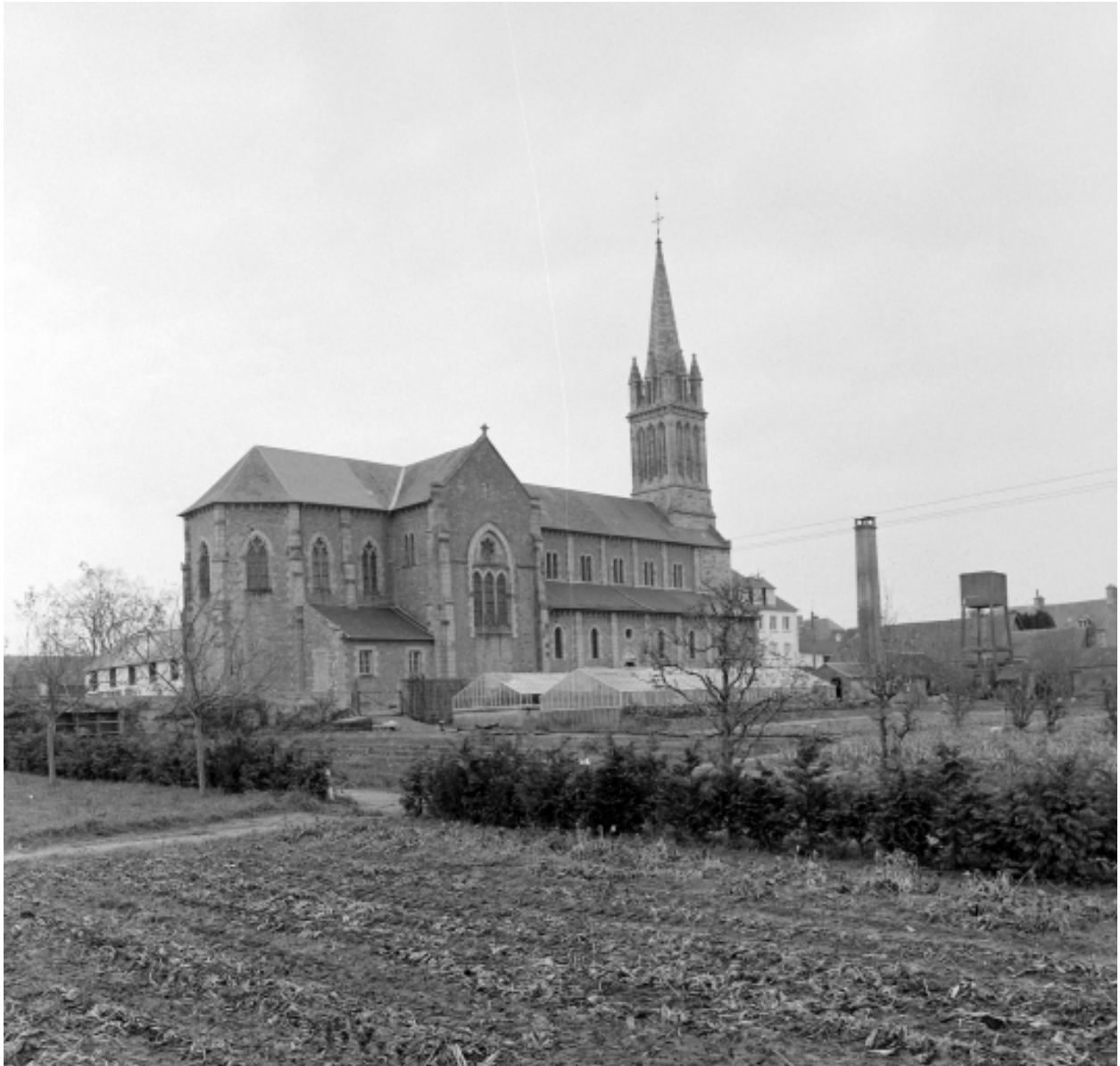
Elévation Sud-Ouest : vue générale
