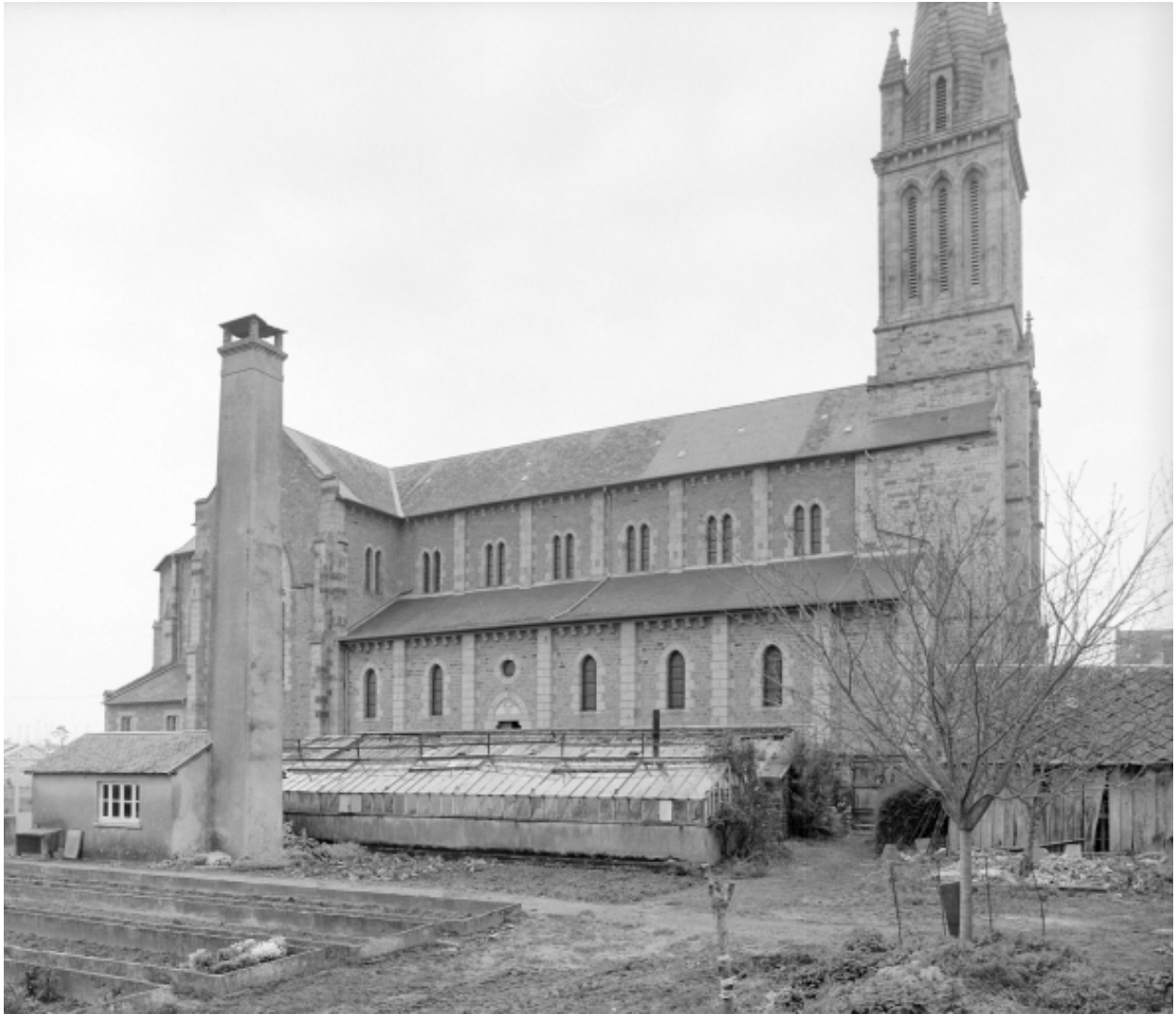
Elévation Sud-Est : vue générale
