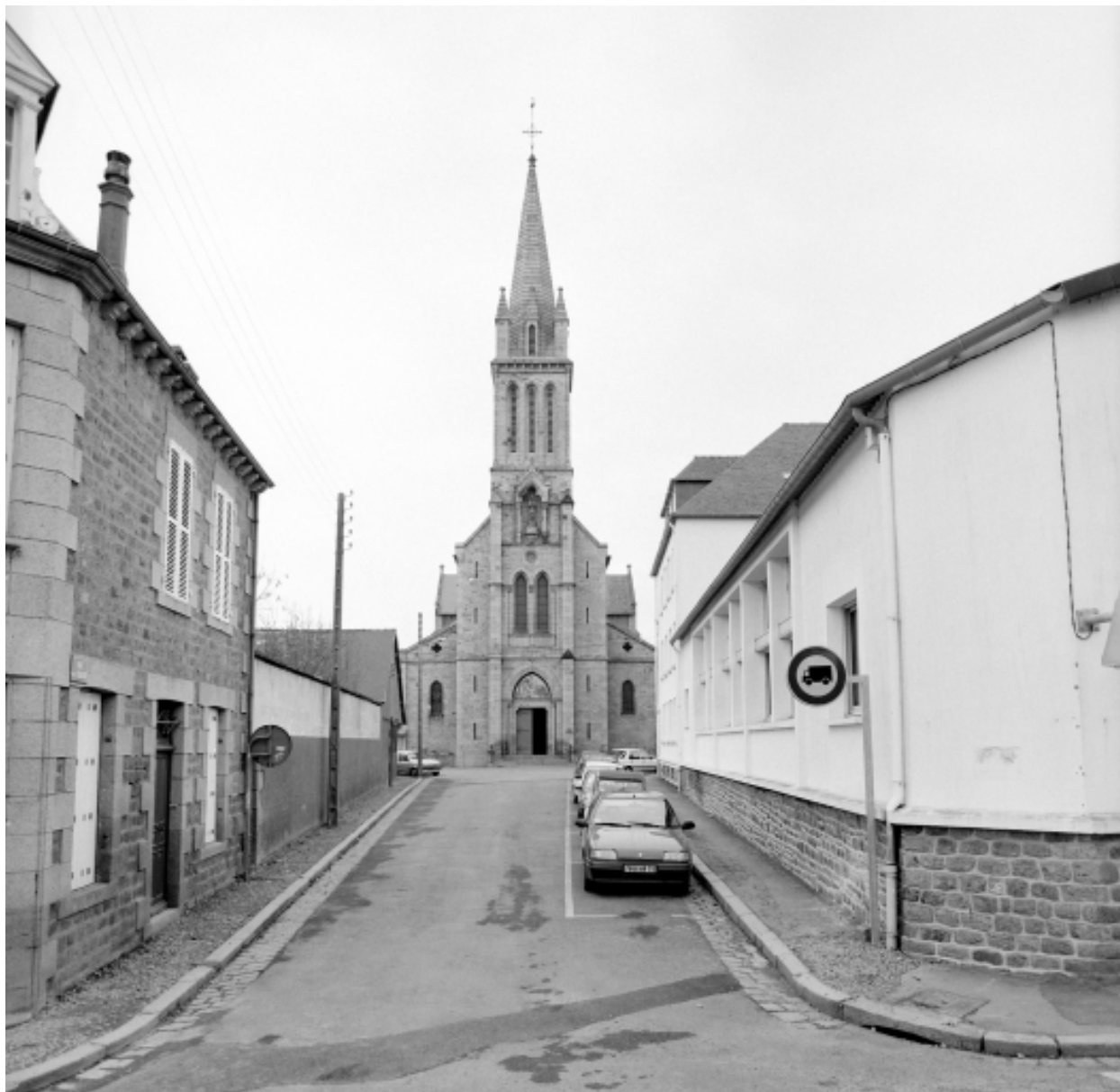
Elévation Est : vue générale
