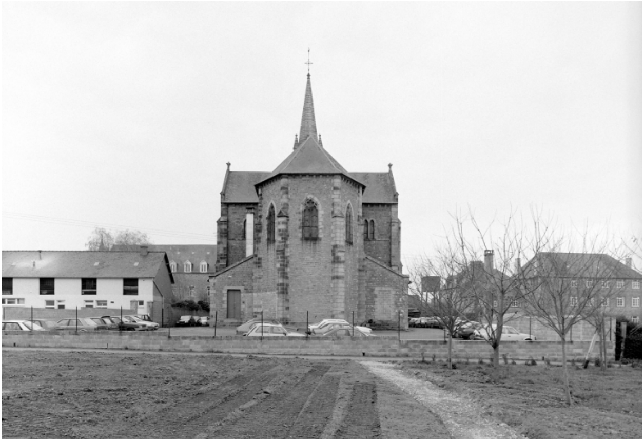
Elévation Ouest : vue générale
