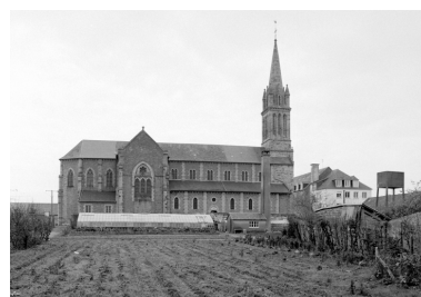
Elévation Sud-Ouest : vue générale Phot. Guy Artur, Phot. Norbert Lambart IVR53_19933500511X
