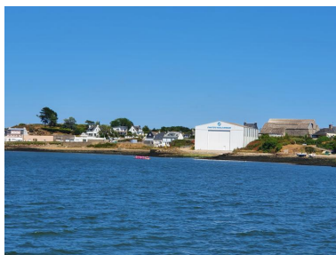
Le chantier naval Bernard Phot. Soazig Le Hénanff IVR53_20235605679NUCA
