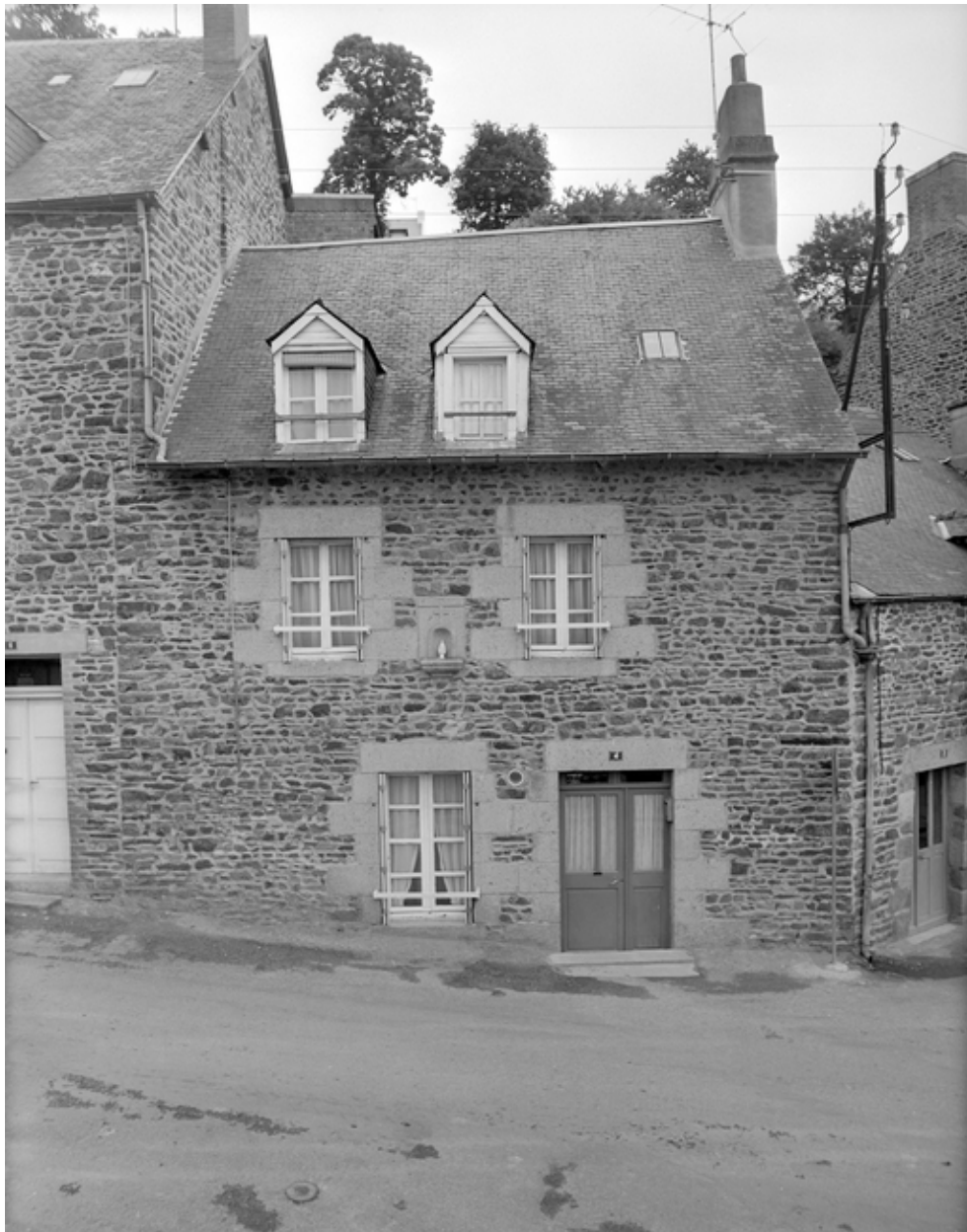
Elévation antérieure, vue générale.
