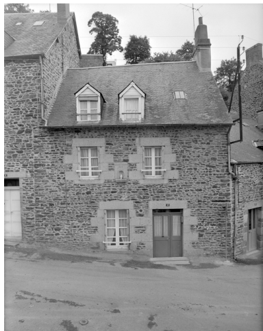
Élévation antérieure, vue générale.
