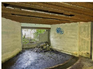
Vue de la chambre de tir (vers l'embrasure) : au centre, embrasure rectangulaire (partiellement murée par des parpaings) ; au sol, rainure pour la rotation de l'affût du canon ; au plafond, bouches d'aspiration des fumées de tir
