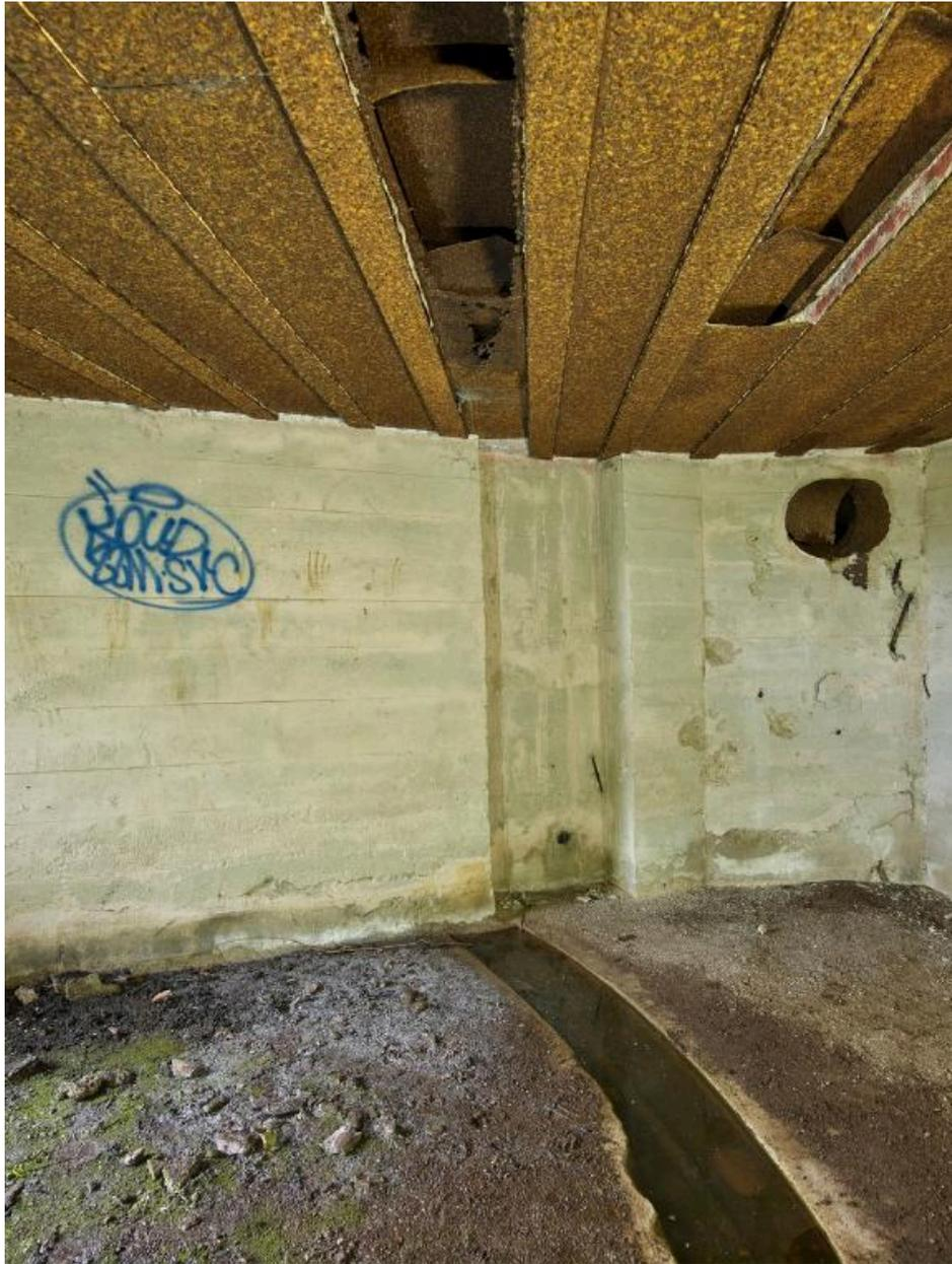
Vue de la chambre de tir : au sol, rainure pour la rotation de l'affût du canon ; au plafond, bouches d'aspiration des fumées protégées par des grilles. A droite : tuyau du système d'aspiration et d'évacuation des fumées de tir (le ventilateur a disparu)
