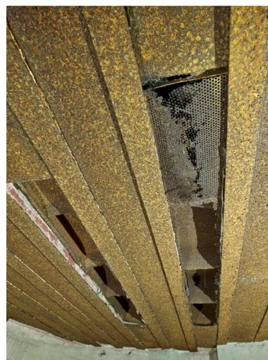
Vue de la chambre de tir : au plafond, bouches d'aspiration des fumées de tir protégées par des grilles. Afin de rendre homogène l'aspiration, les hottes sont divisées en quatre conduits par des lames
