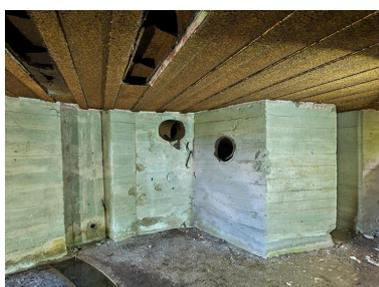
Vue de la chambre de tir : au sol, rainure pour l'affût du canon ; au plafond, bouches d'aspiration des fumées de tir ; au centre, tuyaux du système d'aspiration et d'évacuation des fumées de tir ; à droite, magasin à munitions Est
