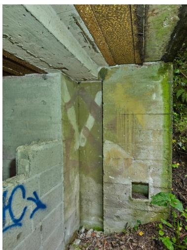
Vue de l'entrée (partiellement murée par des parpaings) : sur le mur Est, traces de peinture camouflage
