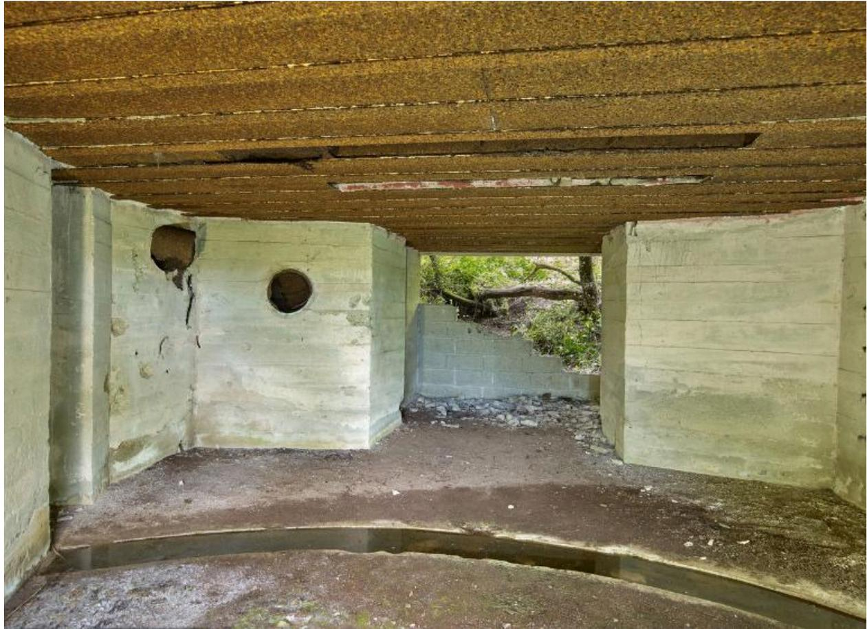
Vue de la chambre de tir (depuis l'embrasure vers la porte du bunker partiellement murée) : au sol, rainure pour la rotation de l'affût du canon ; à gauche : tuyaux du système d'aspiration et d'évacuation des fumées de tir (le ventilateur a disparu)
