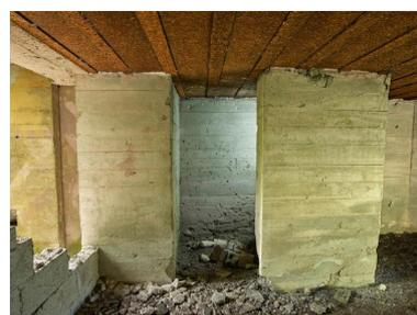
Vue du magasin à munitions Ouest. Des traces d'impacts sont visibles sur les murs en béton et sur le plafond constitué de poutrelles d'acier. Ce type de bunker comprend deux soutes à munitions situées de part et d'autre du passage d'entrée
