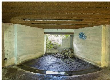
Vue de la chambre de tir (vers l'embrasure) : au centre, embrasure rectangulaire (partiellement murée par des parpaings) ; au sol, rainure pour la rotation de l'affût du canon ; au plafond, bouches d'aspiration des fumées de tir. A gauche : fixations du boîtier de connexion téléphonique
