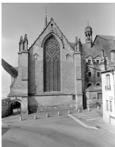
Elévation Nord : vue générale Phot. Guy Artur, Phot. Norbert Lambart IVR53_19953500244X
