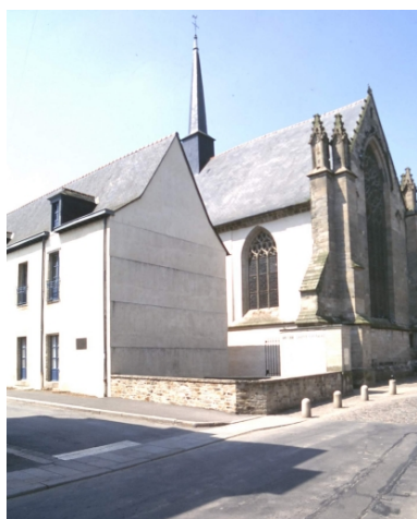
Pignons sud est : vue générale. Phot. Claude Quillivic IVR53_19943503060ZA
