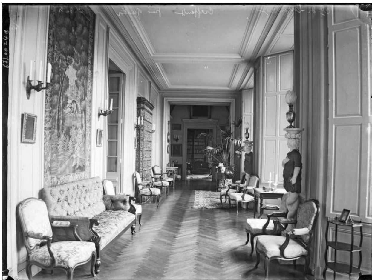
Intérieur : la galerie
