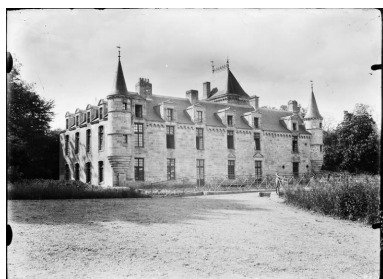
Façade principale Phot. Auteur inconnu (phototype/graphique) IVR53_2052210501NUCB
