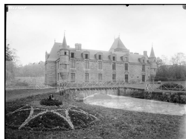
Vue d'ensemble Phot. Auteur inconnu (phototype/graphique) IVR53_2052210500NUCB
