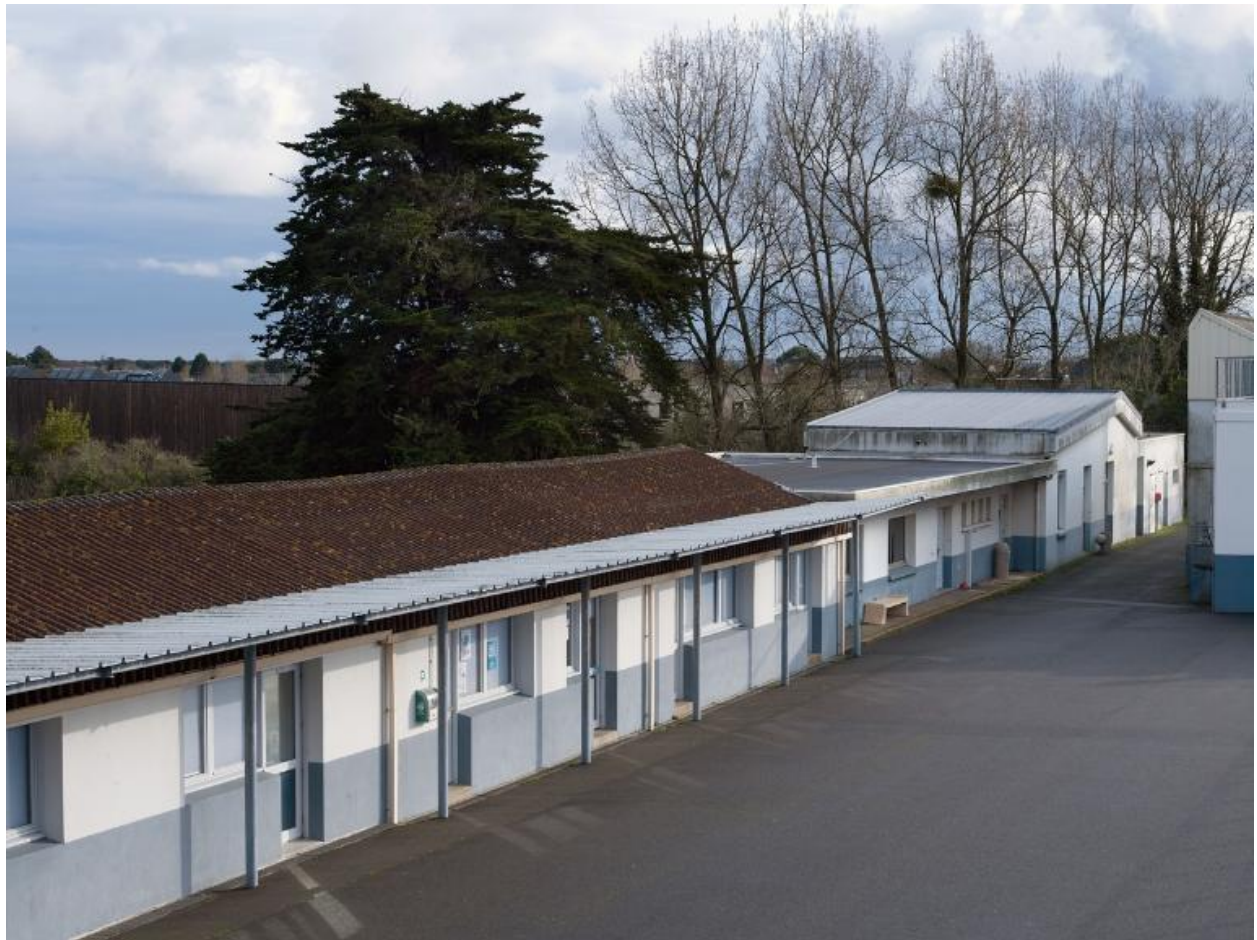
Extensions de 1985 et 1987 : "foyer-bar-cinéma" et CDI, façade sud, prise de l'étage de l'internat. M. Ysvelain et Cl. Blin, architectes.
