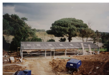
Construction de la ferme aquacole, 1993-1994.
