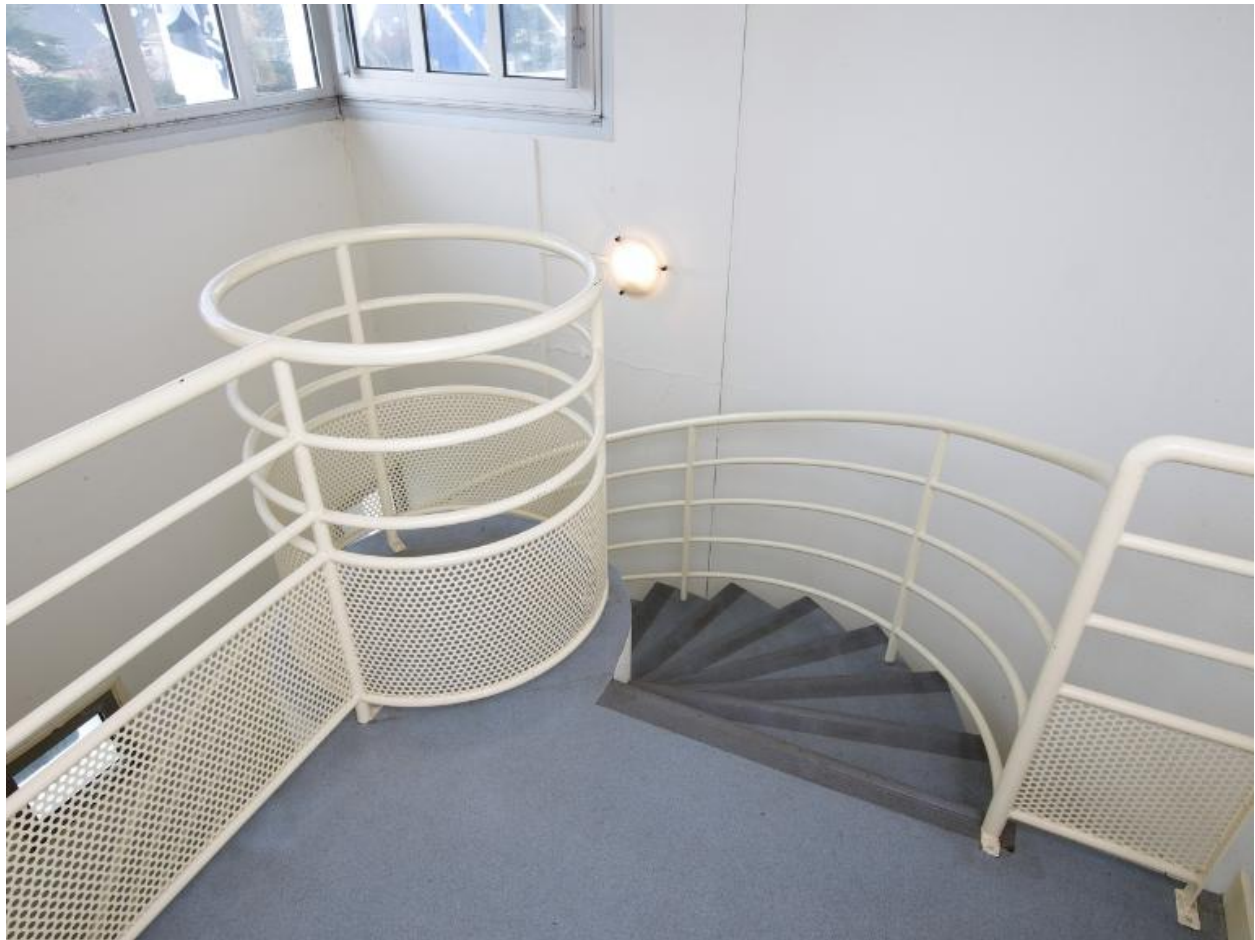
Palier supérieur de l'escalier en vis de la tourelle. Noter le dessin soigné des rampes et garde-corps.
