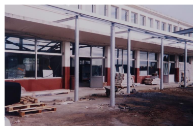
Travaux de restructuration en 1998-1999. Création d'une galerie couverte et fermée, au rez-de-chaussée de la façade nord du bâtiment d'externat, accueil, administration.
