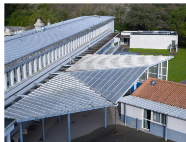
L'internat (Jacques Deyrolle architecte) : façade est vue depuis la tourelle. A l'arrière plan, nouvelle salle de classe "Île-de-Groix" (D1). Noter, par-delà la galerie hors œuvre, le long de l'internat, l'adjonction d'un préau couvert de tôle et plexiglas. Phot. Bernard Bègne IVR53_20195600675NUCA
