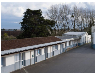
Extensions de 1985 et 1987 : "foyer-bar-cinéma" et CDI, façade sud, prise de l'étage de l'internat. M. Ysvelain et Cl. Blin, architectes.
