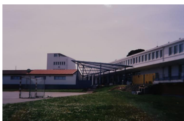
Vue d'ensemble prise du nord, après les travaux de restructuration de 1998-1999. L'agrandissement du bâtiment du CDI et du foyer, est visible à la couleur vive de la toiture, ainsi que le nouveau préau, qui relie ce dernier à l'internat.
