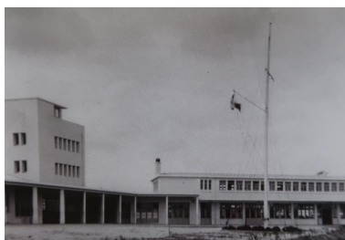
Vue d'ensemble prise depuis la cour, peu après la construction. A gauche, l'externat et sa tourelle, à droite l'internat. La galerie de circulation n'est pas fermée. Noter la présence d'un mat haubané qui renforce les accents maritimes de l'école. IVR53_20215605033NUCA
