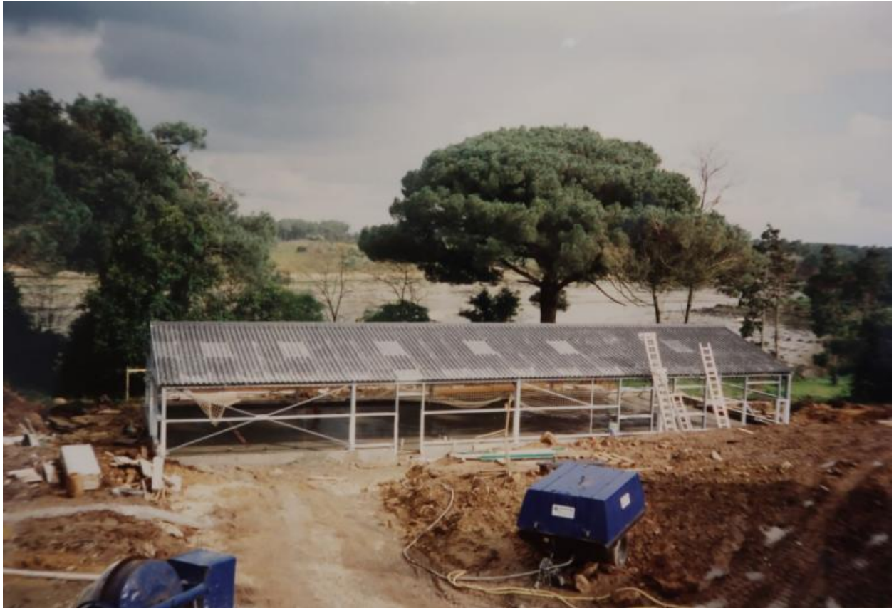
Construction de la ferme aquacole, 1993-1194.
