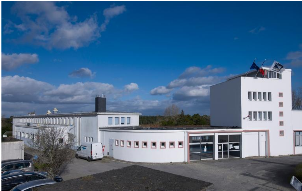
Vue d'ensemble service de restauration et administration (bâtiments A3 et A1), vue prise du sud.
