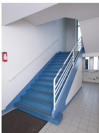
Escalier de l'internat : rez-de-chaussée. Phot. Bernard Bègne IVR53_20195600670NUCA
