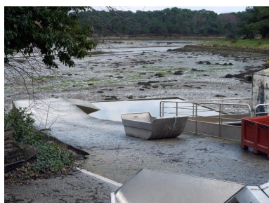
Bassin ostréicole. Phot. Bernard Bègne IVR53_20195600700NUCA
