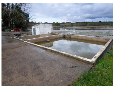
Bassin ostréicole. Phot. Bernard Bègne IVR53_20195600701NUCA
