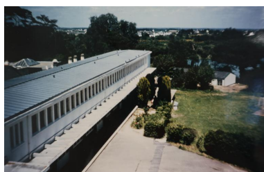
Façade est de l'internat et auvent sur toute la longueur, avant la restructuration de 1998-1999.
