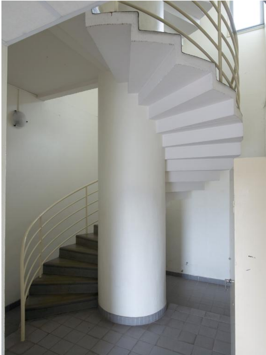
Escalier en vis dans la tourelle.
