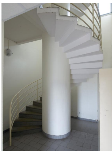
Escalier en vis dans la tourelle. Phot. Bernard Bègne IVR53_20195600667NUCA
