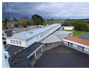
Vue d'ensemble de la cour prise de la tour (depuis le sud) : à gauche, l'internat (J. Deyrolle, architecte, 1952). A droite : extensions de 1985 et 1987 : "foyer-bar-cinéma" et CDI, façade sud, prise de l'étage de l'internat (M. Yvelain et Cl. Blin, architectes.), à l'arrière plan, salle Île-de-Groix et logement de fonction.
