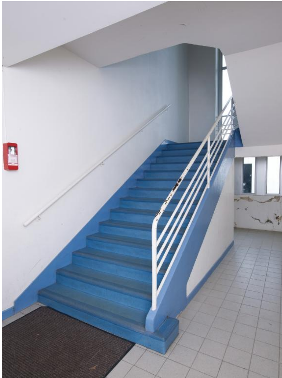
Escalier de l'internat : rez-de-chaussée.
