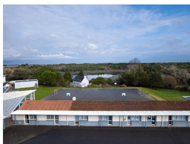
Vue d'ensemble prise d'un étage de la tour depuis le sud). Au premier plan, façade sud des extensions de 1985 et 1987 : "foyer-bar-cinéma" et CDI, façade sud (M. Ysvelain et Cl. Blin, architectes). A l'arrière plan, la salle Île-de-Groix, le logement de fonction et la rivière du Sac'h.
