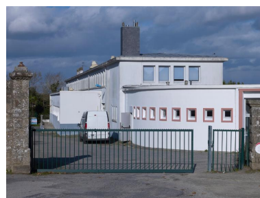
Administration et service de restauration (bâtiments A1 et A3), vue prise du sud.
