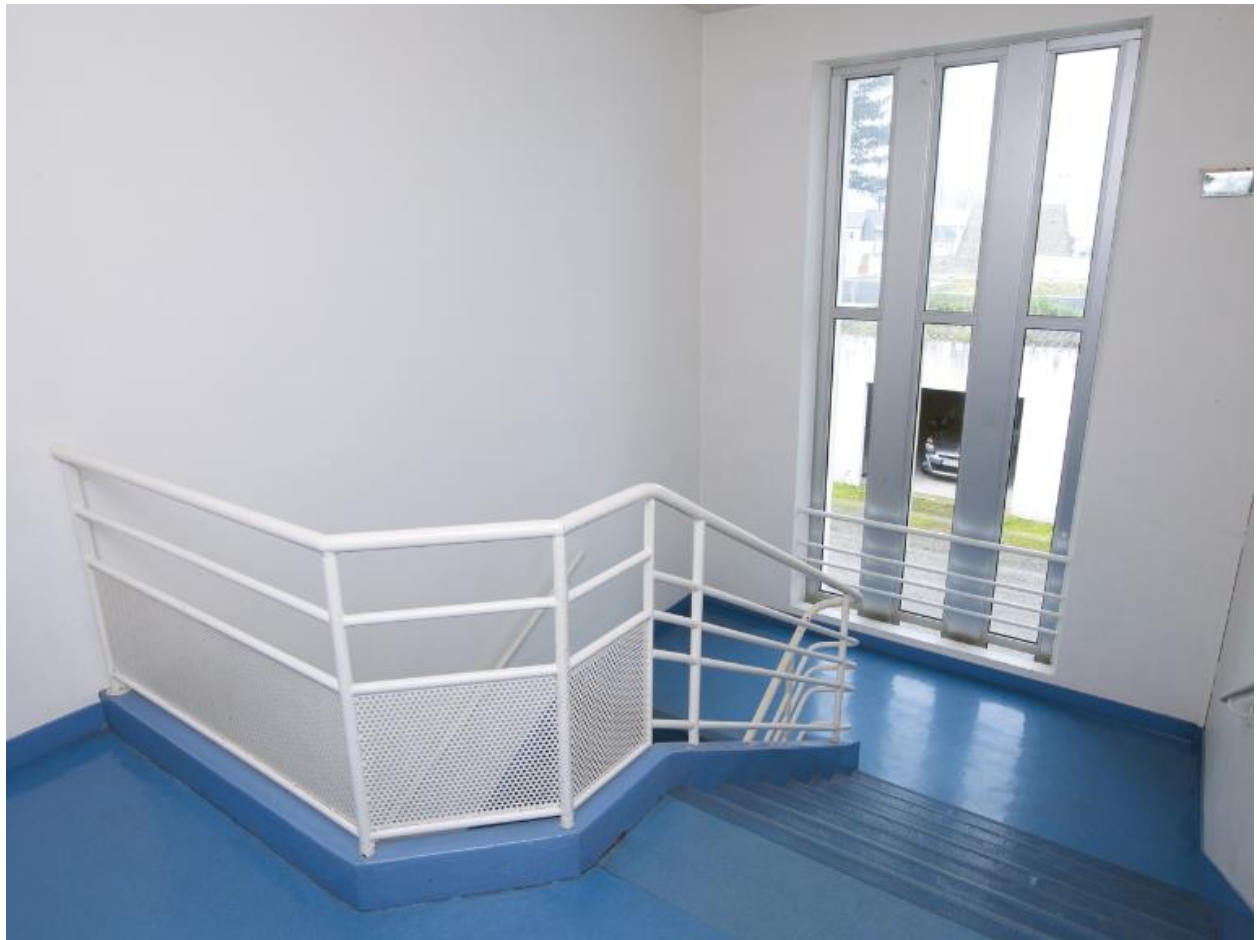
Escalier de l'internat, premier étage.
