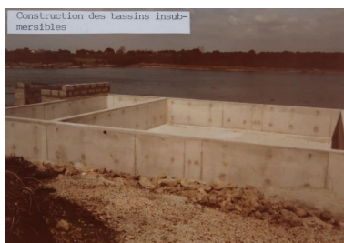
"Construction des bassins insubmersibles". Les plans de cet aménagement datent de 1983.
