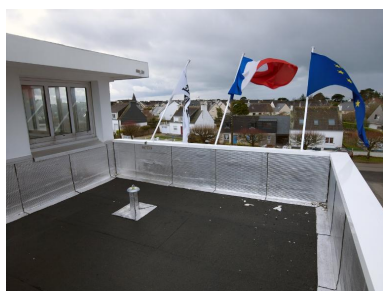
Toit terrasse de la tourelle de l'externat, pris du nord vers le sud. Phot. Bernard Bègne IVR53_20195600683NUCA
