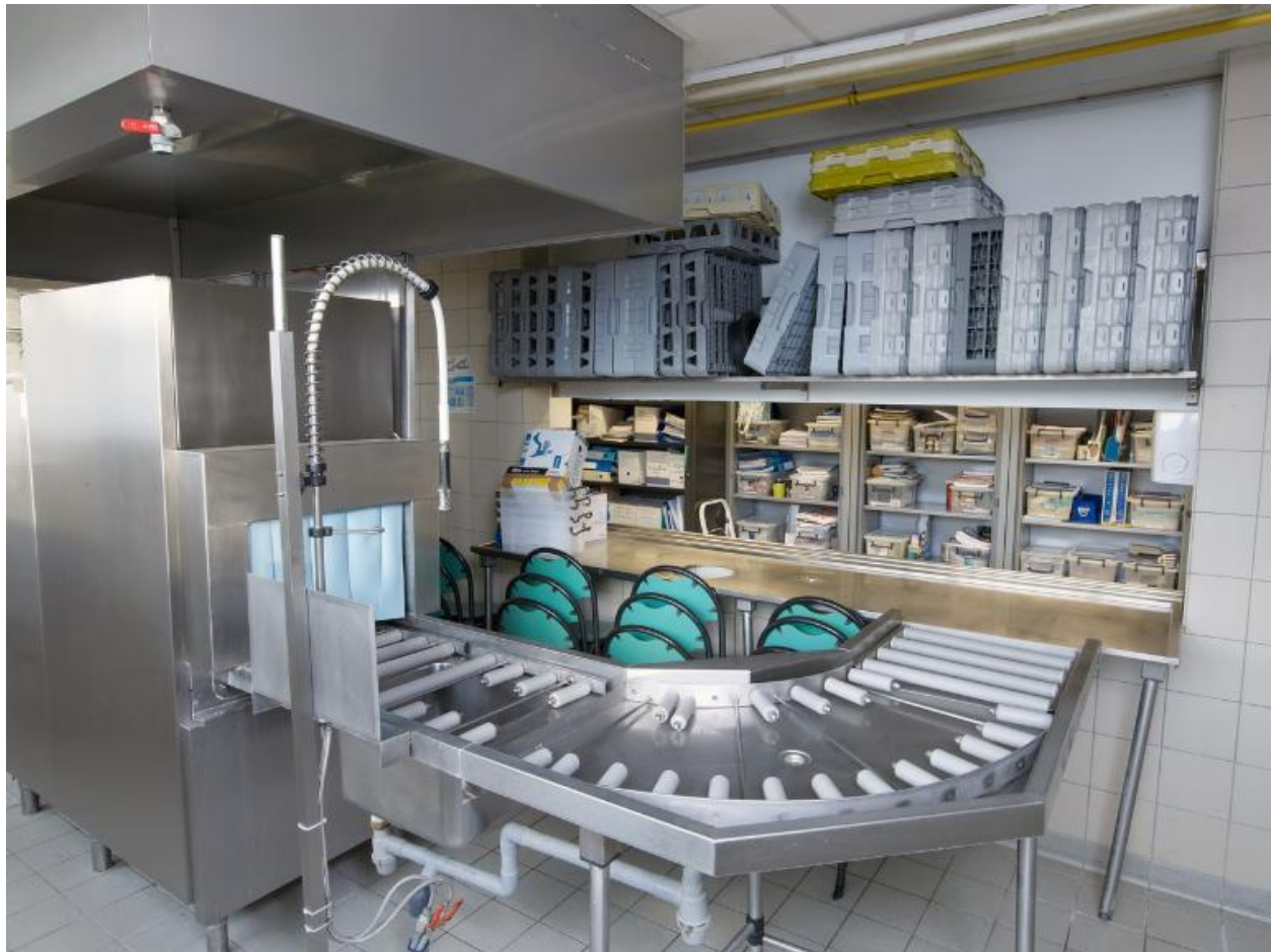
Ancien service de restauration : machine à laver la vaisselle (la restauration scolaire est, en 2021, mutualisée avec le lycée professionnel Emile James).
