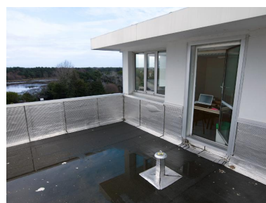
Toit terrasse de la tourelle de l'externat, pris du sud-ouest vers le nord-est.
