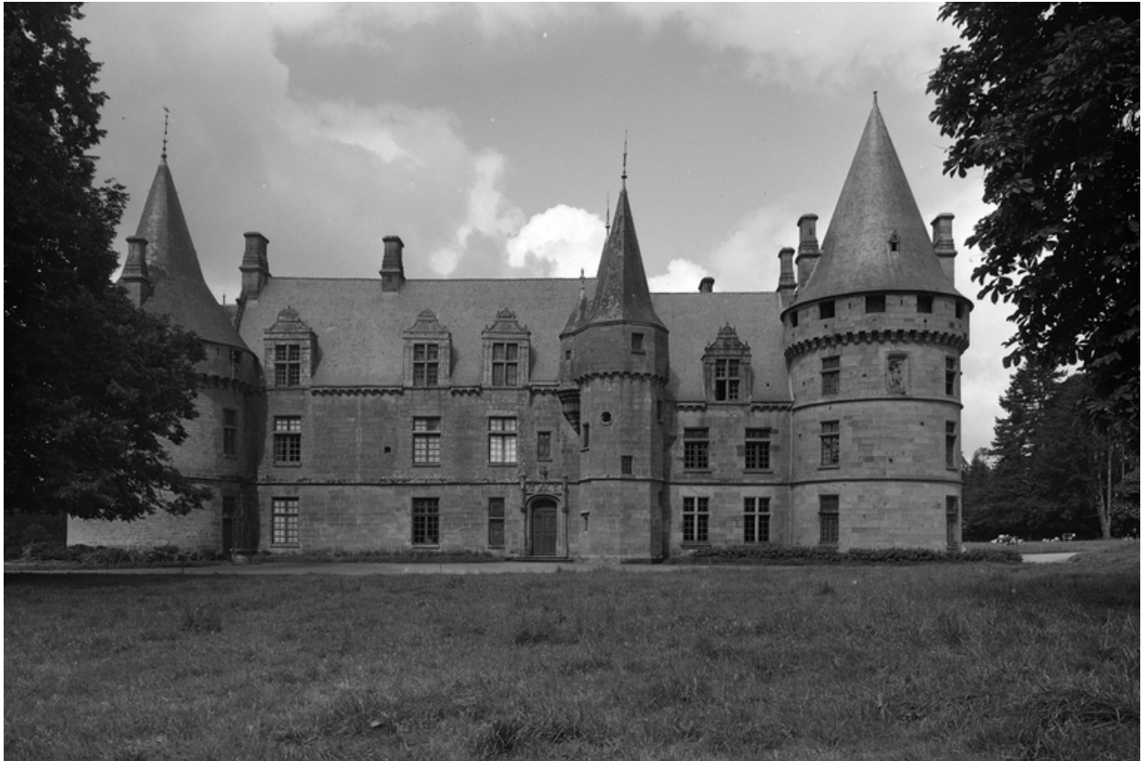
Elévation antérieure, vue générale.
