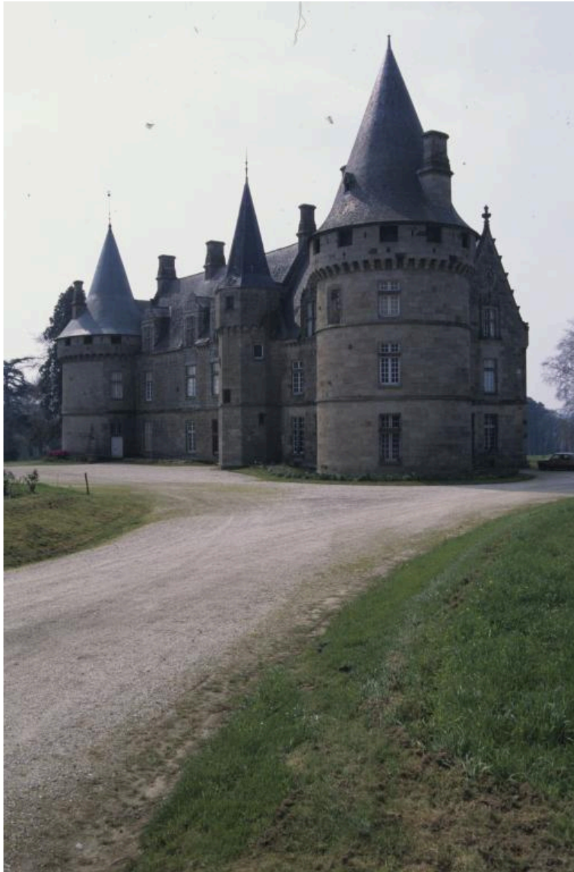
Vue générale prise du nord-est.
