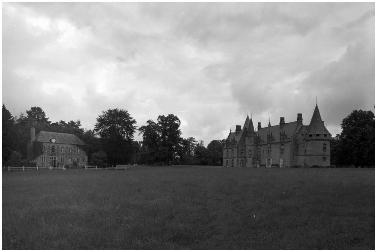
Vue de situation sud-ouest.
