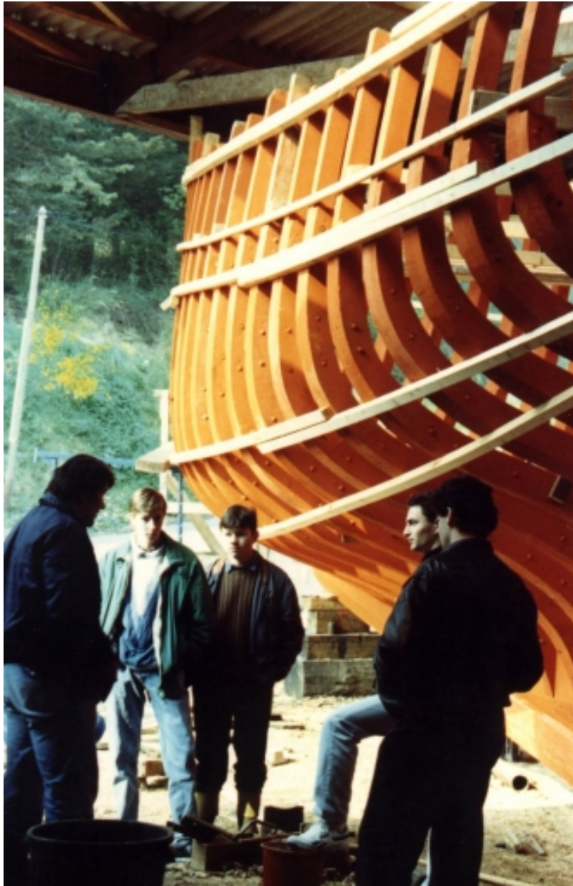
Vue de la coque en construction : remarquer le retour de galbord (collection particulière, Association le Grand Léjon)
