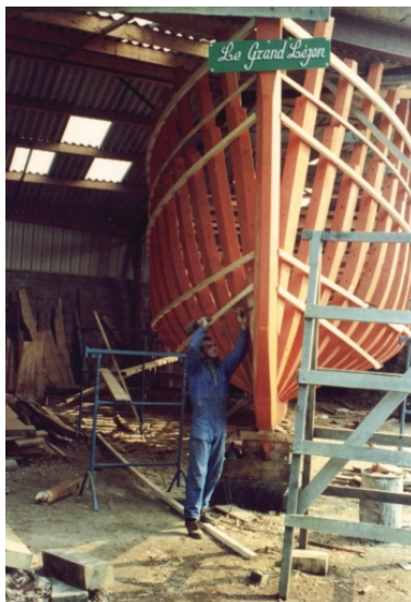
Vue de la charpente avant de la coque membrée avec les lisses, au chantier Clochet (collection particulière, Association le Grand Léjon) Repro. Guy Prigent, Autr. Stéphanie (auteur) Huet IVR53_20082213351NUCB
