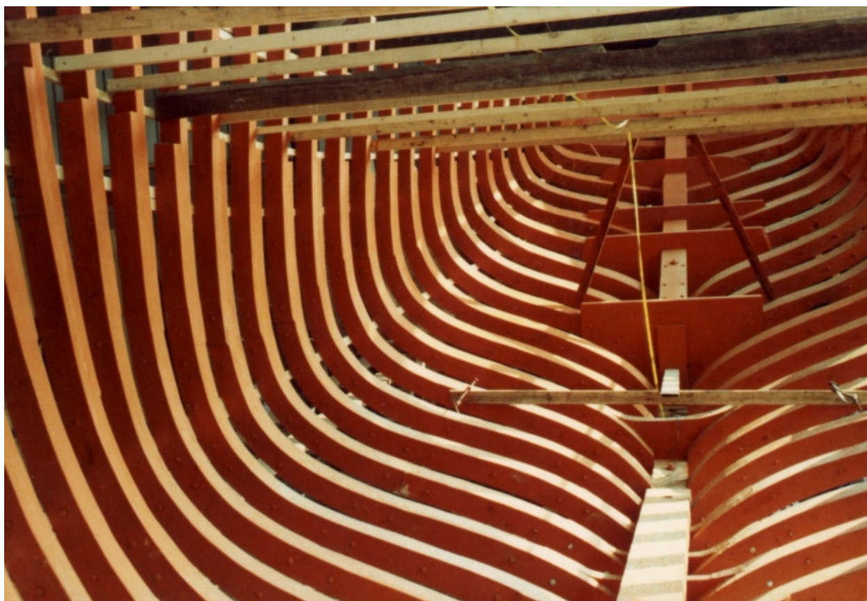
Vue de la charpente intérieure de la coque entièrement membrée et varanguee, au chantier Clochet (collection particulière, Association le Grand Léjon)
