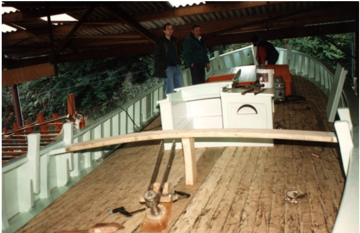
Vue du plan de pont en cours d'aménagement (collection particulière, Association le Grand Léjon)
