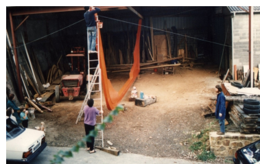
Vue de la charpente axiale en cours de montage au chantier Clochet en 1989 (collection particulière, Association le Grand Léjon) Repro. Guy Prigent, Autr. Stéphanie (auteur) Huet IVR53_20082213350NUCB
