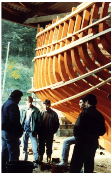
Vue de la coque en construction : remarquer le retour de galbord (collection particulière, Association le Grand Léjon) Repro. Guy Prigent, Autr. Stéphanie (auteur) Huet IVR53_20082213354NUCB
