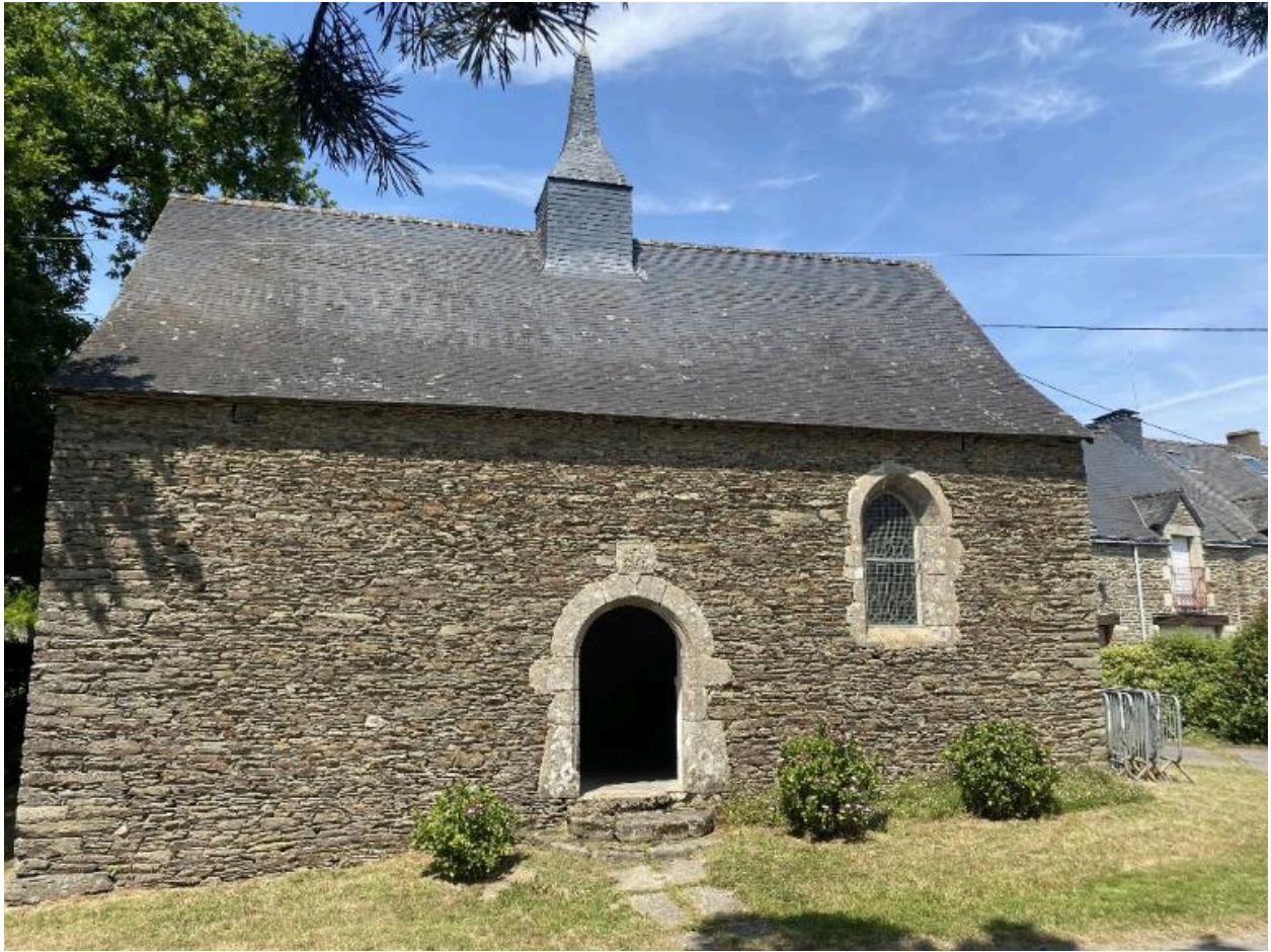
Élévation sud, vue générale
