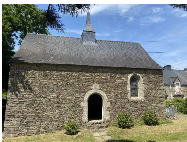
Élévation sud, vue générale Phot. Baptiste Oligo IVR53_20265610999NUCA
