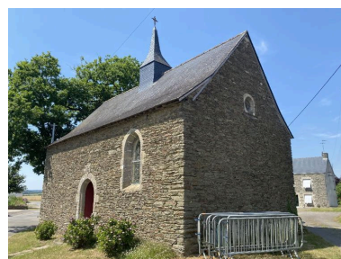
Vue sud-est Phot. Baptiste Oligo IVR53_20265611000NUCA
