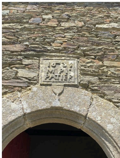
Inscription et calice de la porte de l'élévation sud Phot. Baptiste Oligo IVR53_20265611001NUCA
