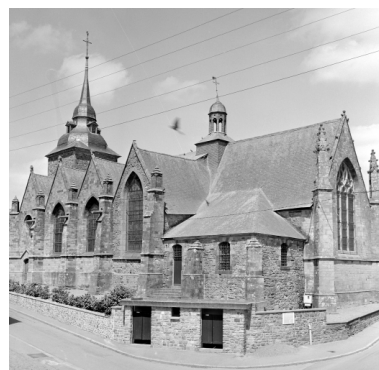
Elévation Sud-Est : vue générale Phot. Guy Artur, Phot. Norbert Lambart IVR53_19943501348X
