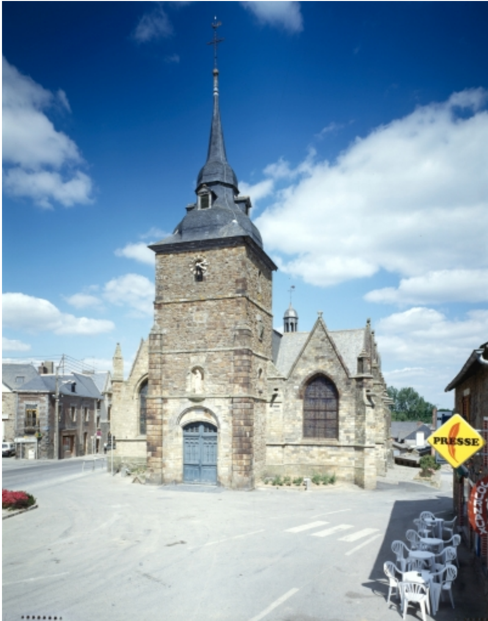
Elévation Ouest : vue générale
