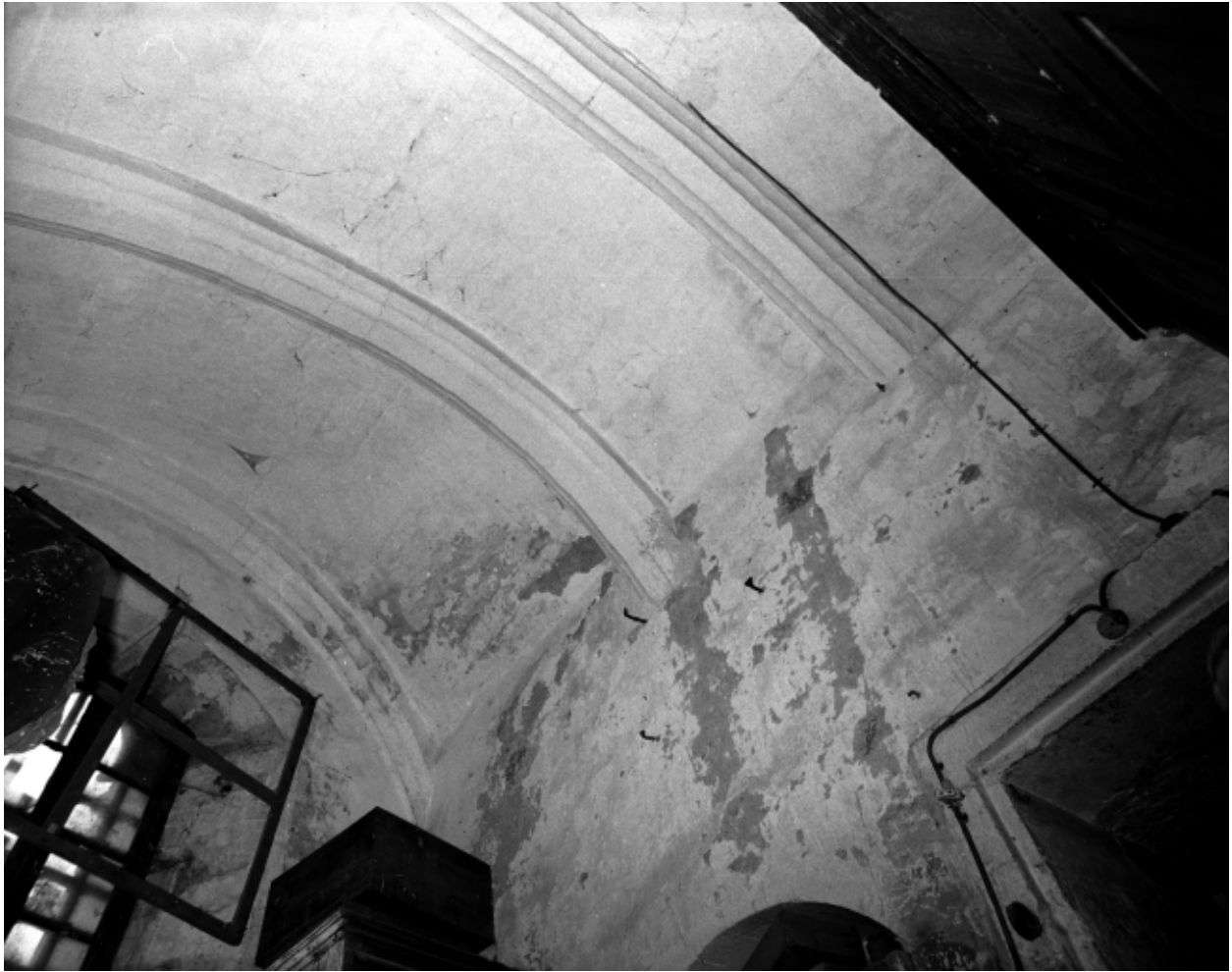
Vue de détail de la voûte.
