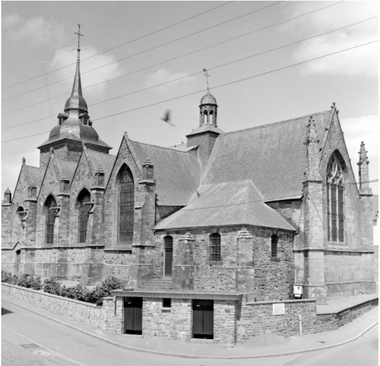
Elévation Sud-Est : vue générale
