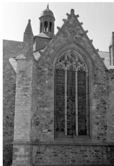
Vue générale d'un côté de la toiture avec vitrail. Phot. Bernard Bègne IVR53_19953500414X
