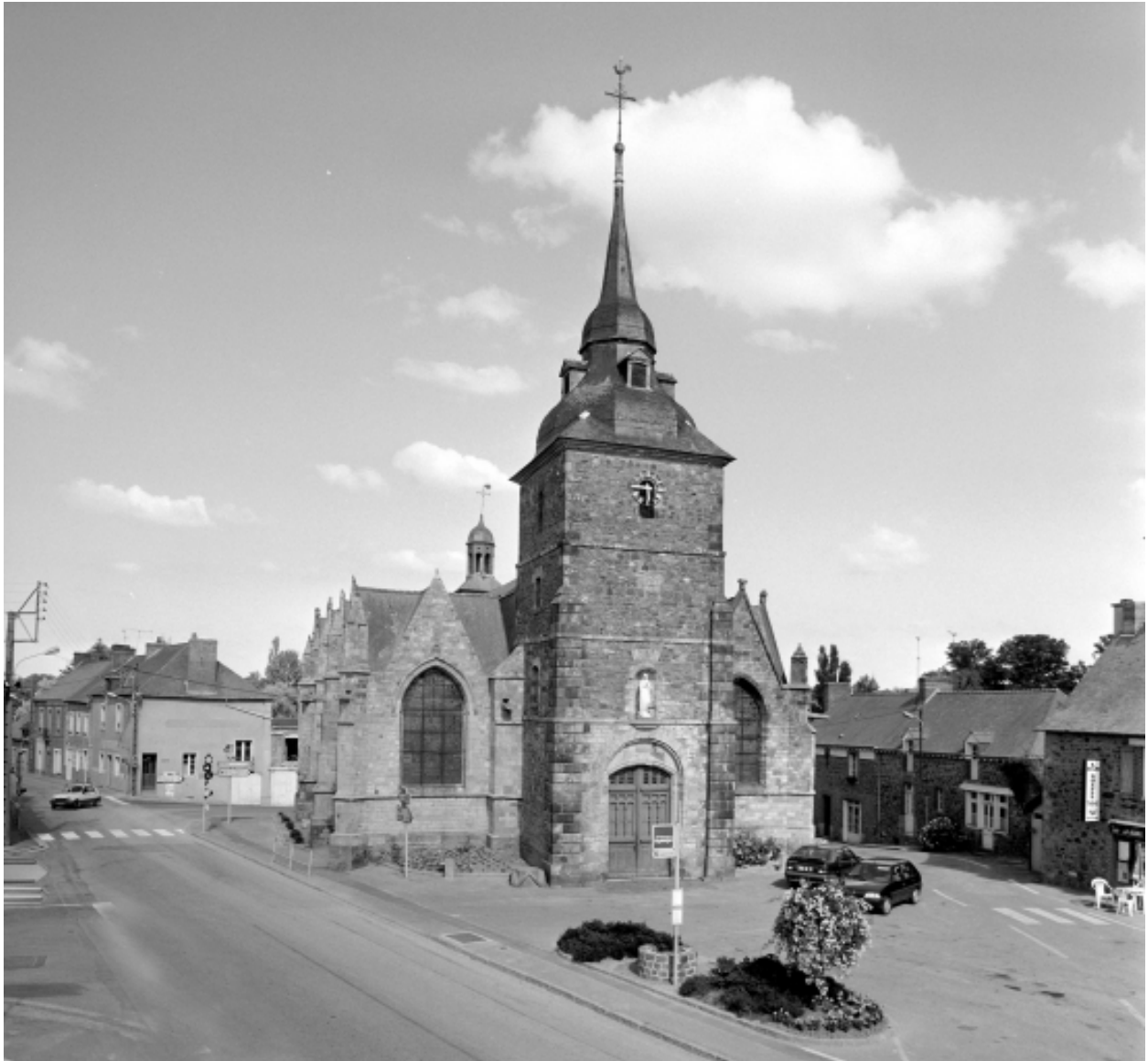
Elévation Ouest : vue générale
