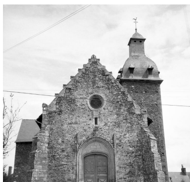
Portail ouest, état en 1972 Phot. Cl. Brouard IVR53_19723505007Z
