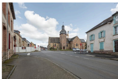
Vue générale depuis la rue du Parc Phot. Delia Gaulin-Crespel IVR53_20183500124NUCA
