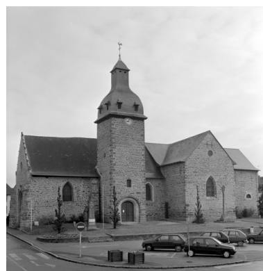
Élévation Sud : vue générale, état en 1972 Phot. Guy Artur, Phot. Norbert Lambart IVR53_19943500672X
