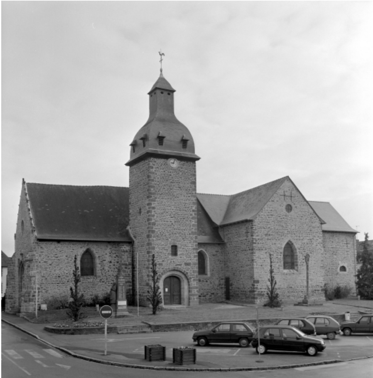
Elévation Sud : vue générale, état en 1972
