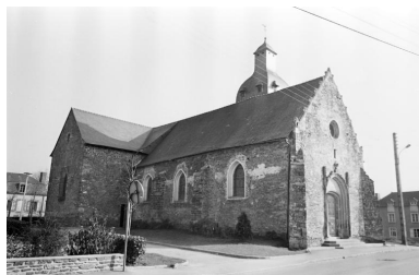
Elévation nord, état en 1972 Phot. Christine Bossard IVR53_19723505144Z
