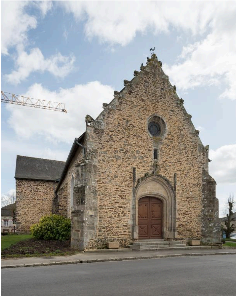
Elévation ouest et portail
