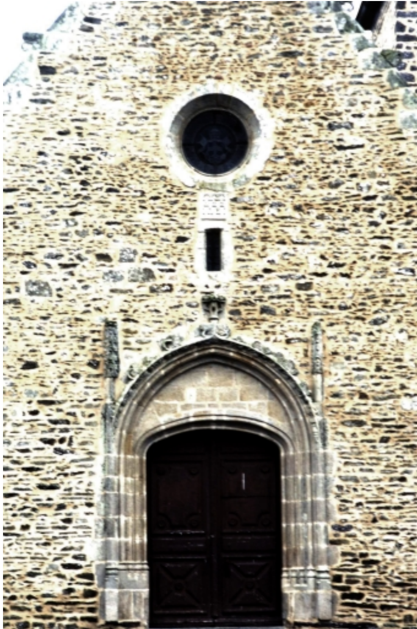
Elévation ouest : vue rapprochée, état en 1994
