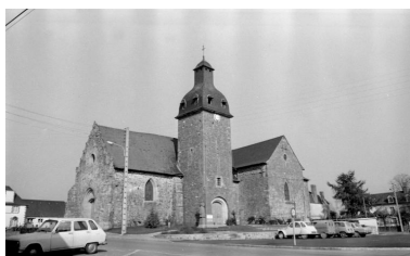
Vue générale de l'élévation sud, état en 1972 Phot. Christine Bossard IVR53_19723505143Z
