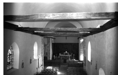
Entraits à engoulants de la nef, état en 1972 Phot. Christine Bossard IVR53_19723505134Z
