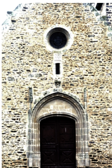
Elévation ouest : vue rapprochée, état en 1994 Phot. Claude Quillivic IVR53_19943502889ZA
