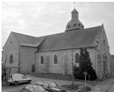
Elévation Nord : vue générale, état en 1972 Phot. Guy Artur, Phot. Norbert Lambart IVR53_19943500673X
