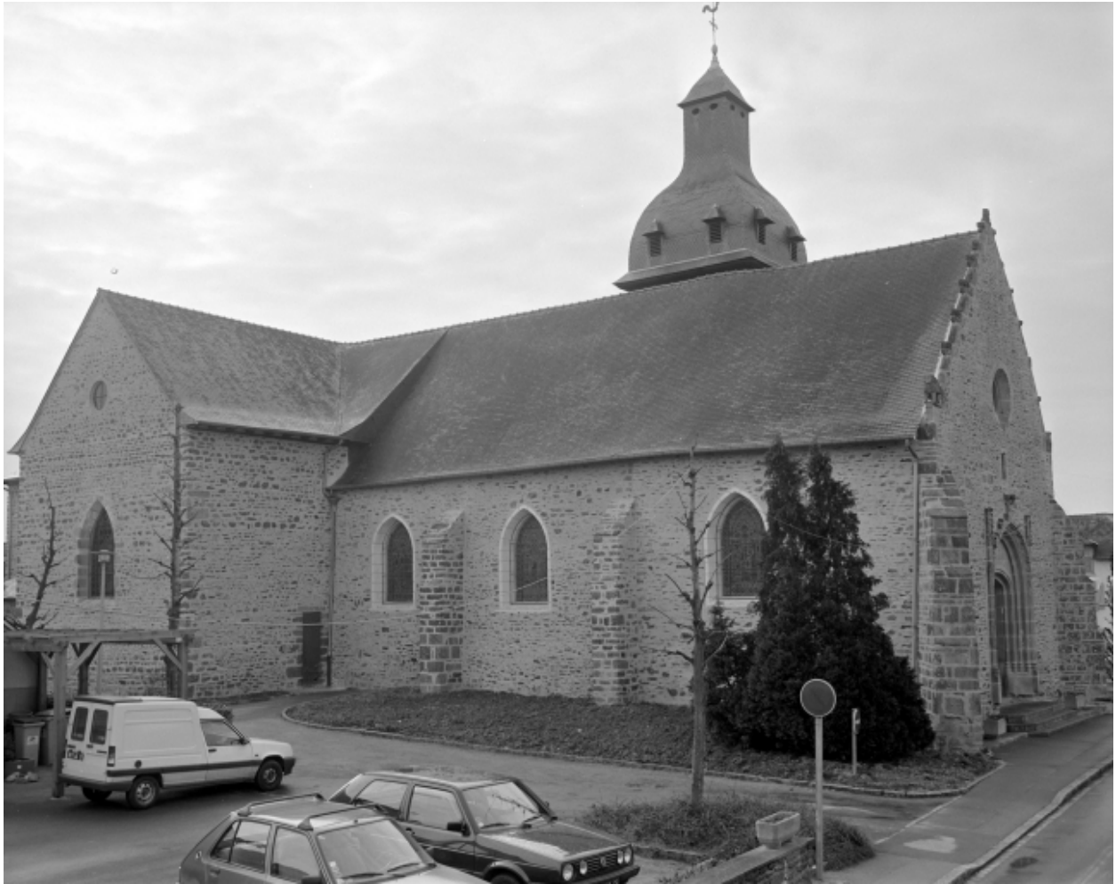
Elévation Nord : vue générale, état en 1972
