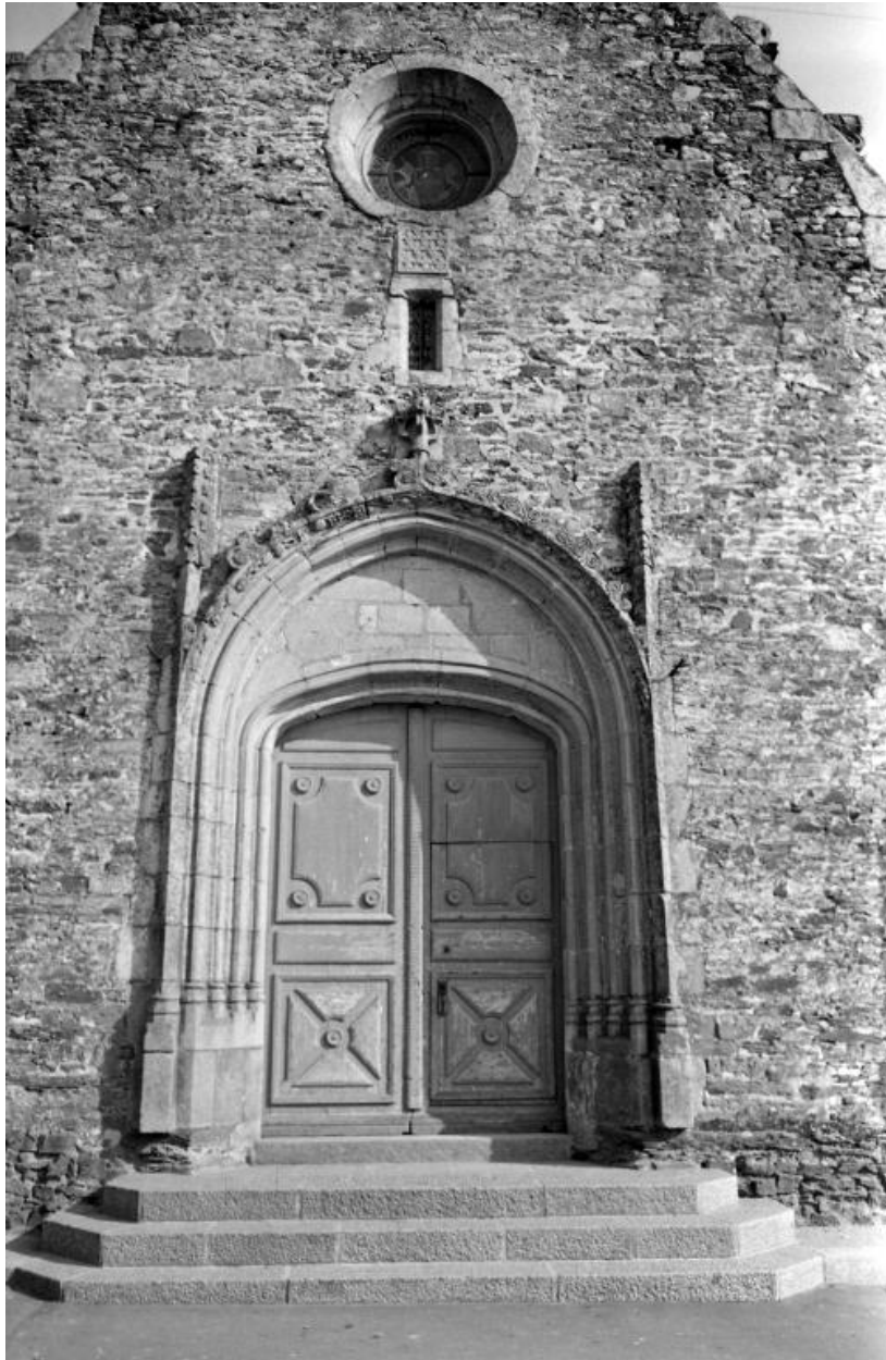
Portail de la façade ouest, état en 1972
