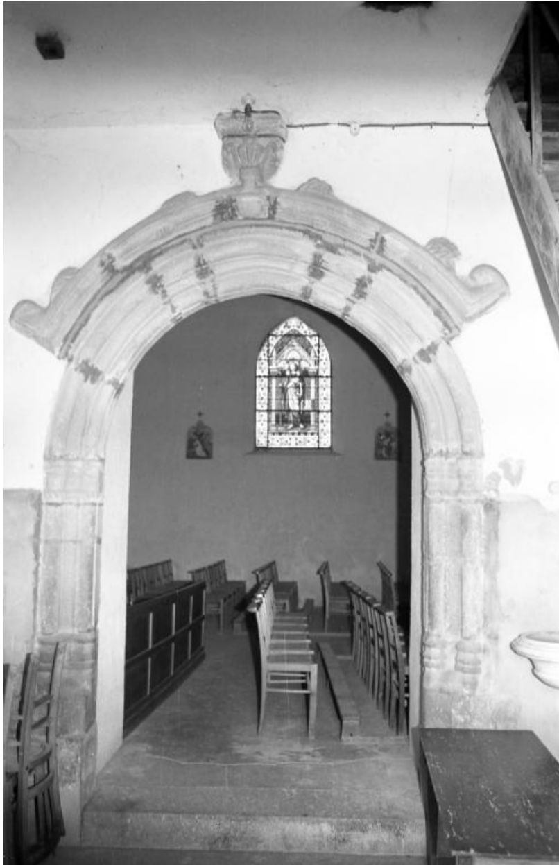
Portes à l'intérieur du porche, état en 1972
