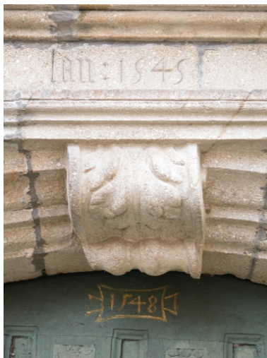
Porte nord ; détail Phot. Claude Quillivic IVR53_20043515540NUCA
