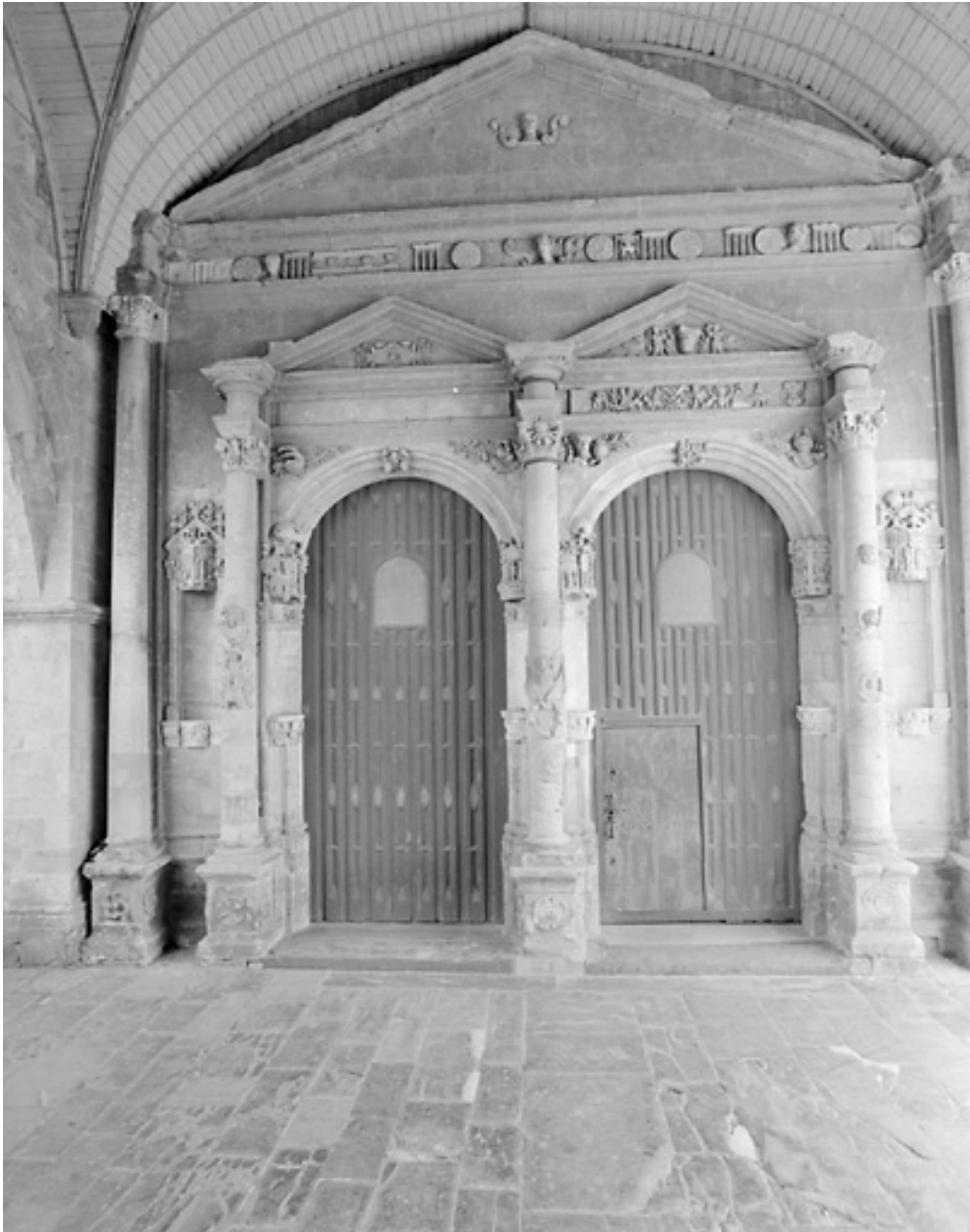
Porche ouest, porte principale
