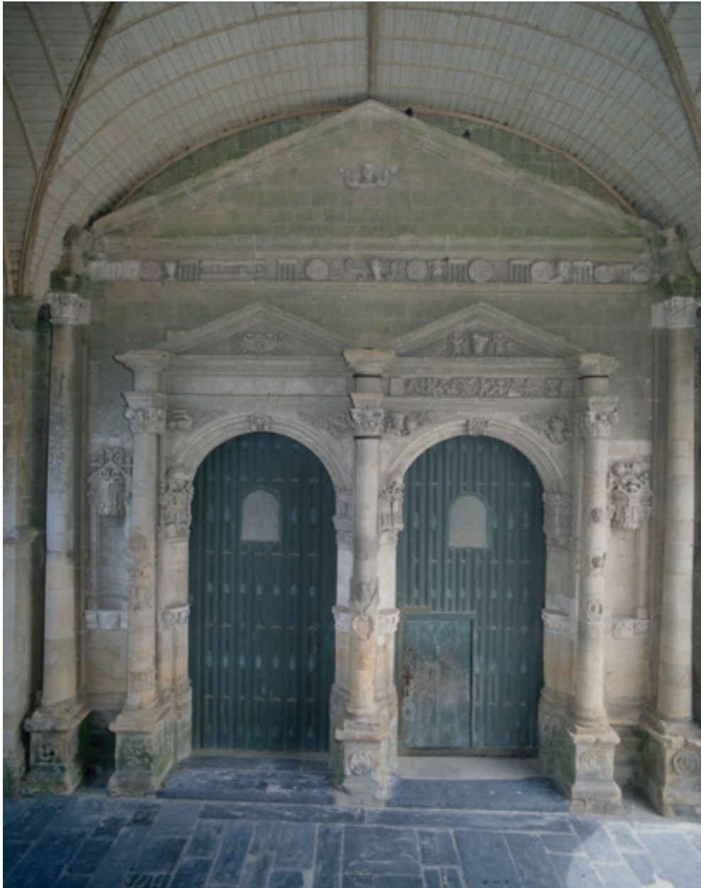
Porche ouest, porte principale
