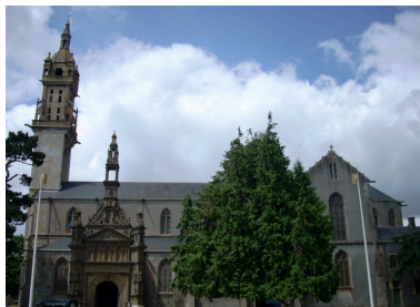
Landerneau, église Saint-Houardon : élévation sud Phot. Gwénaél Fauchille IVR53_20082906422NUCA
