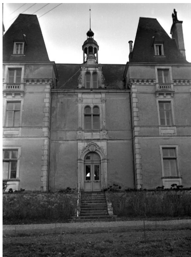
Façade nord (état en 1973) Phot. Liliane Auberge IVR53_19733505544Z
