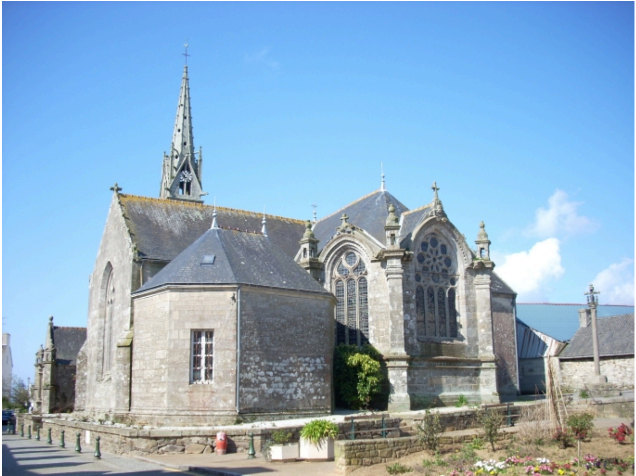
Plomodiern, église paroissiale Saint-Mahouarn : vue générale sud-est
