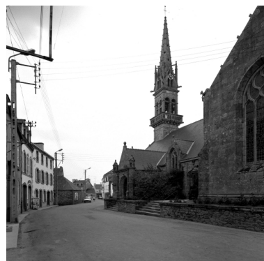
Plomodiern, église paroissiale Saint-Mahouarn : vue générale sud-est, état en 1972 Phot. François Dagorn IVR53_19722900295V
