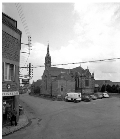
Plomodiern, église paroissiale Saint-Mahouarn : vue générale sud-est, état en 1972 Phot. François Dagorn IVR53_19722900287V
