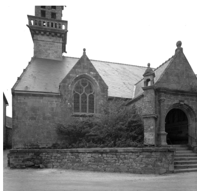
Plomodiern, église paroissiale Saint-Mahouarn : façade sud, partie gauche, état en 1972 Phot. François Dagorn IVR53_19722900296V
