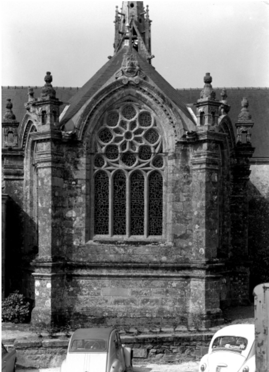
Plomodiern, église paroissiale Saint-Mahouarn : façade est, chevet, vue est, état en 1972
