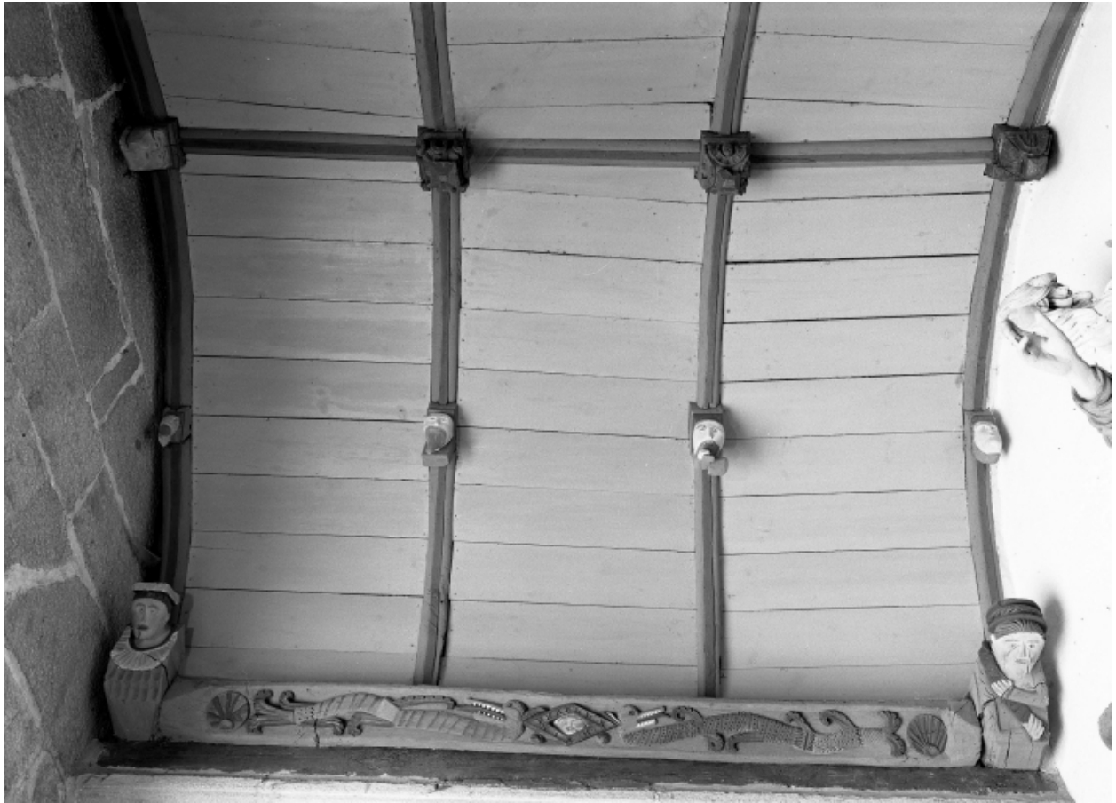
Plomodiern, église paroissiale Saint-Mahouarn : porche sud, lambris et sablière, côté ouest, état en 1970
