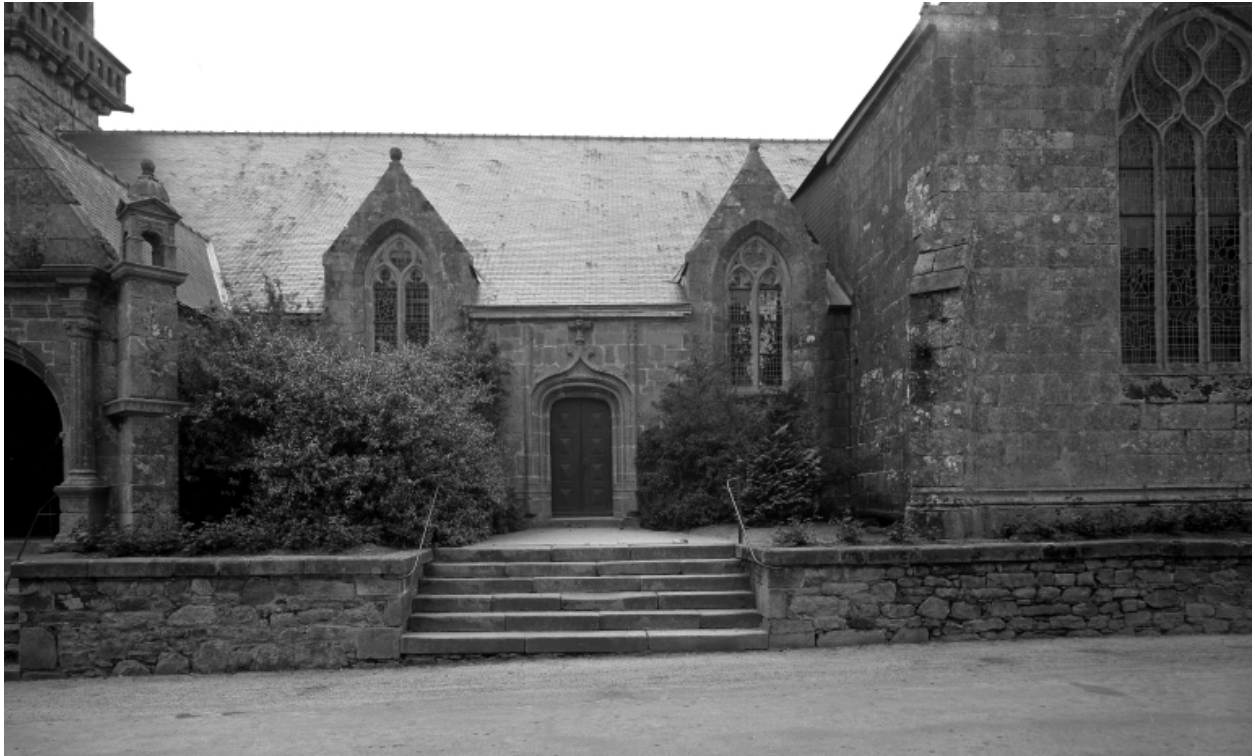
Plomodiern, église paroissiale Saint-Mahouarn : façade sud, partie droite de la nef, état en 1972
