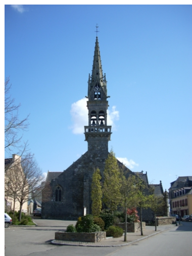
Plomodiern, église paroissiale Saint-Mahouarn : élévation ouest Phot. Gwénaél Fauchille IVR53_20082905657NUCA
