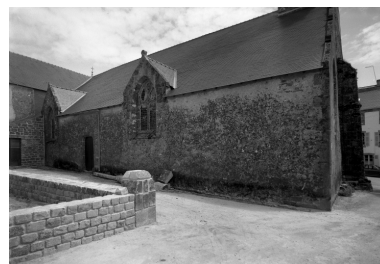
Plomodiern, église paroissiale Saint-Mahouarn : façade nord, mur du bas-côté, état en 1972
