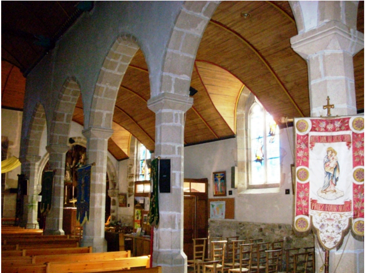
Plomodiern, église paroissiale Saint-Mahouarn : vue transversale sud-est
