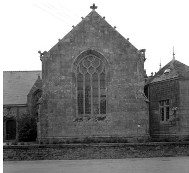
Plomodiern, église paroissiale Saint-Mahouarn : façade sud, pignon du transept, état en 1972 Phot. François Dagorn IVR53_19722900293V
