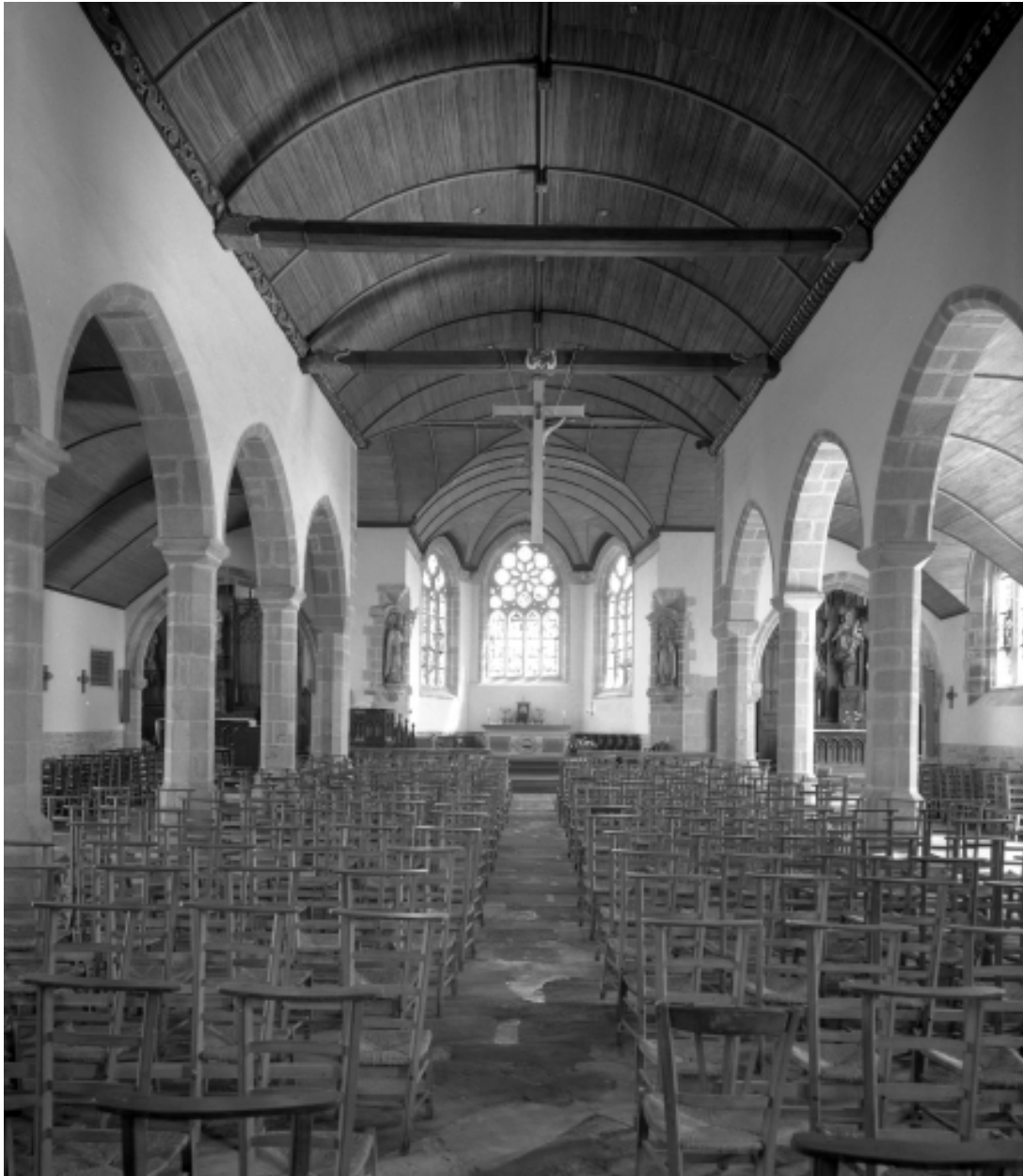
Plomodiern, église paroissiale Saint-Mahouarn : nef, vue générale vers l'est, état en 1970
