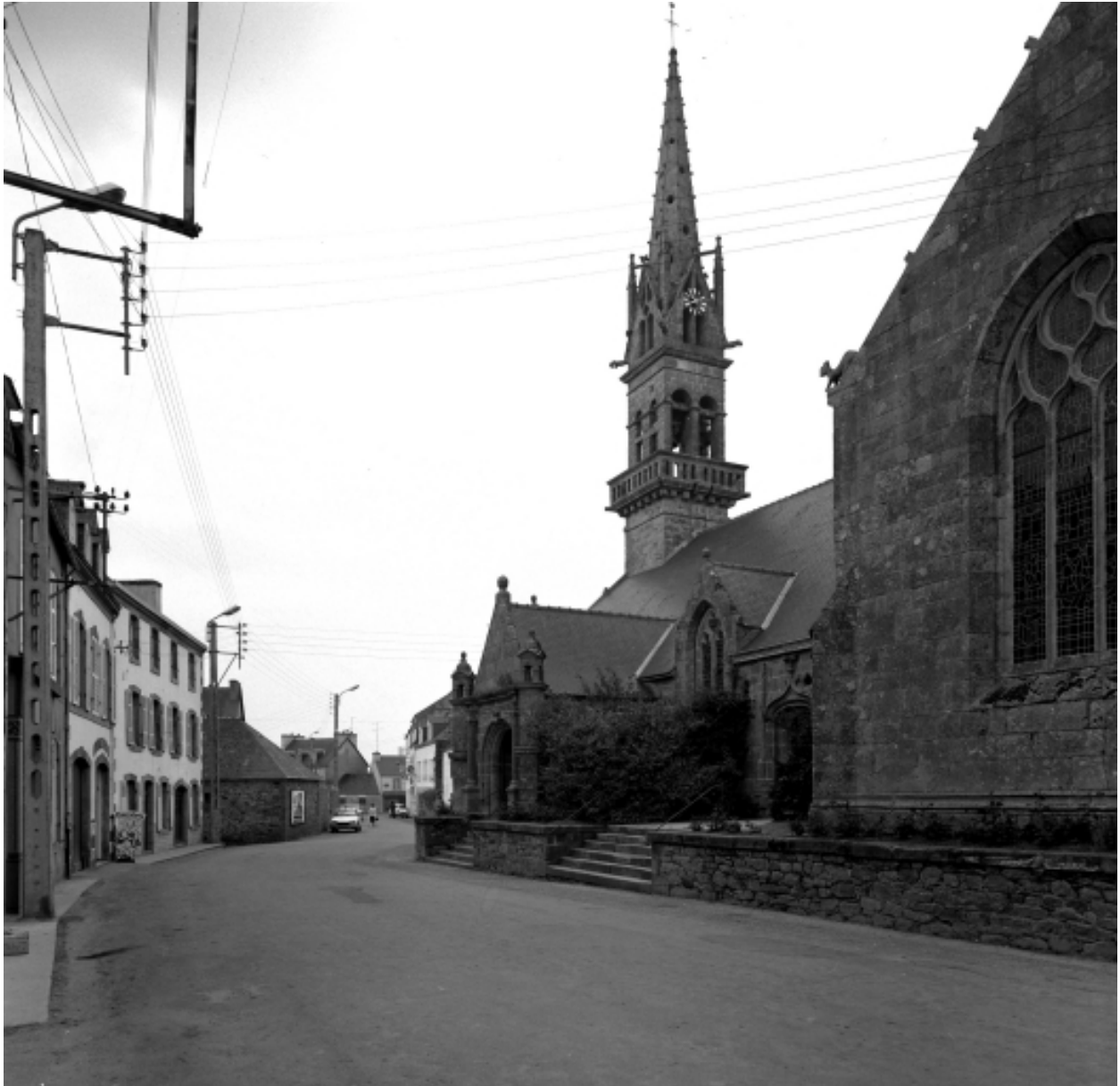
Plomodiern, église paroissiale Saint-Mahouarn : vue générale sud-est, état en 1972
