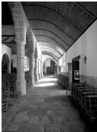
Plomodiern, église paroissiale Saint-Mahouarn : bas-côté sud, vers l'est, état en 1970 Phot. François Dagorn IVR53_19702900561V
