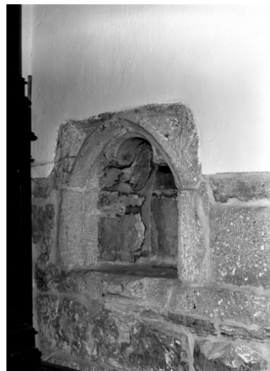
Plomodiern, église paroissiale Saint-Mahouarn : bras de transept sud, niche du mur sud, état en 1970 Phot. François Dagorn IVR53_19702900566V
