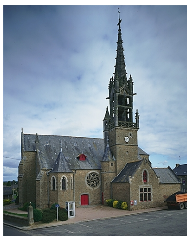
Vue générale sud-ouest Phot. Guy Artur, Phot. Norbert Lambart IVR53_19923500700VA
