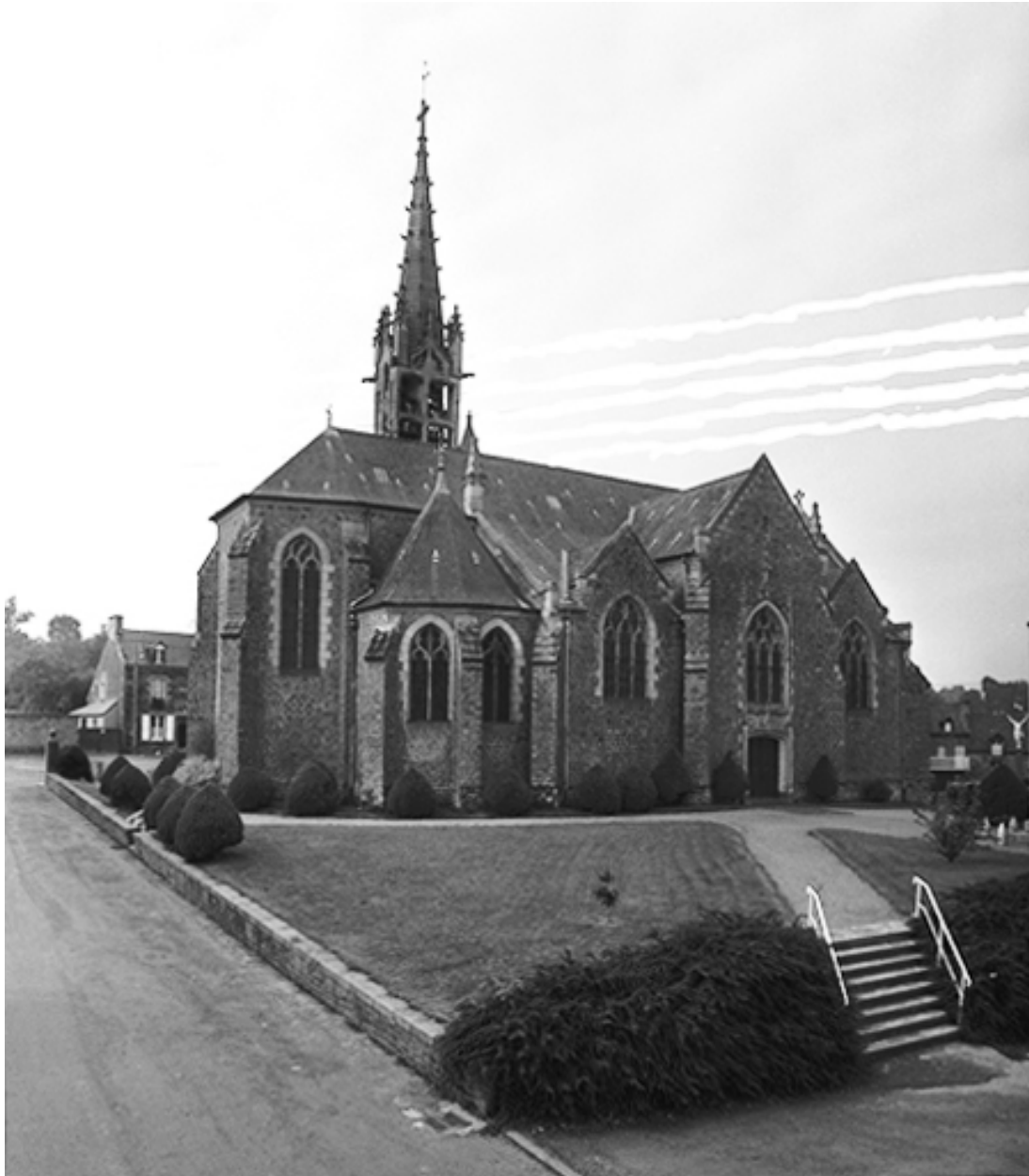
Vue générale nord-est
