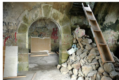
Vue du réduit de batterie de côte de Calgrac'h, casernements Phot. Guillaume Lécueillier IVR53_20062903356NUCA
