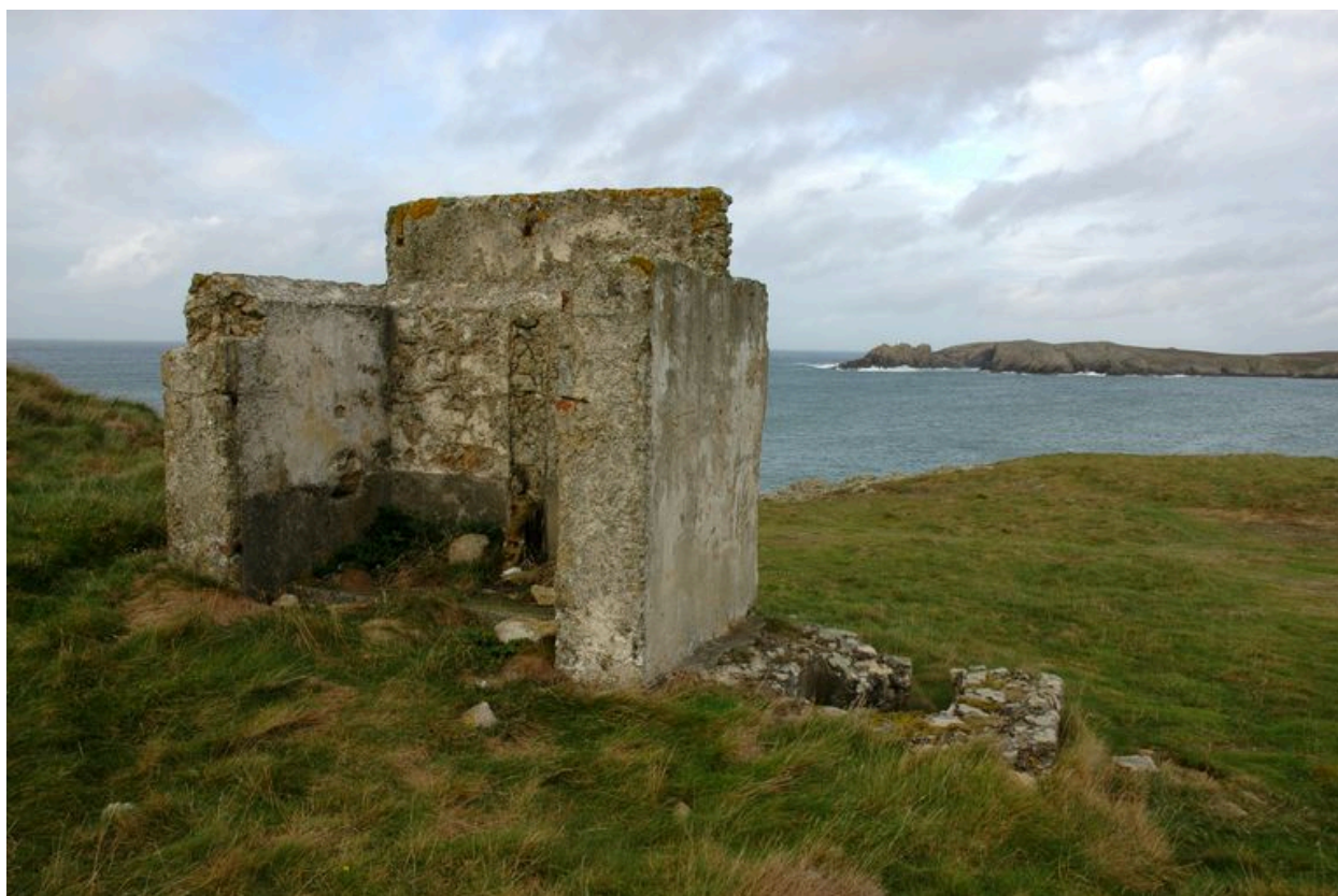
Vue des latrines extérieures du réduit de batterie de côte de Calgrac'h
