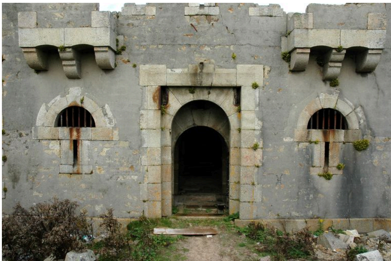
Vue du réduit de batterie de côte de Calgrac'h, façade sud, l'entrée
