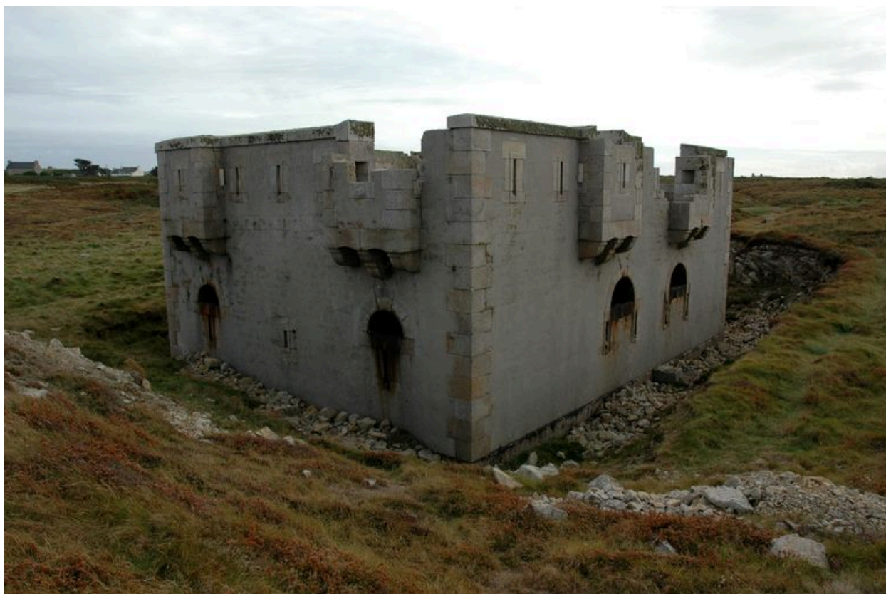
Vue du réduit de batterie de côte de Calgrac'h, angle nord-est
