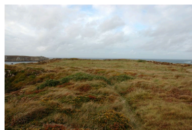
Vue générale de la batterie de côte de Calgrac'h Phot. Guillaume Lécueillier IVR53_20062903353NUCA
