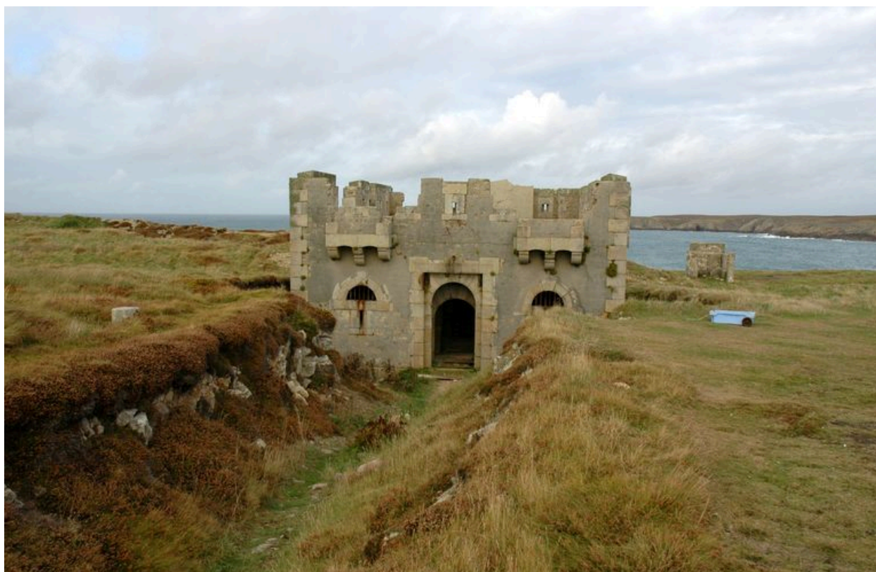
Vue du réduit de batterie de côte de Calgrac'h, façade sud
