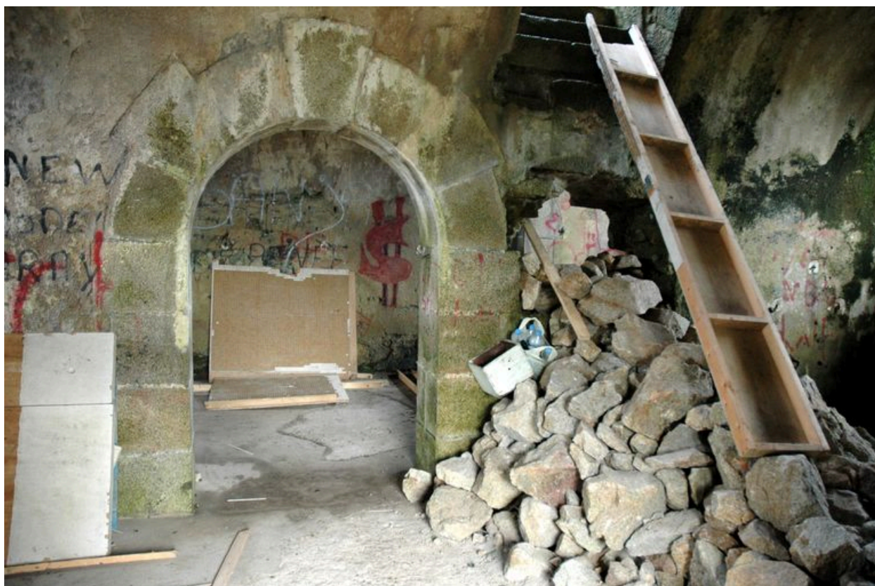
Vue du réduit de batterie de côte de Calgrac'h, casernements
