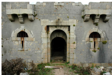
Vue du réduit de batterie de côte de Calgrac'h, façade sud, l'entrée Phot. Guillaume Lécueillier IVR53_20062903355NUCA
