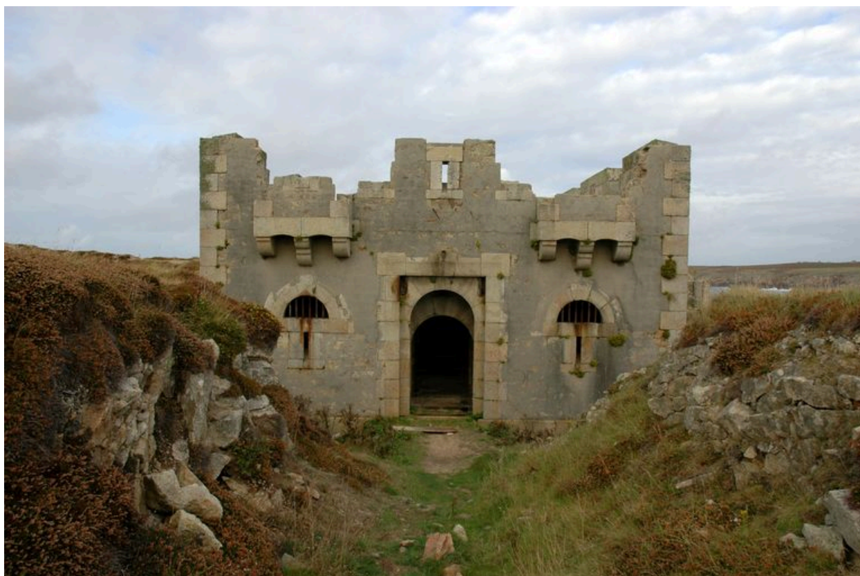
Vue du réduit de batterie de côte de Calgrac'h, façade sud
