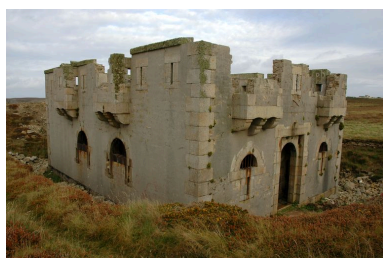
Vue du réduit de batterie de côte de Calgrac'h, angle sud-ouest Phot. Guillaume Lécueillier IVR53_20062903357NUCA
