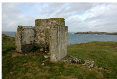
Vue des latrines extérieures du réduit de batterie de côte de Calgrac'h Phot. Guillaume Lécueillier IVR53_20062903359NUCA
