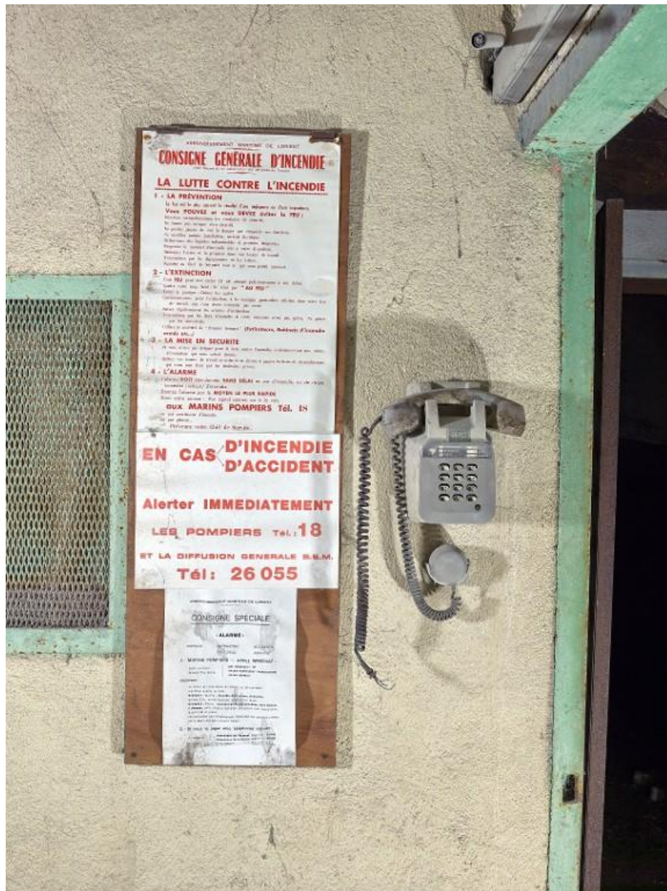
Vue du couloir d'accès : téléphone mural et signalétique en place en cas d'accident ou d'incendie
