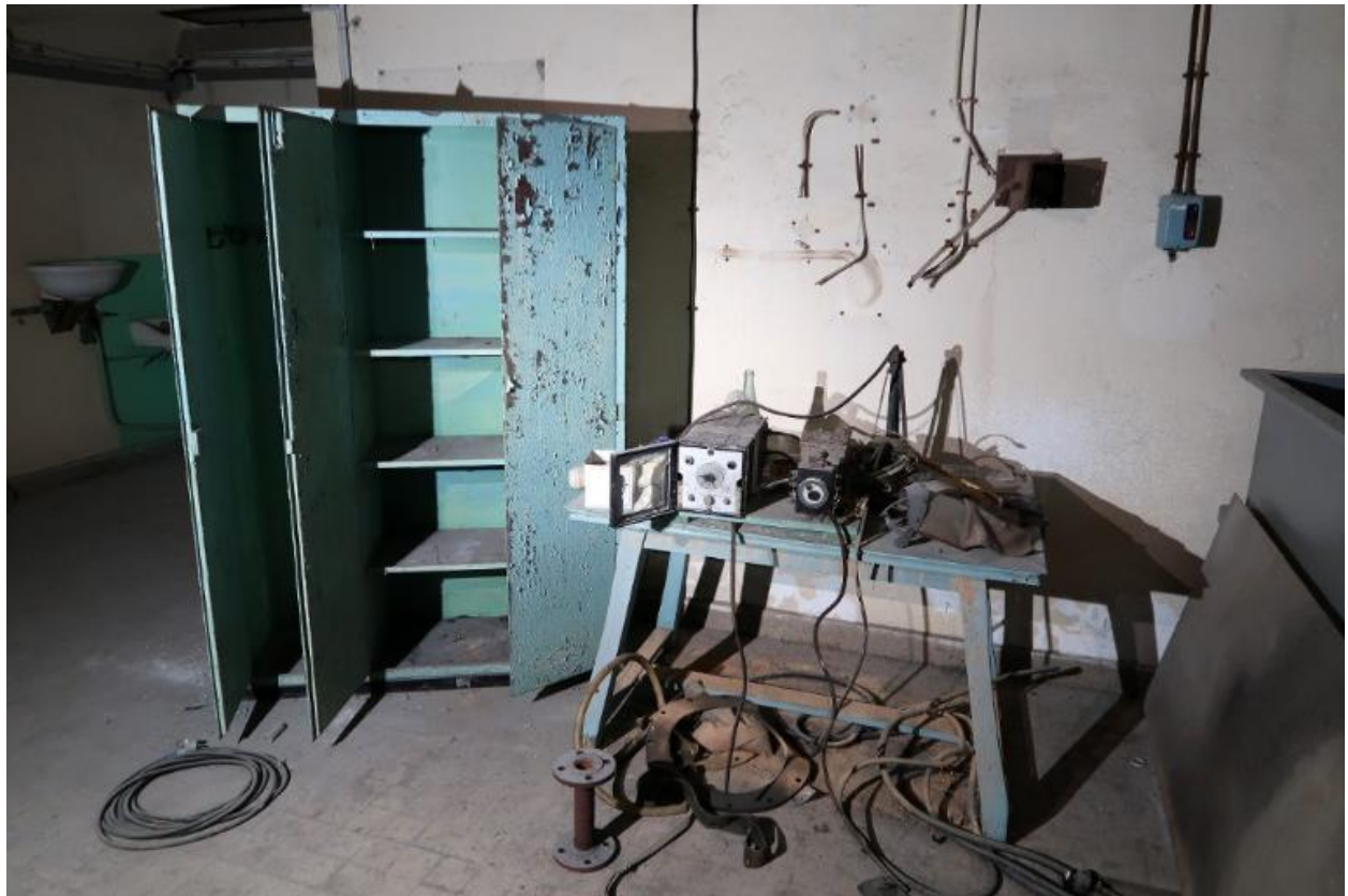
Vue de l'armoire d'atelier et de l'établi. Posés sur l'établi : appareil de mesure, carnet de bon de délivrance, feuille de suivi, gants étanches et divers objets et pièces...
