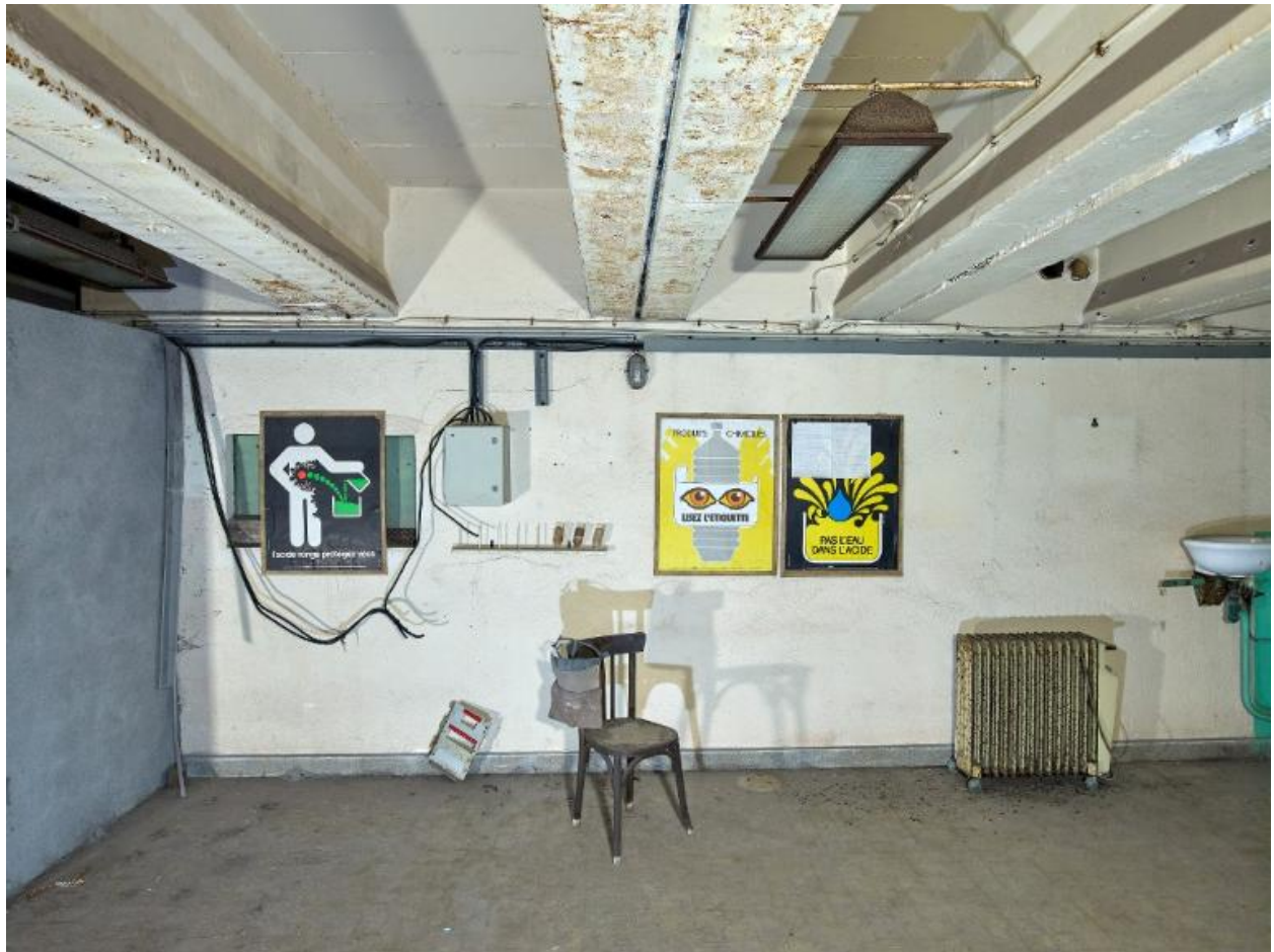
Vue des consignes de sécurité au travail affichées sur le mur. On peut lire : L'acide rouge, protégez-vous ; Produits chimiques. Lisez l'étiquette ; Pas d'eau dans l'acide. Le plafond est constitué de poutres préfabriquées en béton armé
