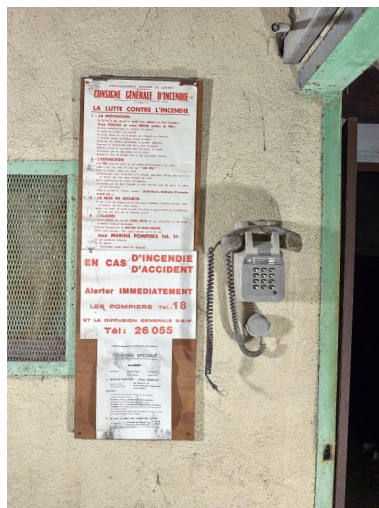
Vue du couloir d'accès : téléphone mural et signalétique en place en cas d'accident ou d'incendie Phot. Bernard Bègne IVR53_20235600766NUCA
