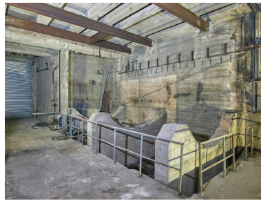
Vue de la salle du condenseur (fonction en 1945) puis atelier (fonction en 1965) dans l'extension sud : berceau en béton armé pour deux cuves (pour l'eau déminéralisée ?). Au fond de la pièce, le rideau métallique donne dans la rue située entre le bunker pour machines et le bunker KI Phot. Bernard Bègne IVR53_20235600167NUCA
