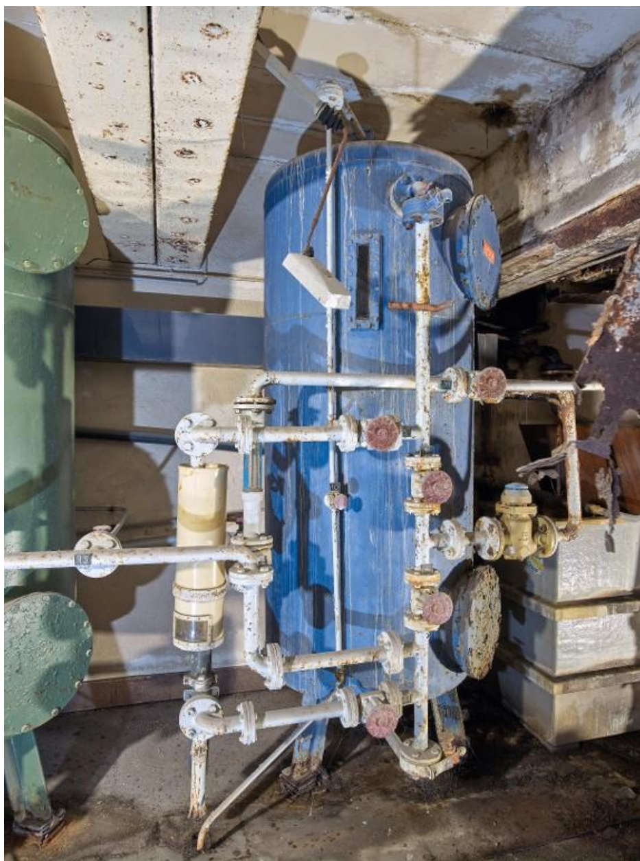
Vue de l'un des deux chambres avec une partie du système de tuyauterie. Le plafond est constitué de poutres préfabriquées en béton armé
