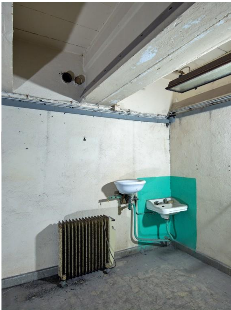
Vue de l'angle nord-est : lavabo et rince-oil muraux. Le plafond est constitué de poutres préfabriquées en béton armé avec plafonnier à lampe fluorescente. A gauche, radiateur électrique
