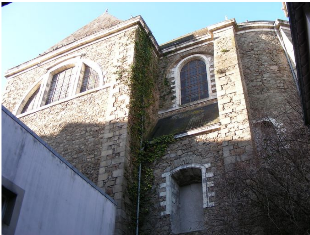
Choeur et transept, élévation latérale est.
