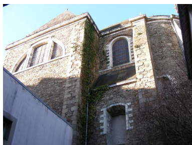
Choeur et transept, élévation latérale est. Phot. Catherine Toscer IVR53_20075605359NUCA
