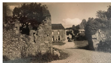
Porterie principale en ruine IVR53_20202208150Z
