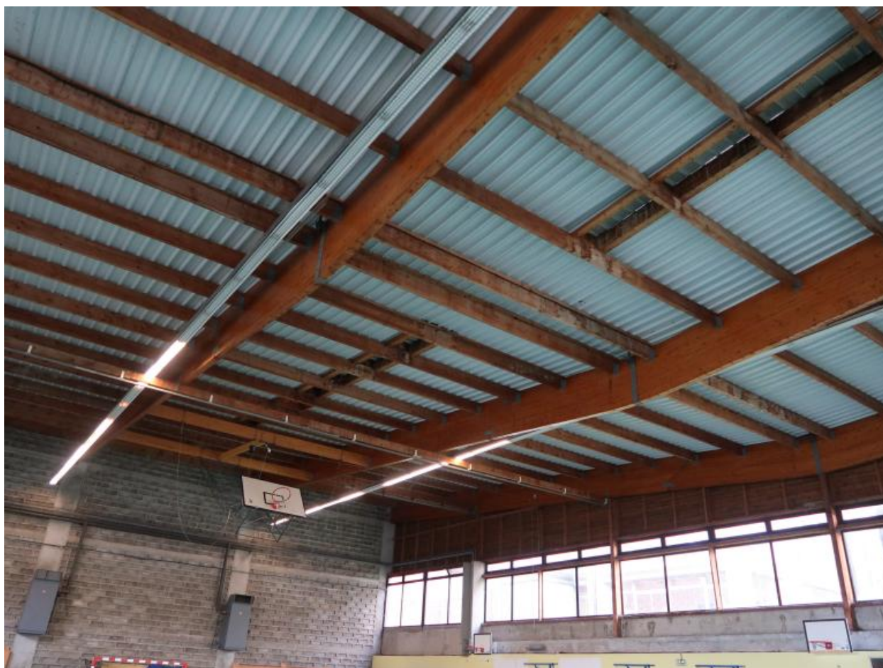
Détail de la charpente
