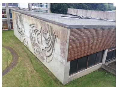
Vues prise du sud-est Phot. Simon Vely IVR53_20162206756NUCA
