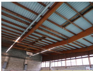
Détail de la charpente Phot. Thierry Goyet IVR53_20162206751NUCA
