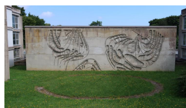
Façade sud sculptée par Bernard et Yvette Alleaume Phot. Thierry Goyet IVR53_20162206754NUCA
