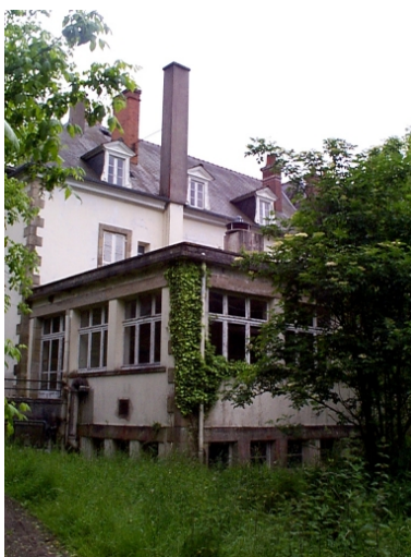
Détail : façade nord du château Phot. Claude Quillivic IVR53_20003508072NUCA
