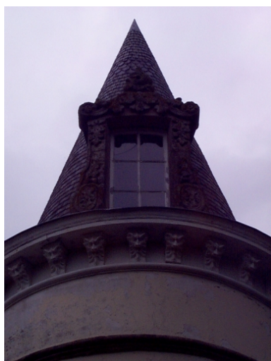
Une lucarne sur la tour est Phot. Claude Quillivic IVR53_20003508069NUCA
