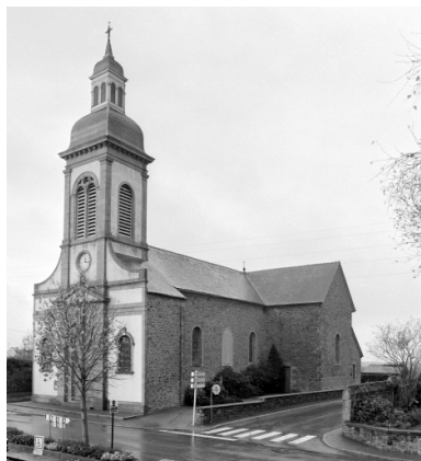
Elévation Sud-Ouest : vue générale
