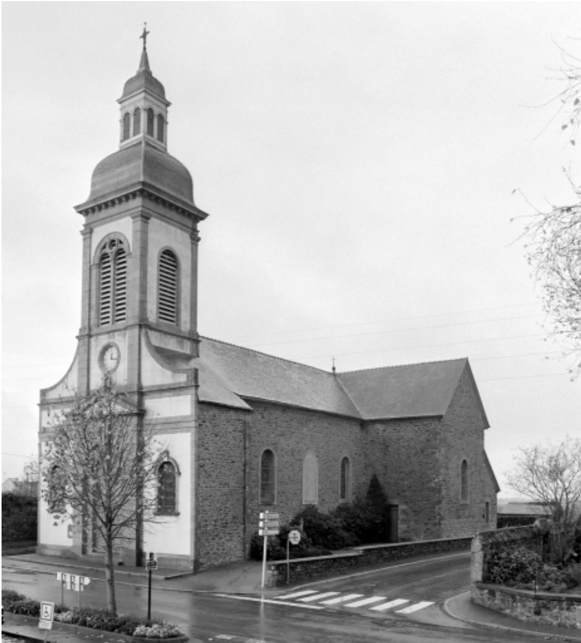
Elévation Sud-Ouest : vue générale
