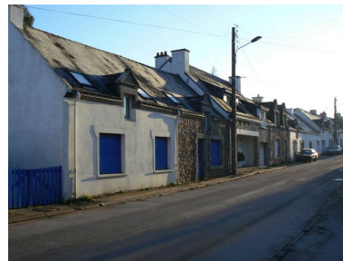
Maison de pêcheur du 14 et 16 rue de Port-Anna Phot. Johan Vincent IVR53_20075605744NUCA
